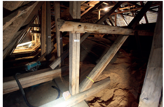
▲▲ Kuva 8. Näkymä etelän puoleiselta konttikäytävältä länteen päin. Katkaistut alapaarteet lepäävät ulomman ja sisemmän jalasparrun päällä. Jalasparrujen välissä ei ole täyttöä. Joka kolmannen kattotuolin alapaarre on tehty järeämmästä puutavarasta kuin muut alapaarteet. Kuva: Mia Puranen.
