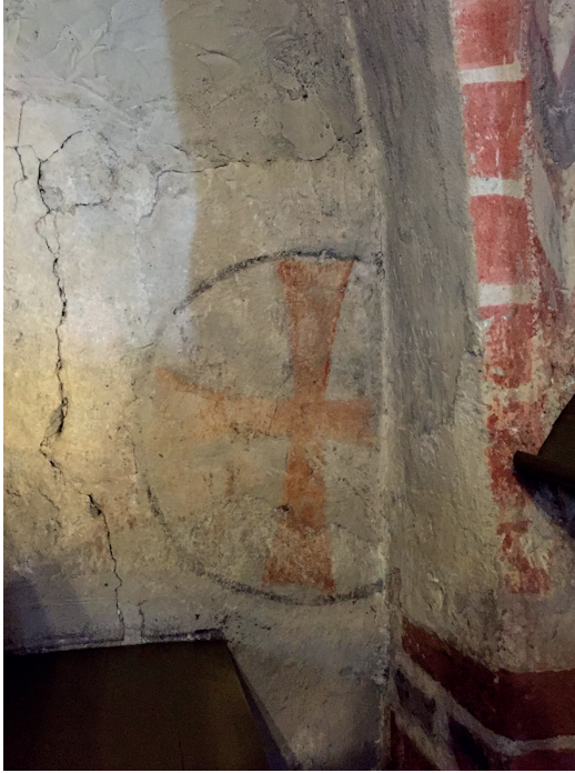
Kuva 13. Holvien pilasterien lisääminen kirkkosaliin näkyy myös seinien maalauksissa. Parvella kirkon seinään maalattu vihkiristi on jäänyt osittain pilasterin taakse. Kuva: Marko Huttunen.
