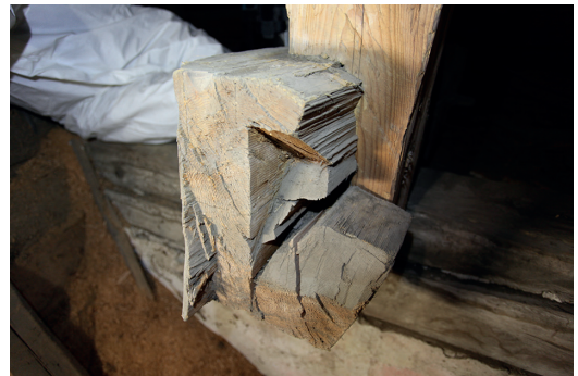
▲▲ Kuva 10. Alapaarteiden katkaisemisen yhteydessä kattotuoleja vahvistettiin vastakkaiset konttipuut yhdistävällä vetoparrulla. Liitosten pitkiksi jätetyt tammitapit poikkevat puulajiltaan kattorakenteen muusta puutavarasta. Kuva: Mia Puranen.
