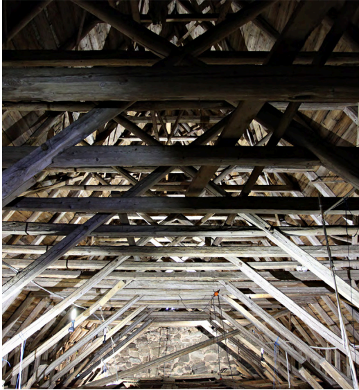
Kuva 8. Keminmaan vanhan kirkon 1550-luvun vesikattorakenteita. Kuva: Livady.
