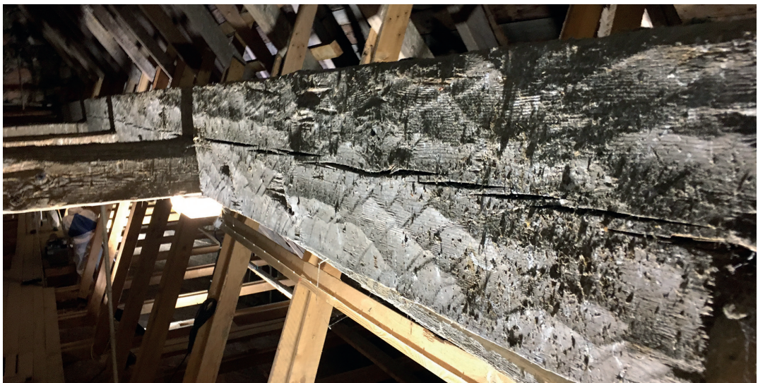
Kuva 7. Pohjan kirkon ullakolla olevan kierrätyspalan, aiemman puukirkon alapaarteen, veistöjälki poikkeaa huomattavasti 1470-luvun kattorakenteiden veistöjäljestä. Kuva: P. Savolainen.
