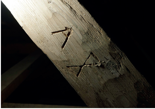
Kuva 8. Tekijämerkki Pohjan kirkon kattotuoleissa. Kuva: M. Tolonen.
