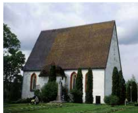
Pyhtään kirkon eteläjulkisivu. Asehuone on muutettu 1670-luvulla Creutzin suvun hautakappeliksi. Ulkoseinissä on keskiaikaisperäinen rappaus ja kalkkisively. Kuva: teoksesta Hiekkanen 2014, 465.
