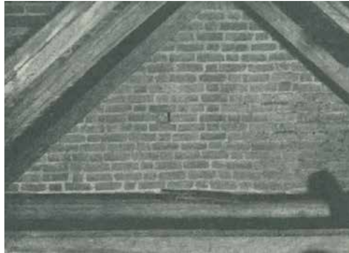
Alkuperäinen, rappaamaton runkokuoneen eteläseinän tiilipinta katsottuna asehuoneen vintiltä. Kuva: teoksesta Kartano 1948, 100.
