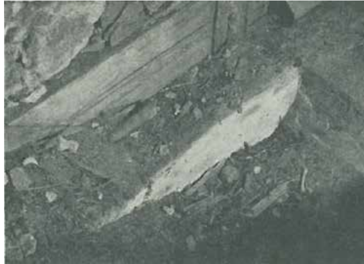
Kirkon ullakolla näkyy holvien välisessä tilassa vanhaa rappauserrosta. Kuva: teoksesta Kartano 1948, 97.
