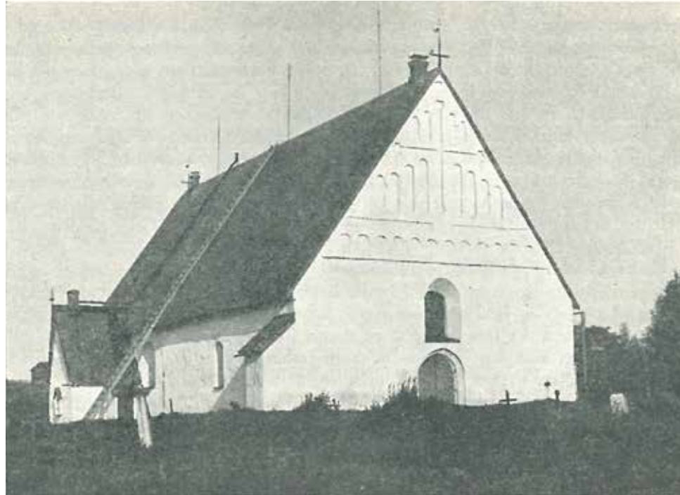
Pernajan kirkko kuvattuna luoteesta. Kuva on otettu ennen vuotta 1938. Sakastin ja runkohuoneen katoilla on vielä savupiiput. Kuva: teoksesta Kartano 1948, 86.
