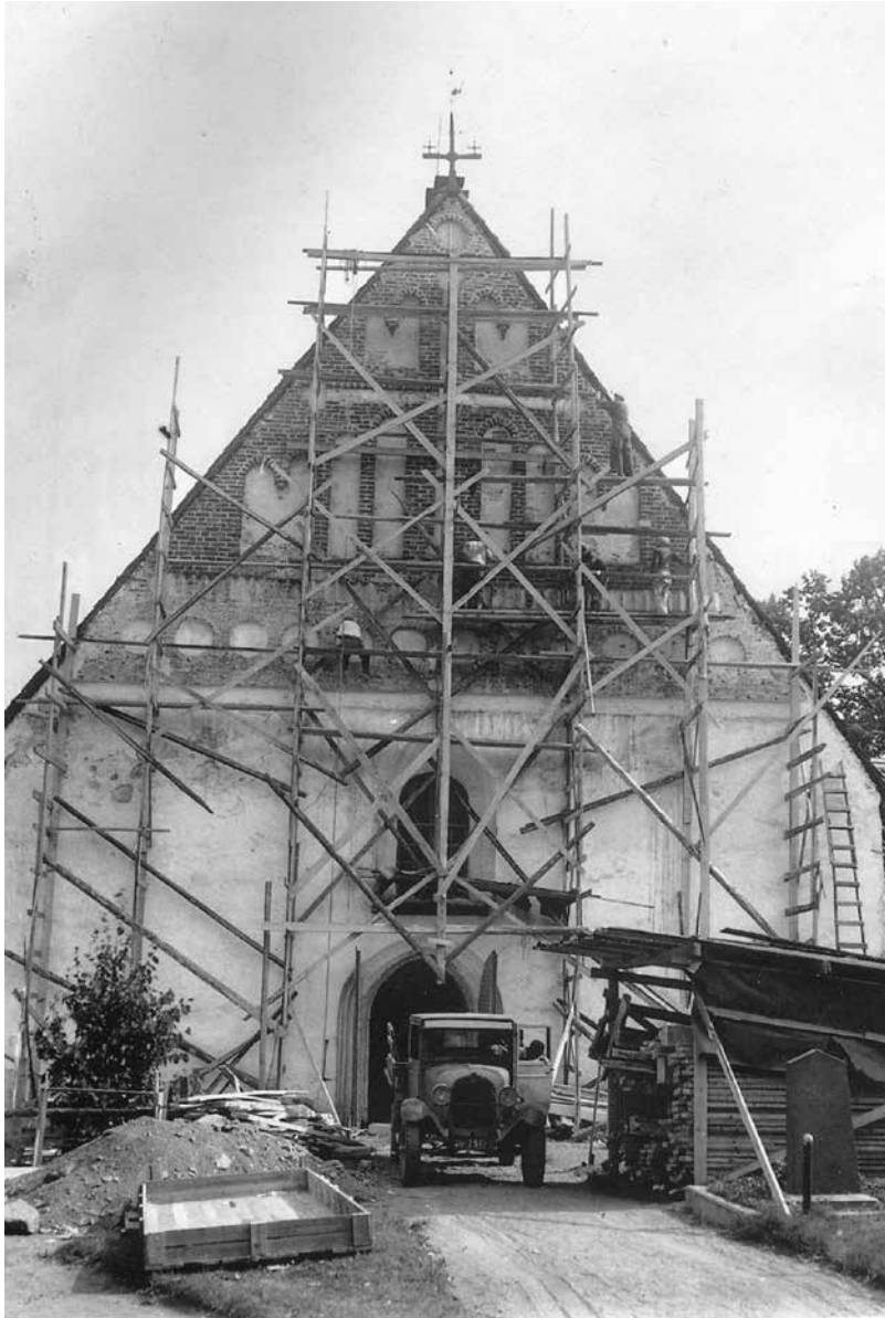
Pernajan kirkon valkoiseksi rapatun tiilipäädyn rappaus hakattiin alas vuonna 1938. Kuva: Teoksesta Valkeapää 2000, 50. Alkuperäinen kuva: Museoviraston käsiarkisto.
