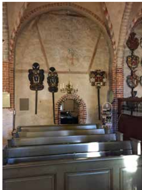
Pernajan runkokuoneen pohjoisseinässä näkyy 1410-luvulla rakennetun sakastin vesikattoparruja yläpuolisen holvin ollessa 1440-luvun alkupuolelta. Teksti: Markus Hiekkänen 1995. Helsingin pitäjä 26, 14. Kuva: Livady 2016.
