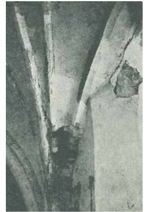
"Alkuperäisen länsipäädyn ikkunan suhde vie-reiseen holviin. Huomaa hirren pääty ja tämän ja kilpikaaren liitos." Teksti ja kuva: Kartano 1948, 98.
