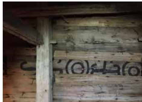
Maalaus Pernajan kirkon asehuoneen kattolaudassa. Kuva: Livady 2016.
