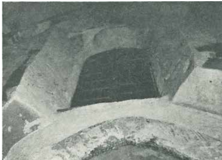
Länsipäädyn ikkuna alhaalta päin katsottuna sekä ovisyvennyksen leikattu segmenttikaari. Kuva: teoksesta Kartano 1948, 99.
