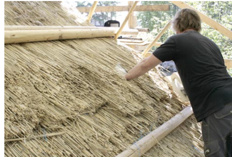
Uusi kerros tasoiteltiin ensin karkeasti käsin ja lopullinen pinta tehtiin tamppilautaa käyttäen.
