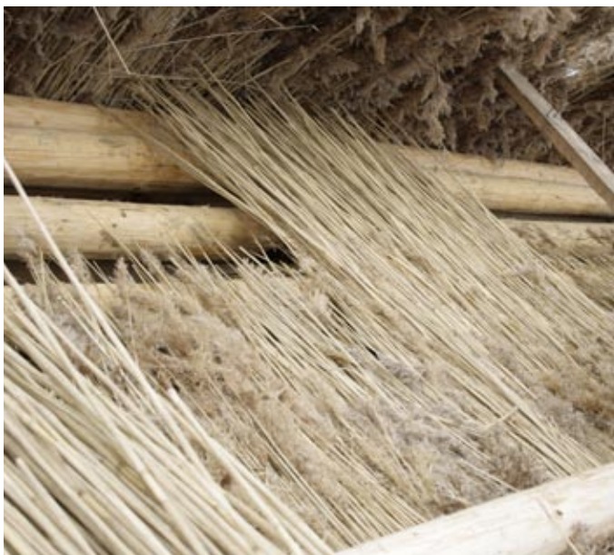
Katkaistuja ruokoja merenpuoleisella lappeella lähellä harjaa.
