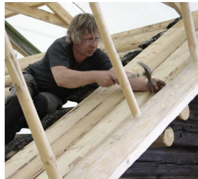
Rannan puoleisille päätyräystäille tehtiin kokonaan uusi aluslaudoitus.
