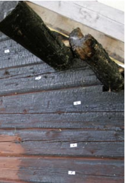
Päädyjen hirret merkittiin ennen purkamista.
