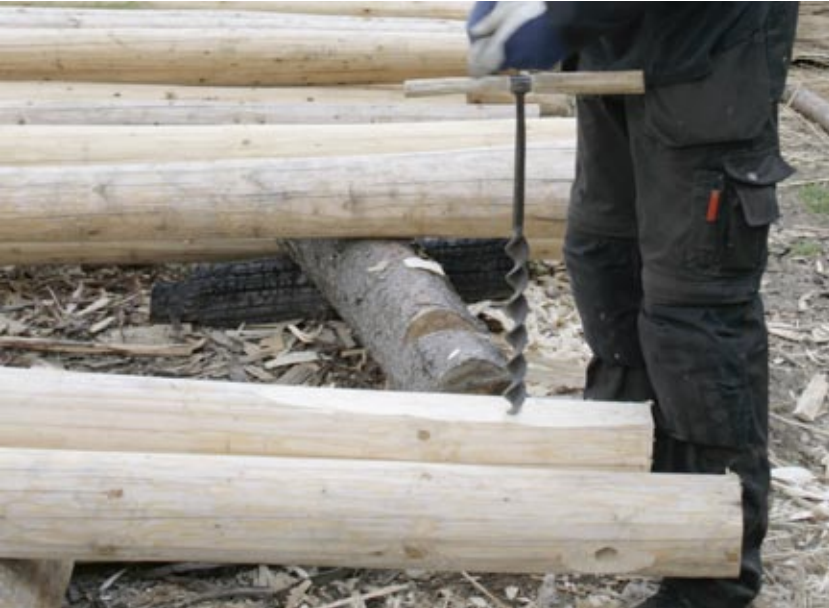
Poikittaisten painopuiden päihin kairattiin reiät katajatappiitosta varten.
