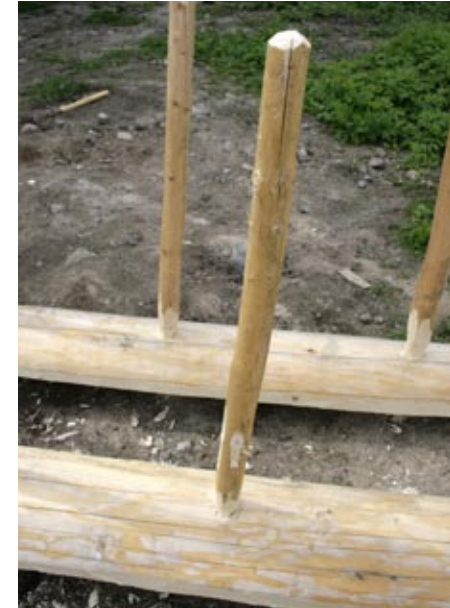
Tappeja paikoilleen asetettuina.
