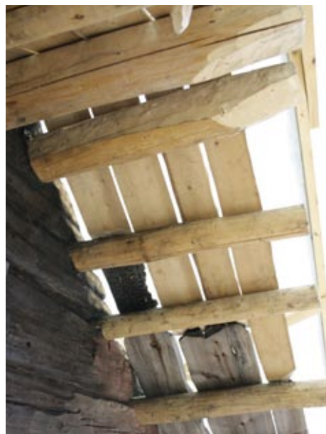
Jatkettuja räystäslautoja itäpäädyssä.
