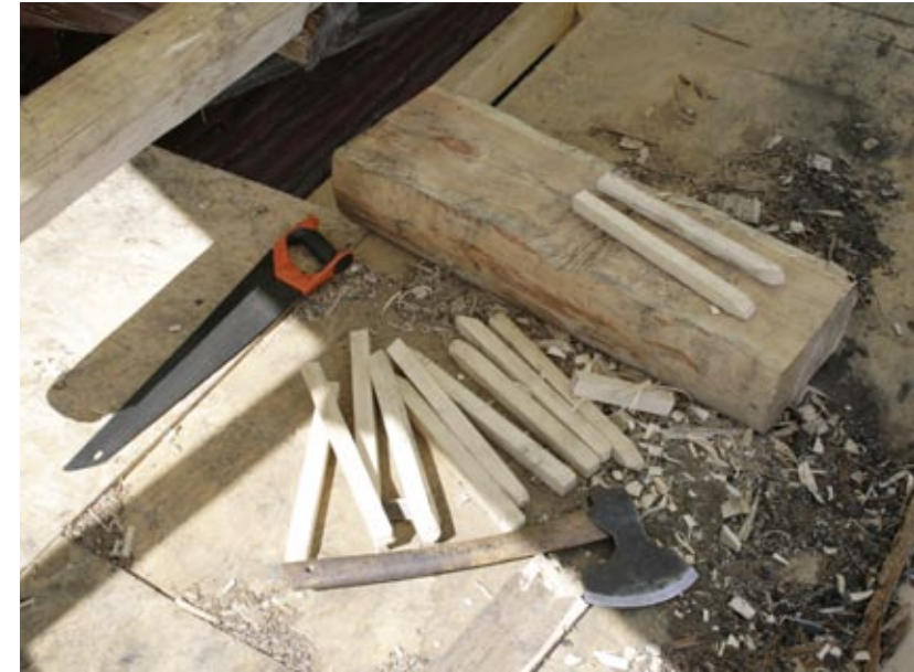
Tapit valmistettiin pääasiassa 28 x 28 mm höylätystä mannystä. Tapit veistettiin sopiviksi 32 mm reikiin.
