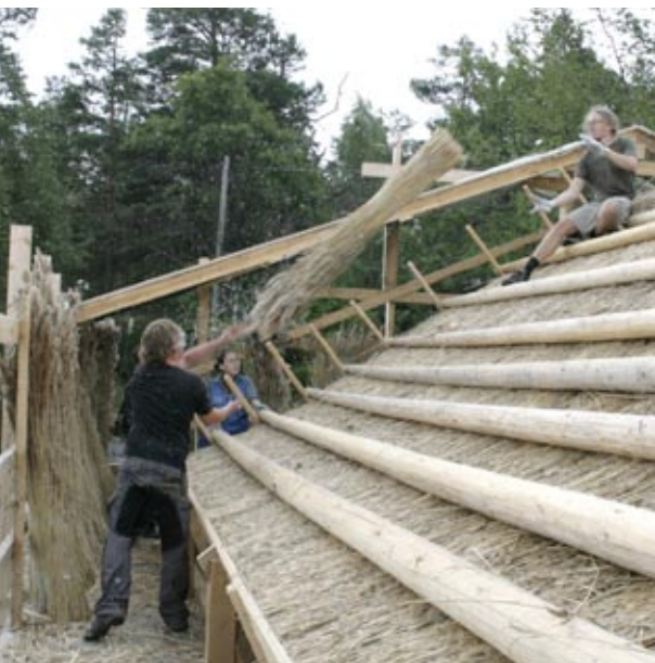
Ruokojen latomista jatkettiin taivutettujen latvojen päälle kunnes meren puolen ruo'ot ylettyivät tarpeeksi harjan yli ja ne voitiin taivuttaa.
