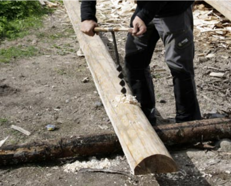
Halaspuolikkaisiin tehtiin reiät tappeja varten käsin kairaten.
