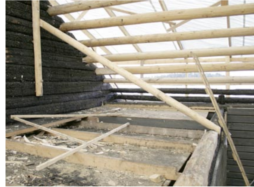
Länsipäätä tukemaan asennettiin vinopuu.
