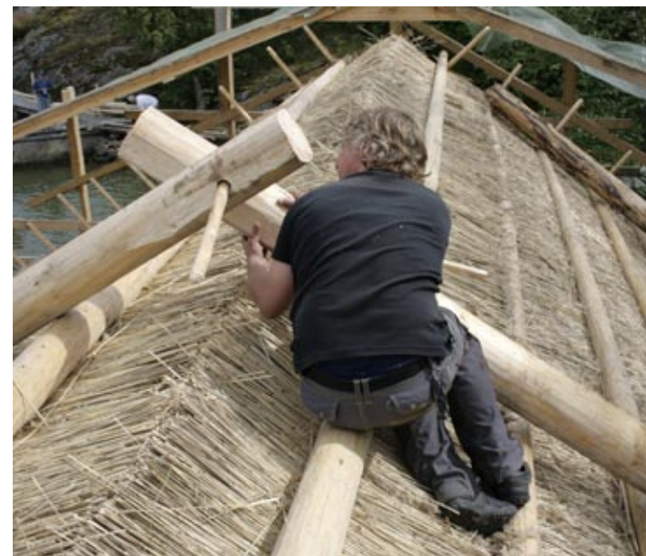
Painopuut kiinnitettiin aluksi väliaikaisin tapein, jotta tarvittaville loveuksille voitiin määrittää paikat.
