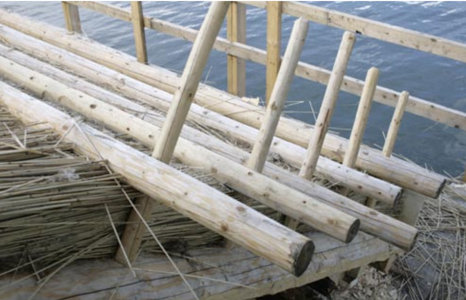
Pitkittäisiä painopuita paikoilleen asennettuna.
