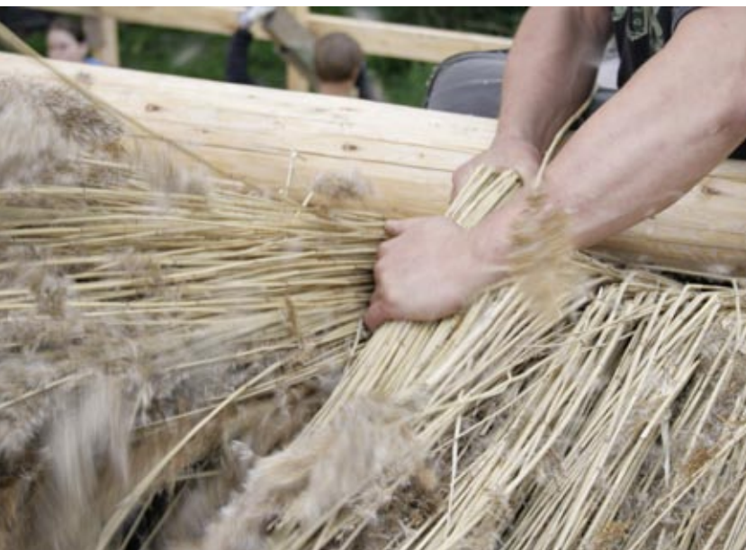
Ennen merenpuoleisen lappeen viimeisten ruokokerrosten latomista rannan puolelta harjan yli työntyvät latvat taivutettiin meren puolelle.
