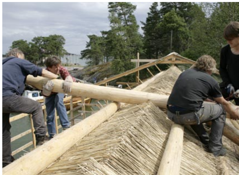
Merenpuoleiset poikittaiset painopuut nostettiin harjan yli.
