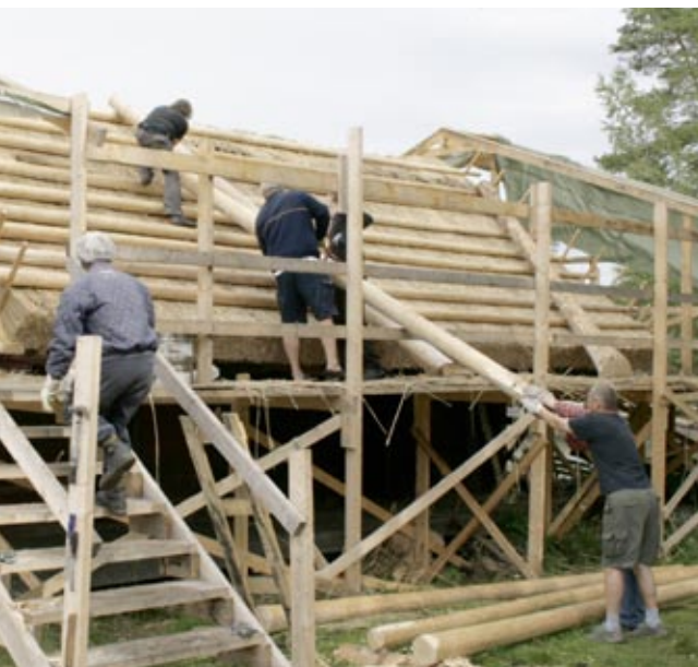
Painopuuta nostetaan katolle.
