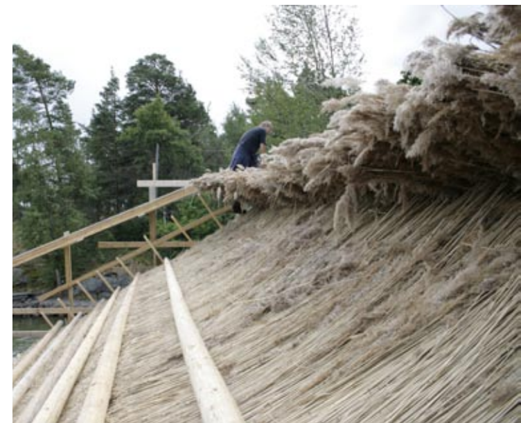
Merenpuoleinen lape juuri ennen rannan puoleisten ruokojen taivuttamista harjan yli.
