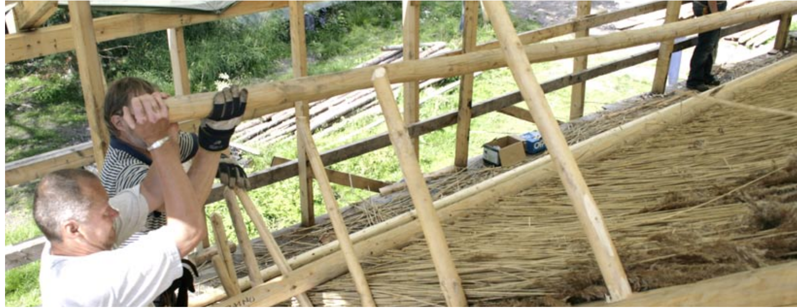
Painopuuta nostetaan paikoilleen.
