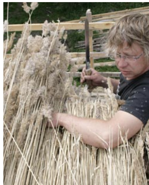
Ruokojen päät leikattiin, jotta kukinnot eivät jäisi näkyviin katon pinnallae.
