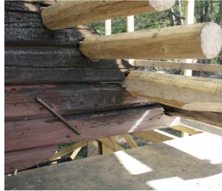
Päätyjen konsoleita tuettiin terässitein.
