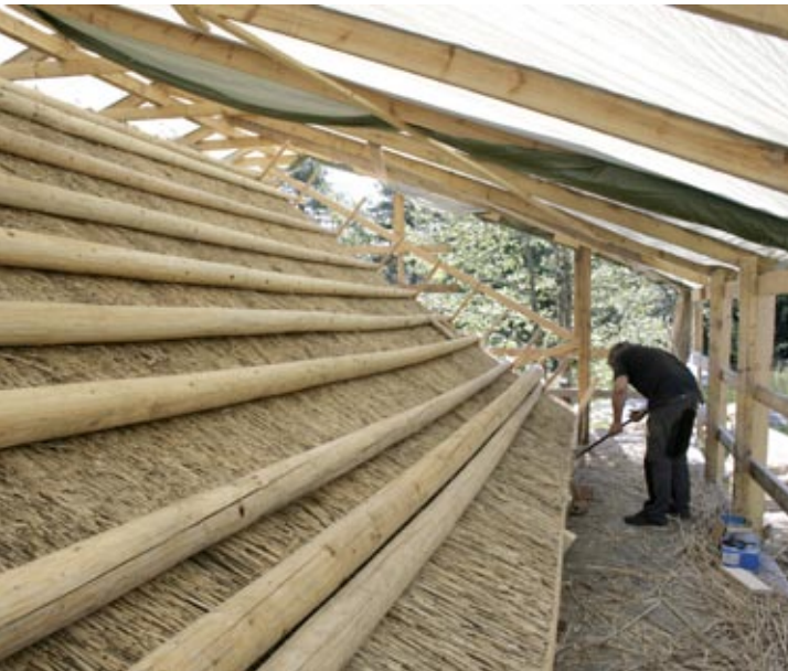
Muottilauδοitus rannan puolelta purettiin, kun lape oli ladottu valmiiksi.
