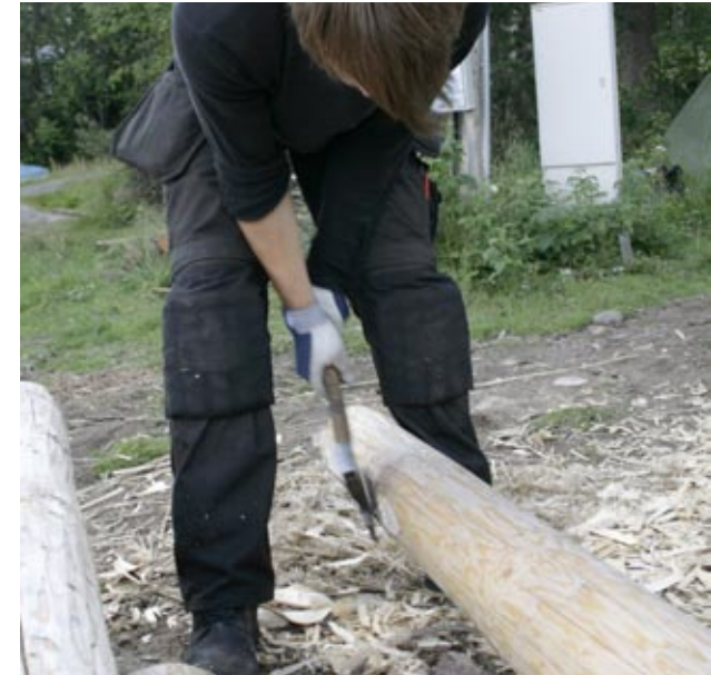
Poikittaisten painopuiden liitoskohdat valmisteltiin maassa.
