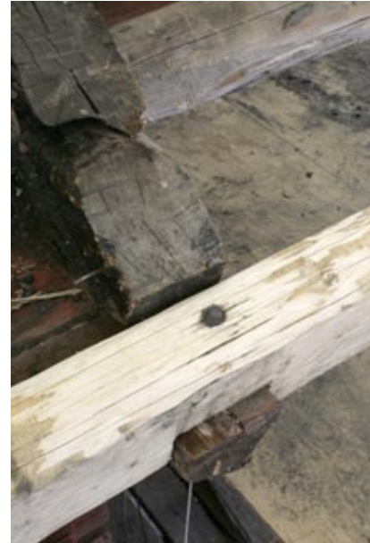
Siihirret kiinnitettiin paikoilleen takonauloja käyttäen.
