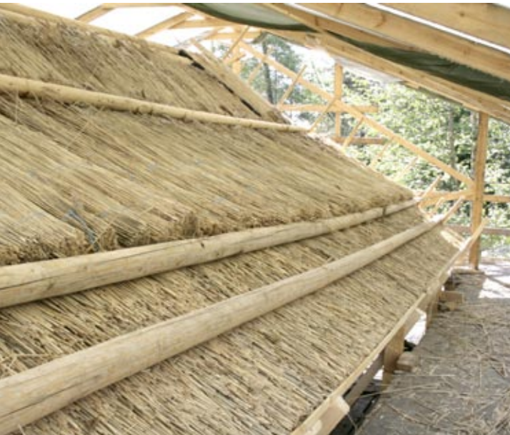
Uusi kerros ruokoa ladottiin painopuuta vasten.
