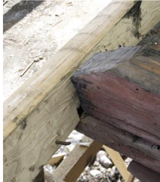
Meren puolen uusi sihirsi paikoilleen asennettuna.
