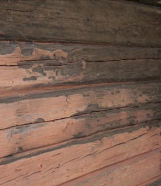
Pentala ranta-aitan hiiltynyt ulkopinta rapsutettiin puhtaaksi.
