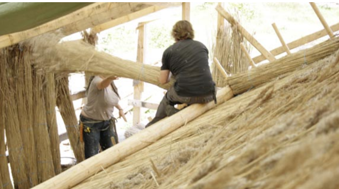
Painopuut toimivat myös telieinä työn aikana.
