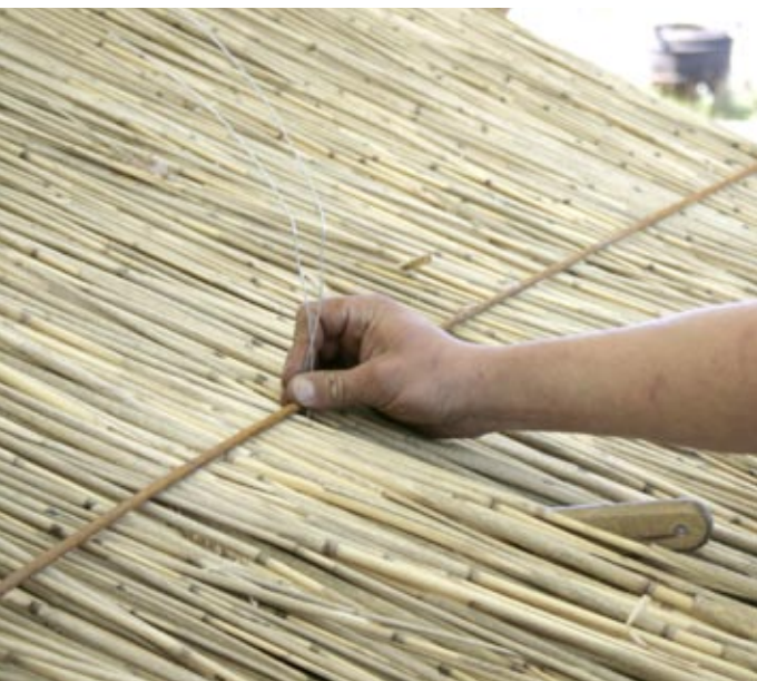
vuoliaiseen ruuvilla kinnitetty teräslanka väännettiin lenkiksi.
