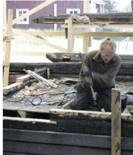
Säästettävä hirren osa tapitettiin alempaan hirsikertaan.
