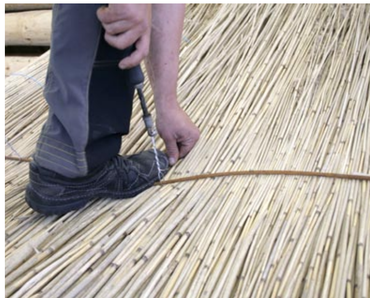
Teräslanka kiristettiin ruuvipumpulla samalla kun ruokoja painettiin jalalla alaspäin.
