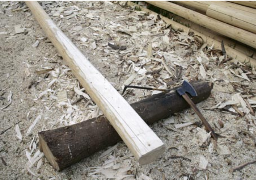
Uudet vuoliaiset esityöstettiin maassa.
