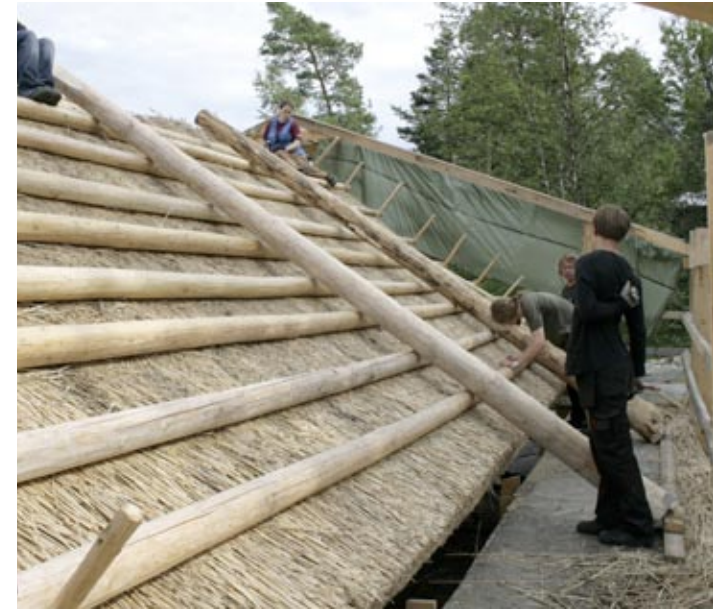
Ruokojen valumiselta räystäällä välttyttiin, kun poikittaiset painopuut tuotiin paikoilleen vaikkei niitä voitukaan vielä asentaa lopullisesti.
