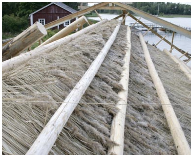
Taivutettujen ruokojen päät painettiin alas painopuitten avulla.
