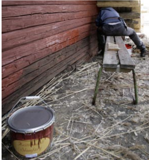
Seinät maalattiin ulkoa punaisella keittomaalilla.
