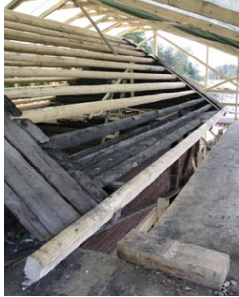
Meren puoleisella lappeella säilytettiin kaksi alkuperäistä vuoliaista.
