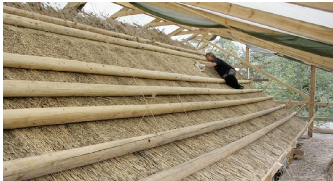
Pintaa tasoitettaessa on tärkeä seurata, että katon pinta pysyy linjassa.
