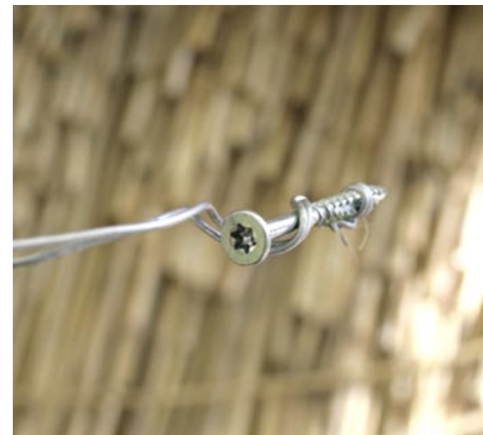
Harjateräksen kiinnitysruuvi.
