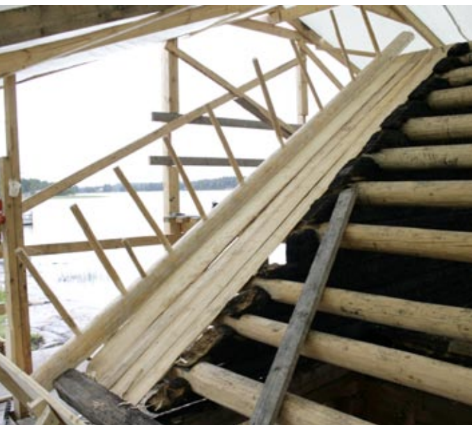
Sarvilauta paikalleen asennettuna. Kuvassa näkyy myös päätyräystäään uudet aluslaudat.
