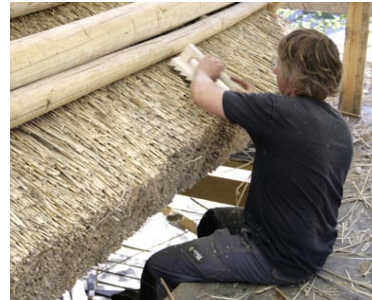
Myös katon yläpinta räystäällä tiivistettiin muottilauδοituksen purkamisen jälkeen.
