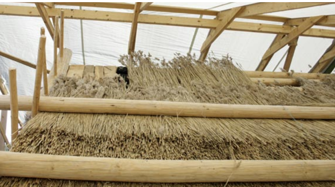
Katon alapinnan siistimiseksi latvojen alle laitettiin tarvittavissa kohdissa ohut kerros ruokoa. Näin latvojen röyhyt eivät pääse roikkumaan vuoliaisten väleistä.
