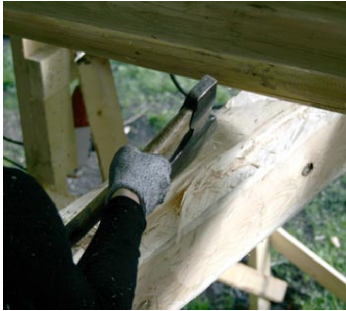
Uuden konsolin yläpinta muotoiltiin räystäslautojen asentamista varten.
