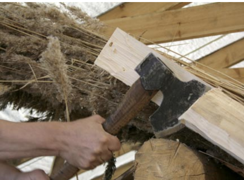
Harjalla molemmista sarvilautoista veistettiin puolet pois.
