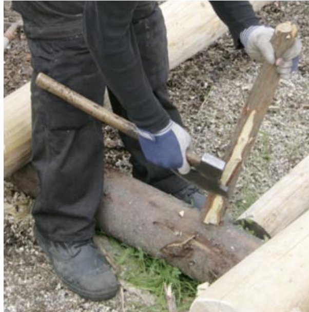
Tapit poikittaisten painopuiden harjaliitosta varten valmistettiin katajasta.
