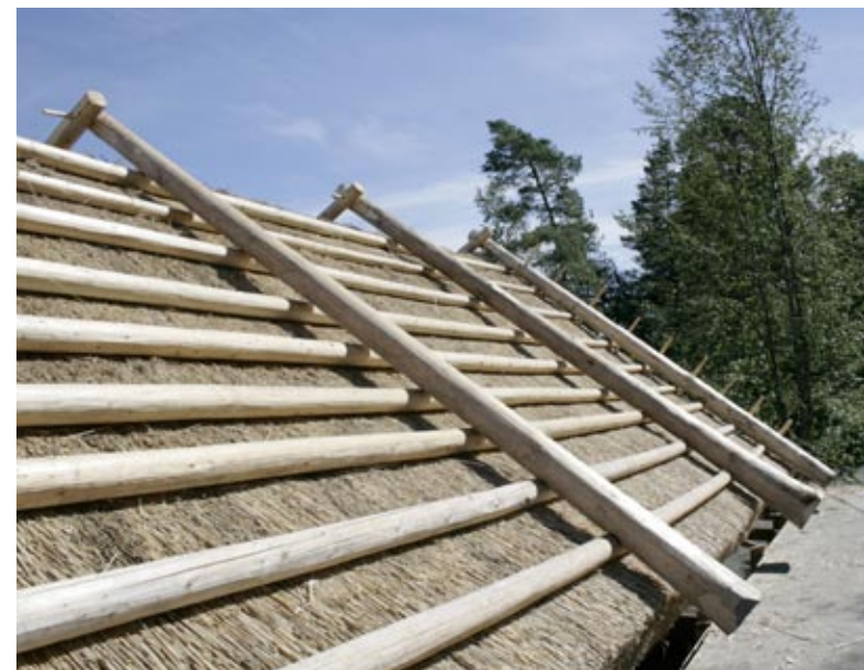
Painopuiden asentamisen jälkeen katto oli valmis.
