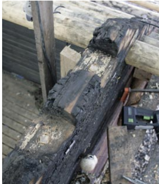
Rakenteen tukevoittamiseksi hirsipäädyt tapitettiin siten, että jokaiseen hirteen tuli kaksi tappia.
