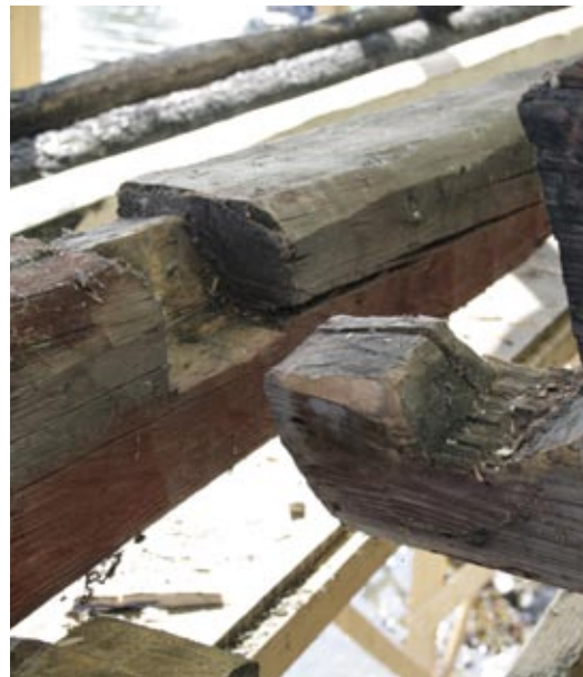
Meren puolen siihirren liitos avattuna.
