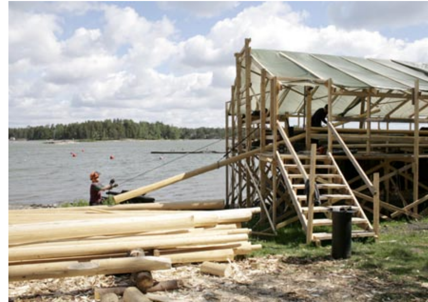
Vuoliaista nostetaan paikoilleen.
