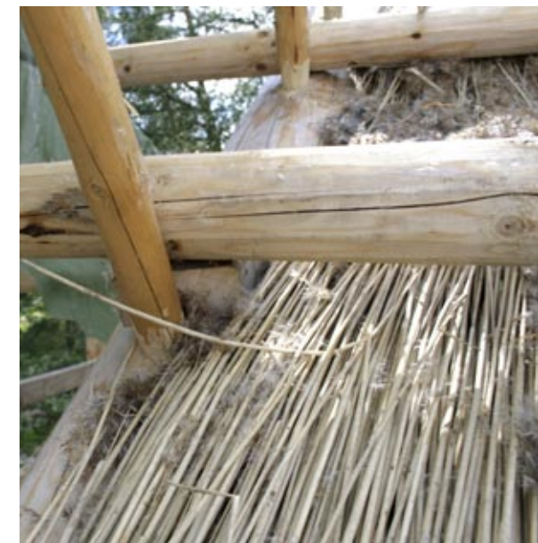
Alinta taivutettujen latvojen päälle asetetuista painopuista korotettiin sen verran, että seuraavan kerroksen ruokoniput saatiin pujotettua sen alle.
