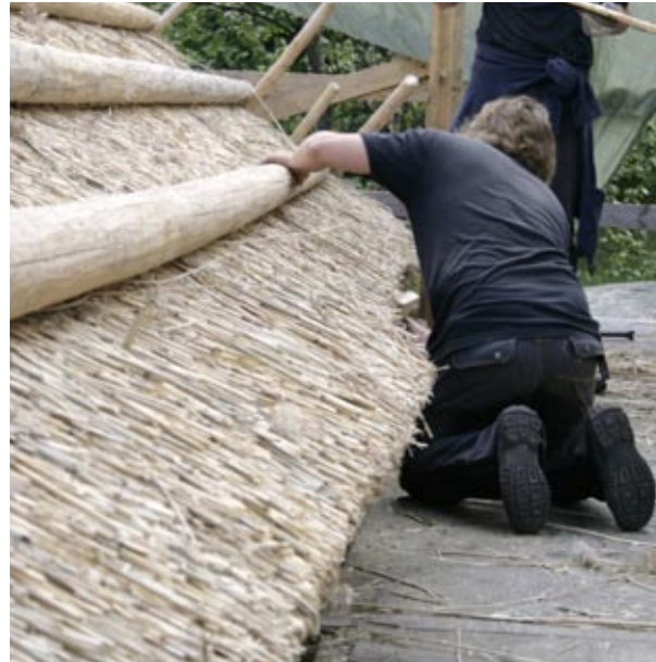
Räystään valuma korjattiin tiivistämällä se uudestaan tamppilautaa käyttäen.
