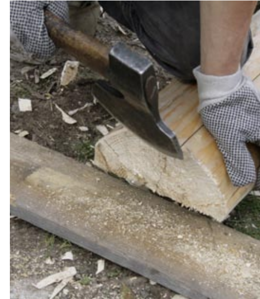
Halaspuolikkaidet päät veistettiin, jotteivat ne imisi niin hanakasti vettä.
