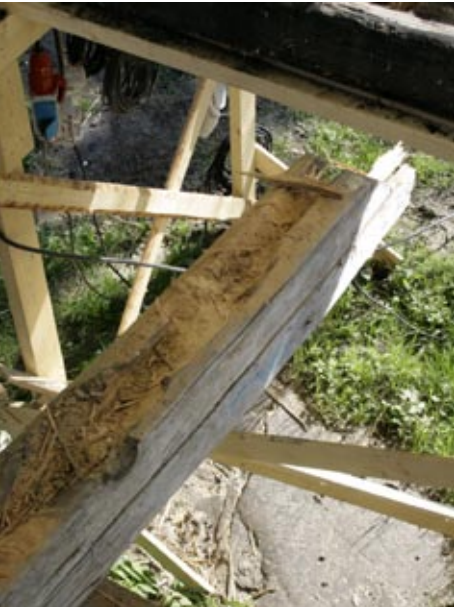
Väliseinän ylimmän hirren rannan puoleinen pää jouduttiin uusimaan lahovaurion vuoksi.
