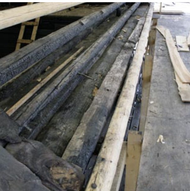
Merenpuoleiselle pitkälle räystäälle tehtiin reunimmainen lauta vanhasta lattialankusta.
