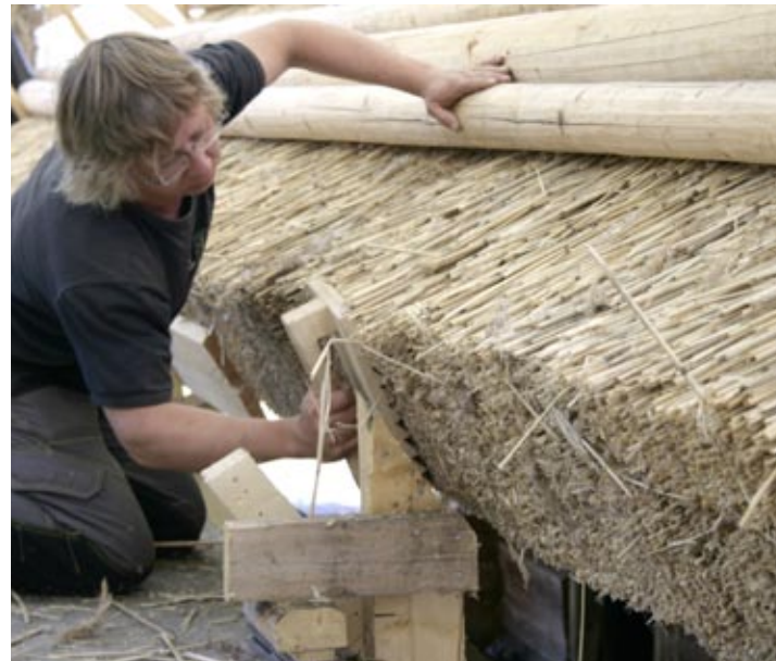
Muottilauδοituksen purkamisen jälkeen räystääs tiivistettiin lyöden ruokoa sisäänpäin tamppilaudalla.
