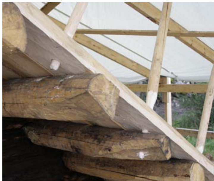
Jokainen sarvilauta kiinnitettiin parilla vuoliaisen läpi lyödyllä tapilla.
