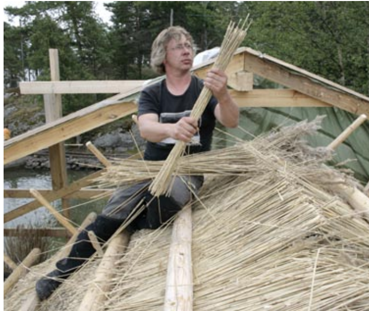
Harja viimeisteltiin noin 70 cm mittaisilla ruo'oilla jotka asetettiin ylimpien painopuiden alle tyvi ylöspäin.
