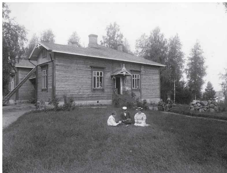
4. Pekkalan koulu ehkä 1890-luvulla. Aluksi julkisivuista laudoitettiin ja maalattiin vain päätykolmiot. / valokuva: August Juselius / Åbo Akademis bildsamlingar.
