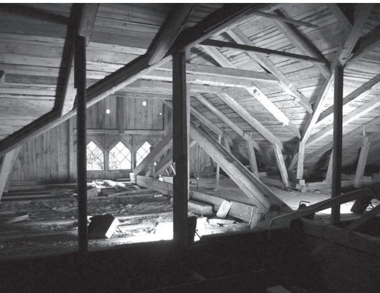
7. Maantienpuoleisen luokkahuoneen jatkamisen yhteydessä (1907-1909) purettu seinä on korvattu kahdella ansaalla, jotka on asennettu ullakolle luokkahuoneen päälle. Toinen ansa kannattelee vanhan puolen ja toinen laajennusosan laipio-palkkeja. / valokuva: KSS.
