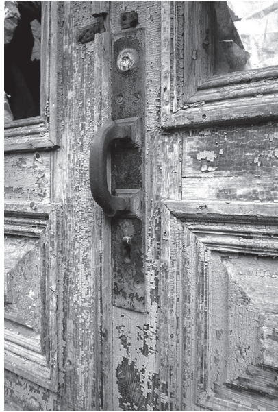
Yksityiskohta keittolan ulko-ovesta. / valokuva: KSS
