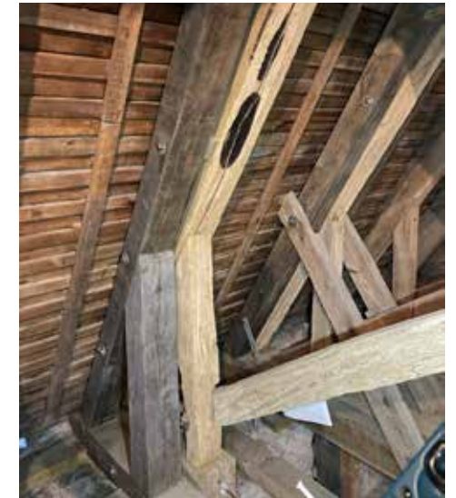
Rakenteita on vahvistettu uusilla osilla. Selkäpuun polttomerkin tarkoitus on mahdollisesti ollut suojata rakennetta tulelta.
