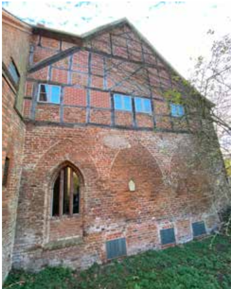
Ristikkorakenne kirkon julkisivussa.
