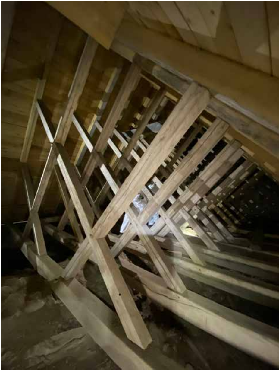
Yleisnäkymä runkokuoneen romaanisista kattotuoleista, joissa on alapaarteet ja kaksinkertainen pönnkäristikko.
