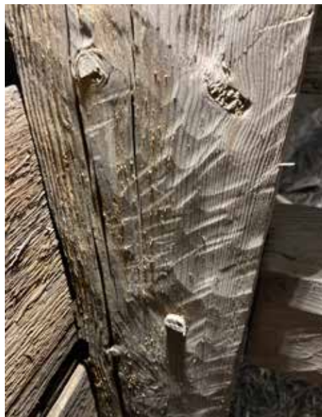
Työstöjäljet tulevat esiin, kun rakenteita valaistaan sivulta. Jälki on tehty kevyellä kirveellä ja pekkaus on vähintään kolmivaiheinen. Ruotsinkielinen termi työstötavalle on sprätthuggning .
