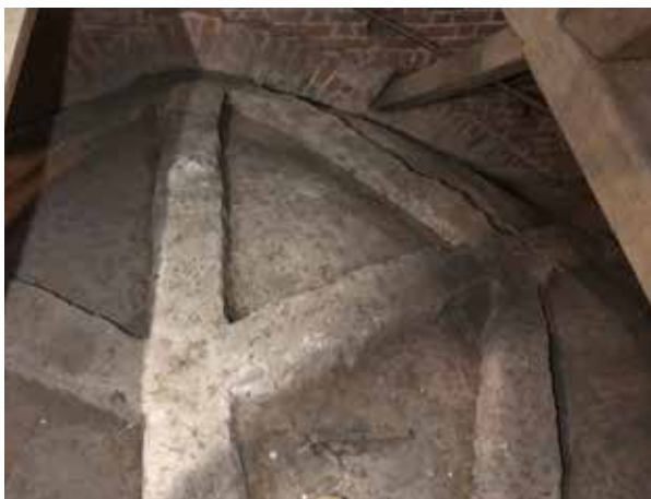
Tiiliholvin ruoteiden yläpintaa.
