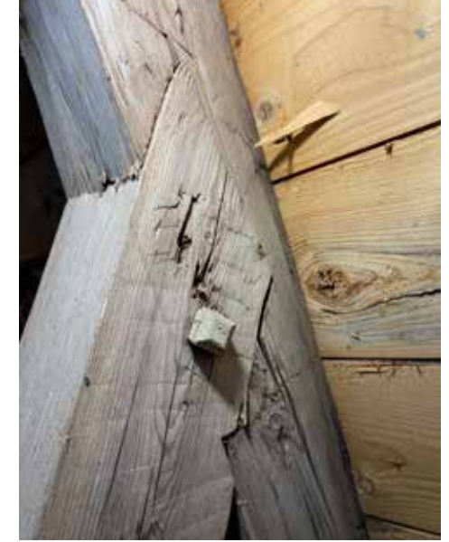
Sakastin konttipuun ja selkäpuun kynsiliiotos. Tappi on nelikulmainen ja kannasta veistetty.
