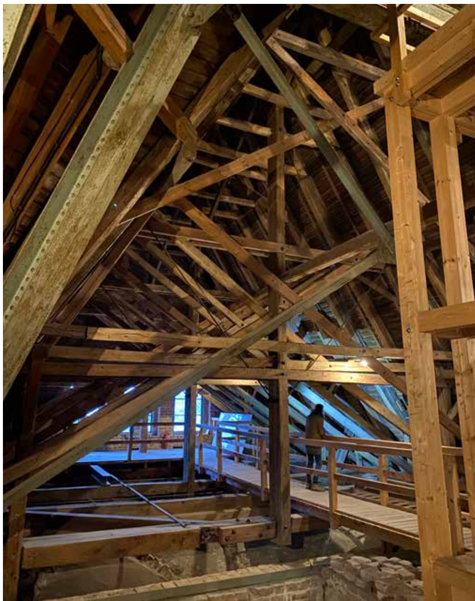
Vuoteen 1296 ajoitetuissa kattotuoleissa on alapaarteet ja kaksinkertainen ristikkorakenne, jossa on kingpost-ristikko harjan alla. Kattotuoleissa on myös kolme kitapuuta ja sakset.
