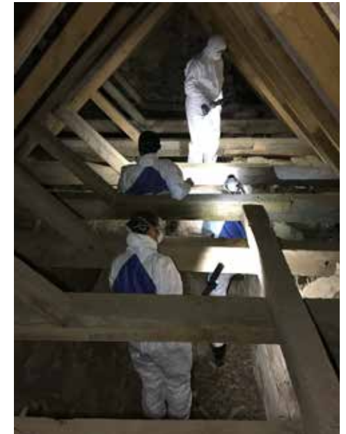
Tutkijoita runkokuoneen vintillä. Kuva on otettu kohti länsipäätä.
