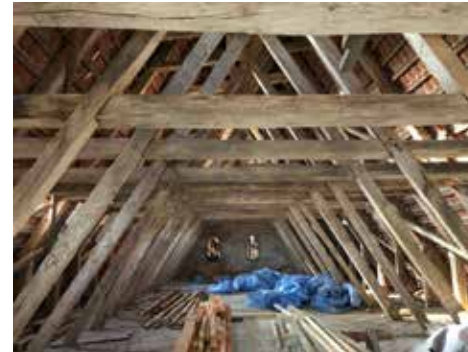
Näkymä runkokuoneen vintiltä kohti länsipäätä.
