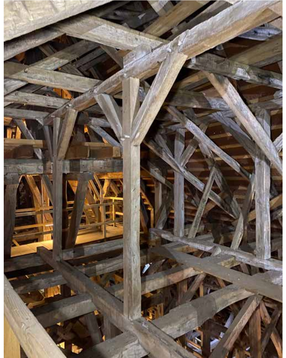
Kattorakenteisiin on tehty turvalliset kulkusillat.
