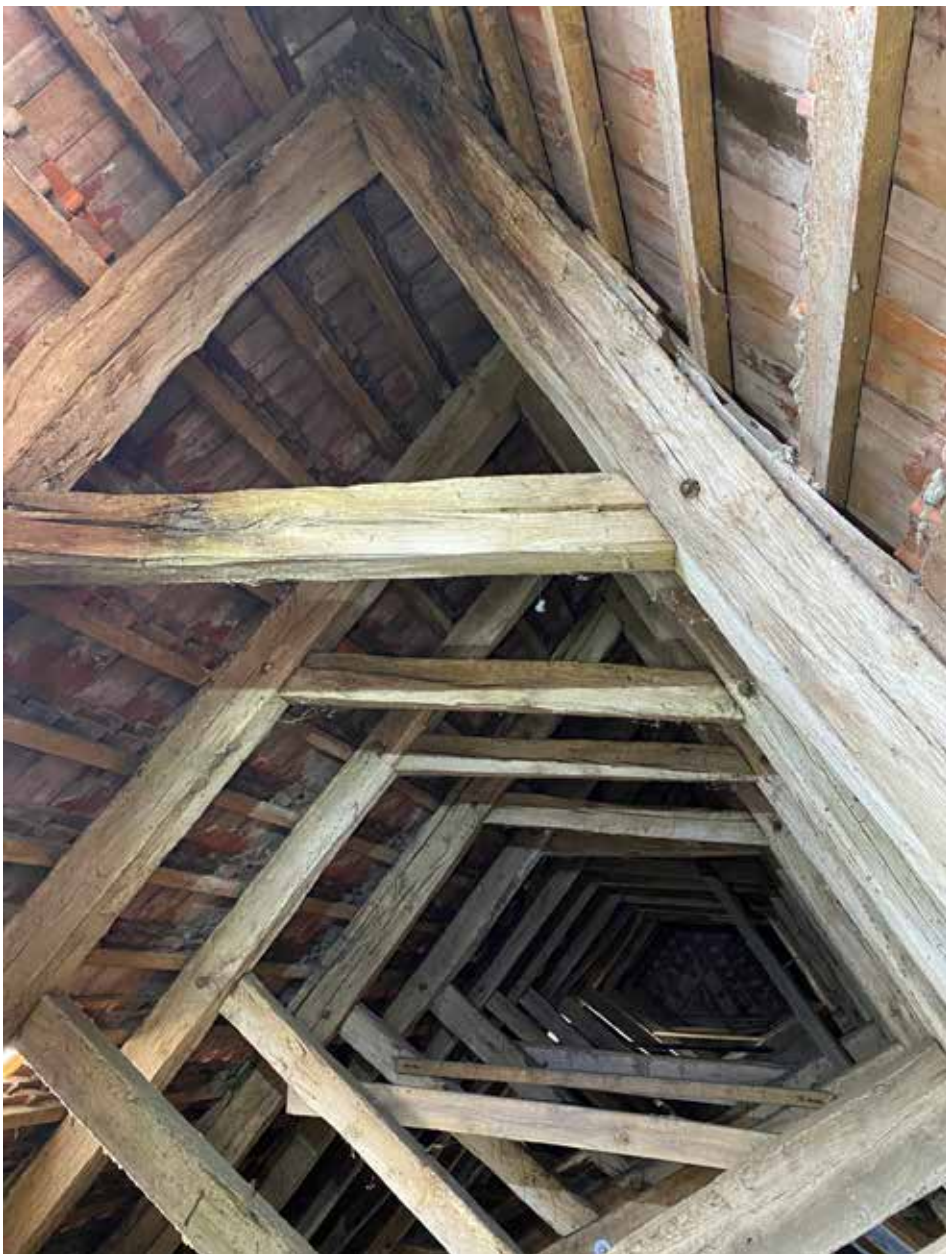
Näkymä katon harjalta, ylimpien kitapuiden välistä.
