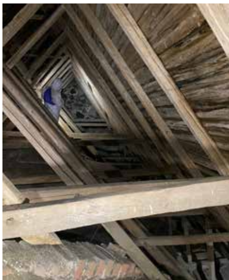
Alimmat kitapuut on kiinnitetty tapeilla saksiiin ilman lovea.
