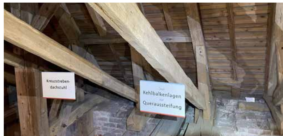
Vintillä on siistiä ja kulkeminen on vaivatonta. Vintillä on myös havainnollisia opastauluja. Saksessa on nähtävissä halkaisukiilojen jättämiä lovia.
