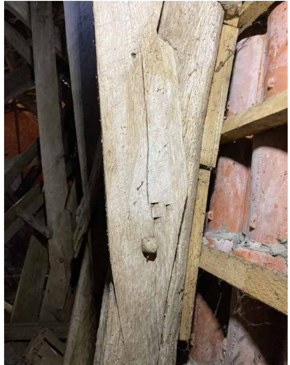
Saksen ja selkäpuun kynnellinen, suora liitos.
