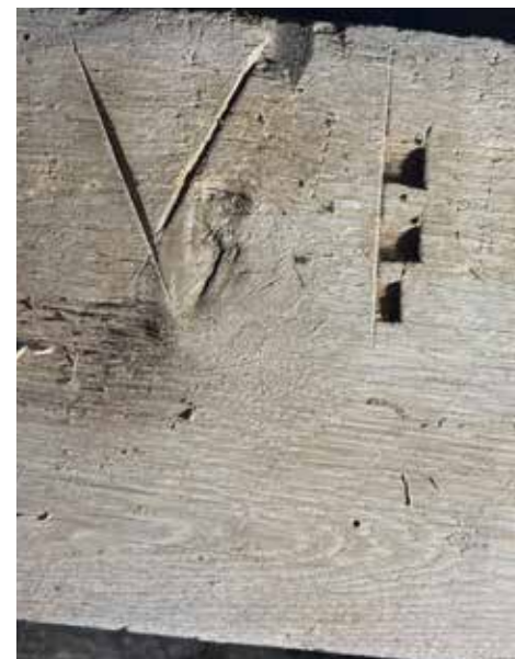
Runkohuoneen kattotuolin pohjoispuolen merkintä. 5 + 3 = kattotuoli 8.
