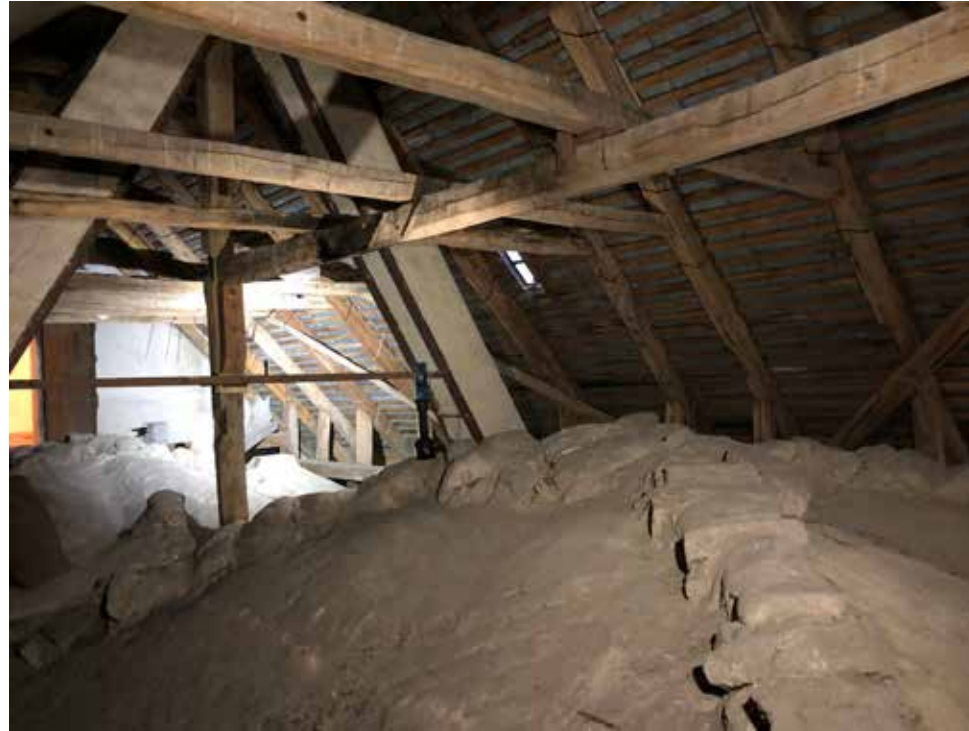
Runkokuoneen vintiltä otetussa kuvassa näkyy pitkä harjan suuntainen parru, jonka särmät on veistetty viistoiksi. Parrussa näkyy myös vanhojen liitosten lovia, jotka ehkä kertovat puutavaran olevan kierrätettyä, tai sitten ne ovat merkkejä jossain vaiheessa rakenteesta poistetuista osista. Kierrätystavaran käytöstä kertovia lovia on runsaasti eri puolilla kirkon kattorakenteita.
