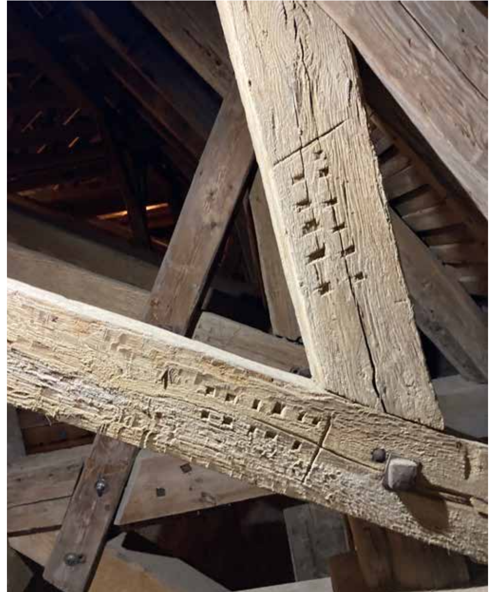
Pistemäisiä numeromerkintöjä. Puutapeissa on kannat. Tapitukset on tehty lännestä.
