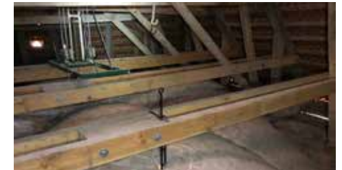
Kuorin uusia tukirakenteita.
