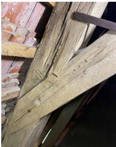
Liitoksia on vahvistettu raudoin.
