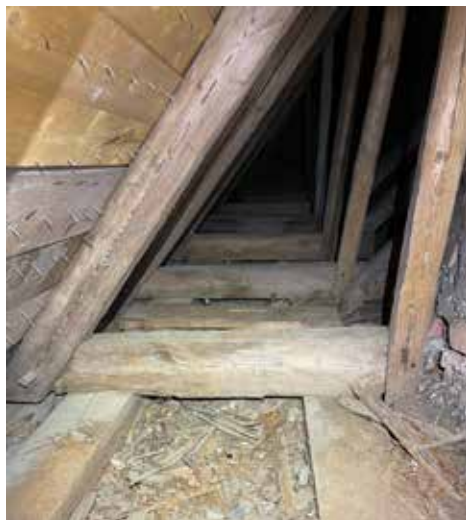
Näkymä konttikäytävältä. Selkäpuiden ja kääpälien sivussa on numeroiteja. Konttipuut on lisätty myöhemmin, luultavasti holvien rakentamisen yhteydessä.
