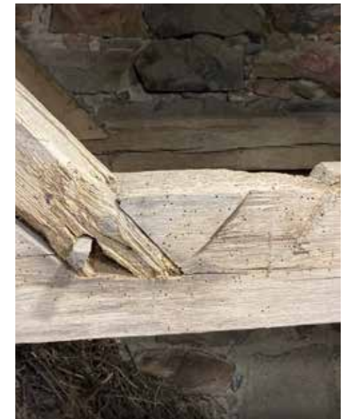
Yksityiskohta alapaarteesta. Pönnän ja alapaarten liitoksen vieressä on toinen lovi, mutta siinä ei ole reikää.
