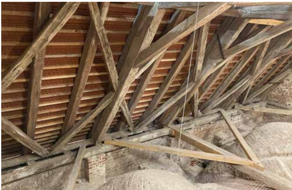
Kuorissa on "lahdelmarakenne", joka muistuttaa Gadebuschin kirkossa nähtyä. Täällä joka kuudennessa kattotuolissa on alapaarre ja niiden välissä vekselipalkki. Väliin jäävien kattotuolien kädäpäät kiinnittyvät vekselipalkkeihin, joka näin estää niitä leviämästä. Rehnassa alapaarteelliset kattotuolit ovat pukkirakenteisia.
