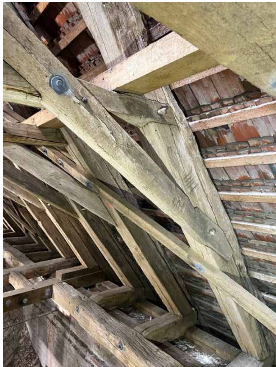
Selkäpuissa ja saksissa on viivoin tehtyjä numerointeja. Liitoksia on vahvistettu pulteilla.
