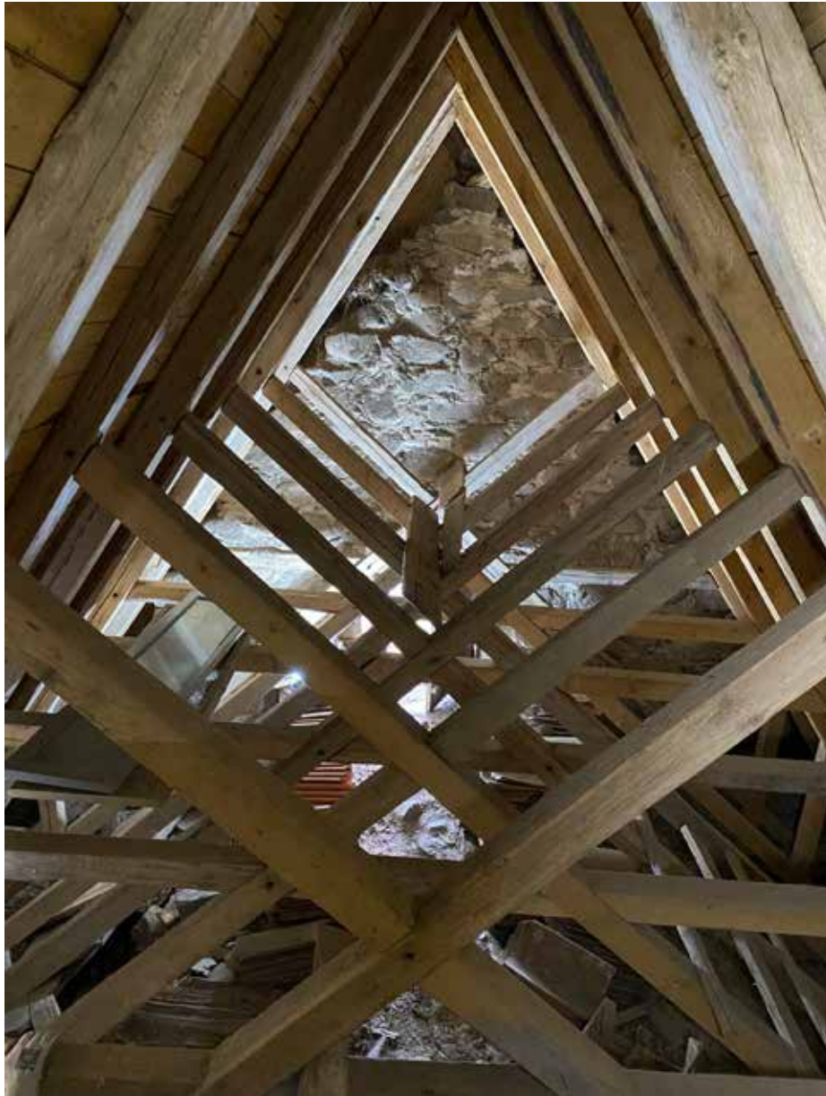
1400-luvun puolivälissä rakennetussa sakastissa on jyrkät konttikattotuolit, joissa on sakset ja yksi kitapuu. Kuva on otettu kohti sakastin pohjoispäätä, jonka luukun kautta kuljetaan vintille.
