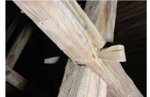
Tapit ovat pitkiä ja lohkottuja.
