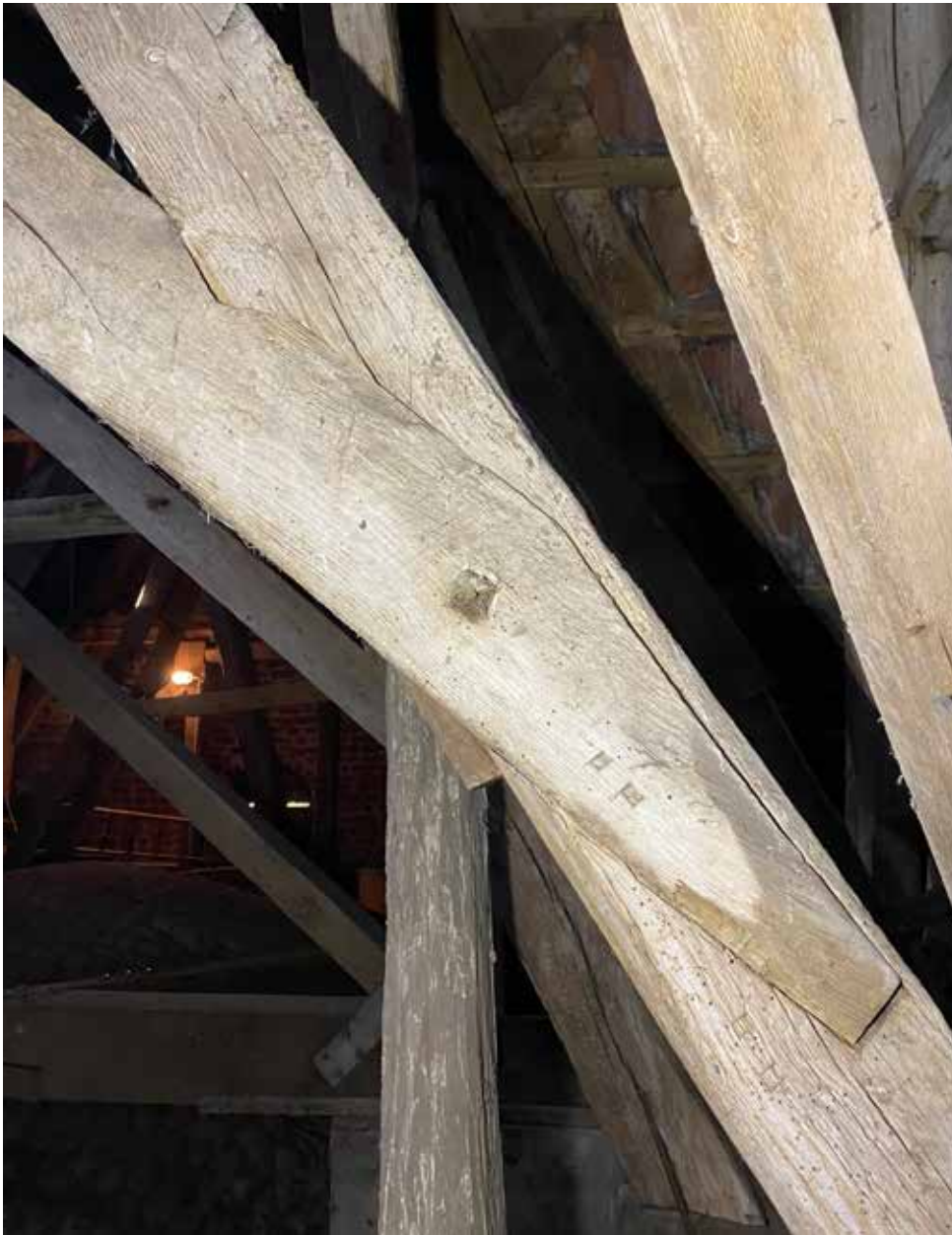
Kynnellinen, suora lapaliitos ja taltalla tehdyt kuopat.
