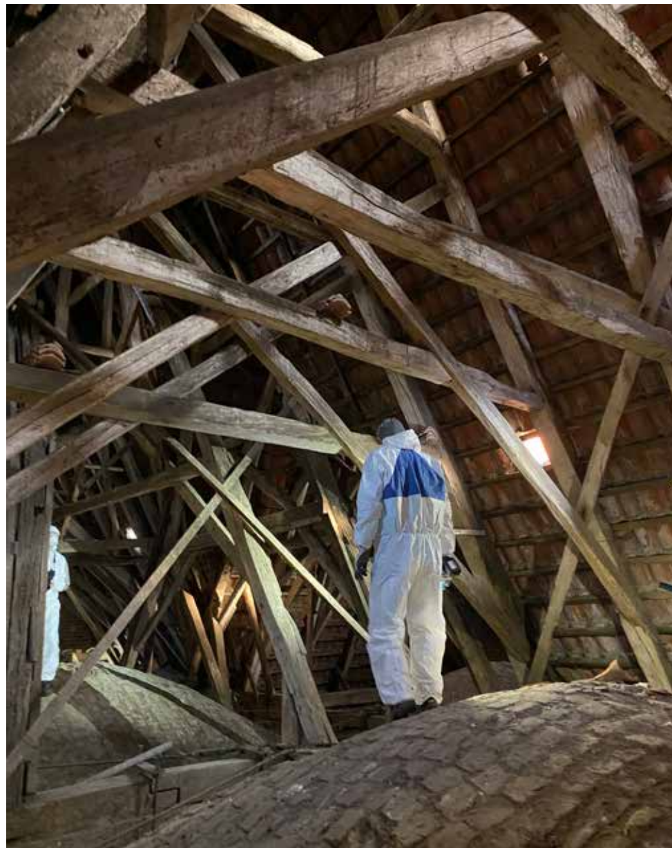
Vietlűbben kyläkirkon kattotuoleissa on selkäpuut, sakset ja kaksi kitapuuta. Osassa kattotuoleja on alapaarteet, muutoin kattotuoleissa on kápälät.
