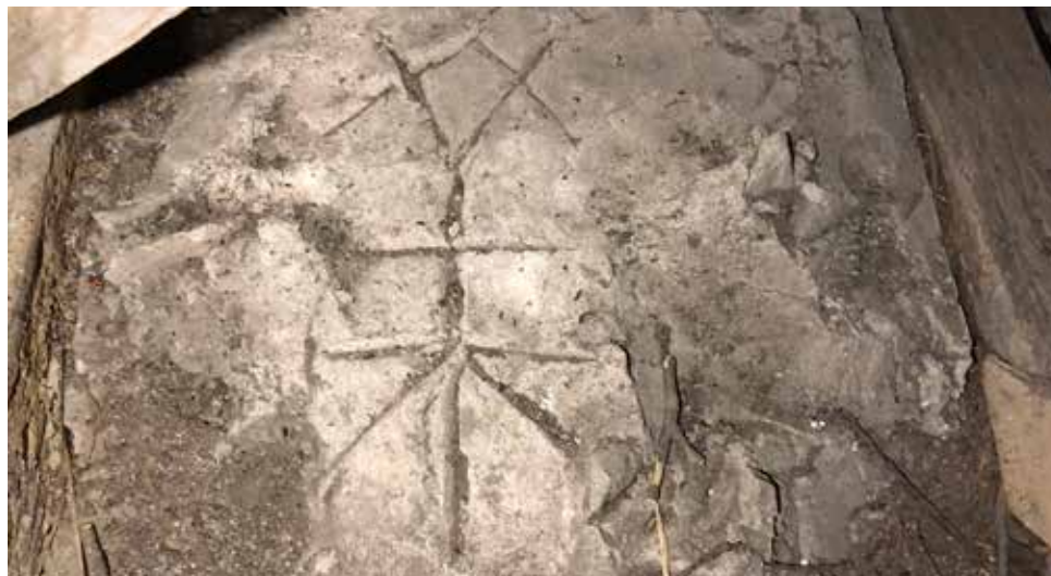
Runkohuoneen holvin päälliseen laastiin tehtyjä merkintöjä.
