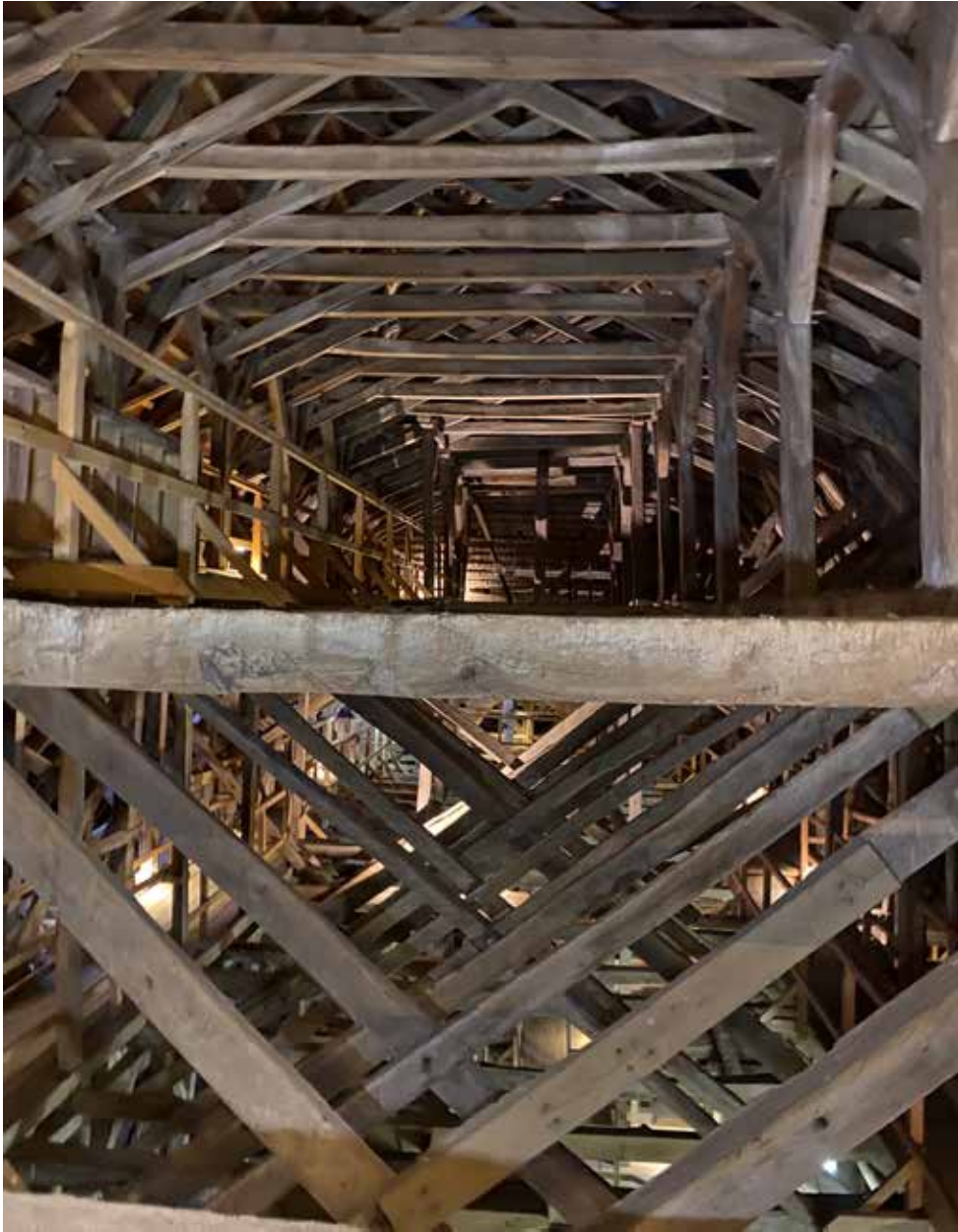
Näkymä saksien liitoskohdan yläpuolelta.
