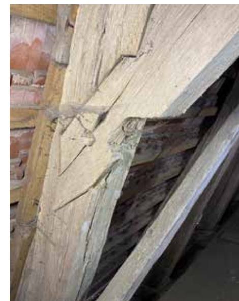
Saksen alapään särmälovi.
