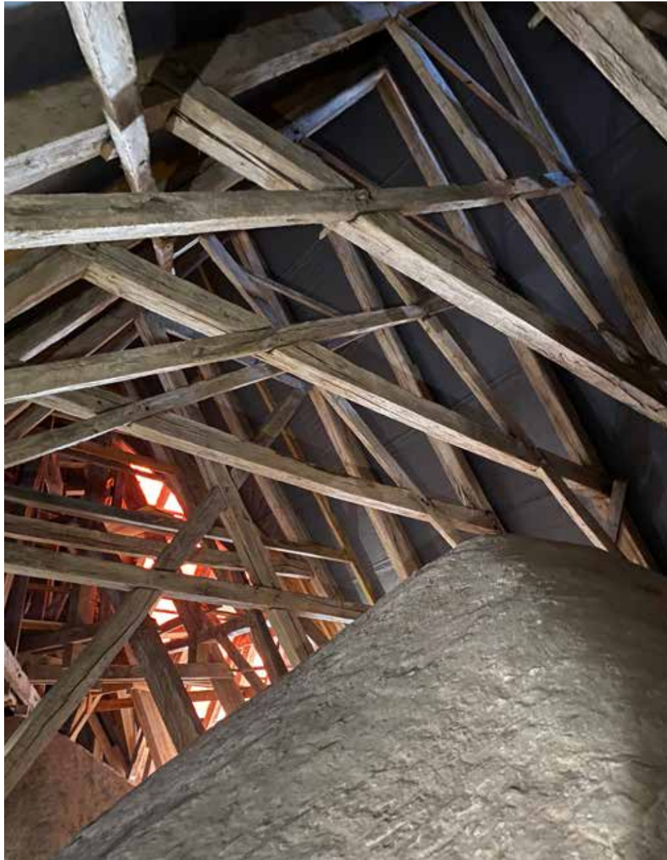
Poikkilaivan tiiliholvien yläpuolella.
