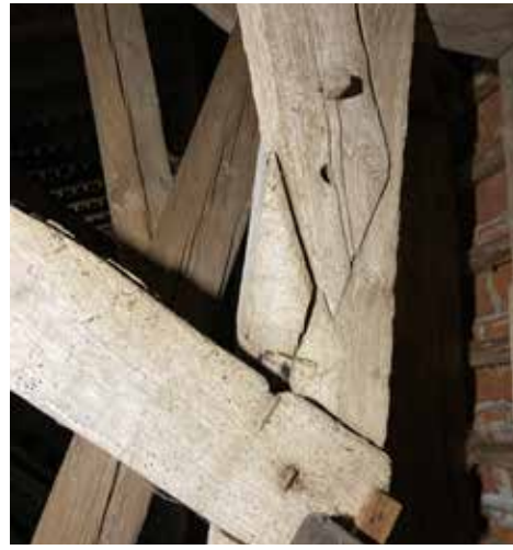
Kynnellinen liitos, jossa on vanhan puutapin lisäksi tapiton reikä.
