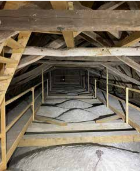
Yleiskuva runkokuoneen holvien päältä.
