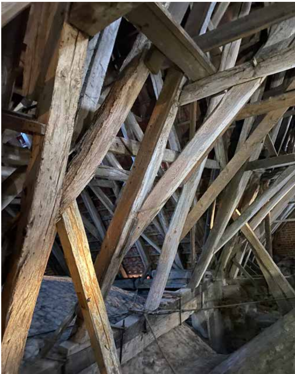
Tiiliholvien päällä ei ole eristeitä.
