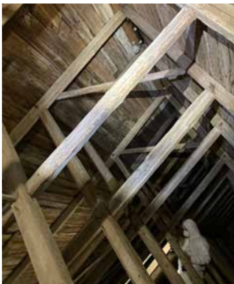
Kitapuut on lovettu selkäpuihin lännen puolelta, mutta sakset idän puolelta.
