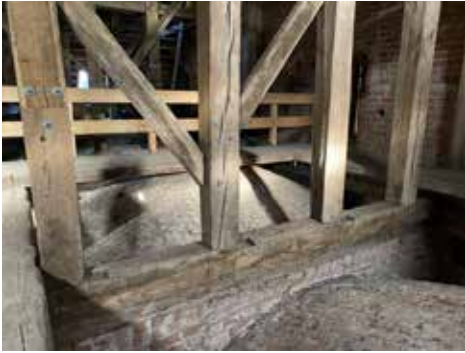
Jykevä alapaarre muurin päällä.
