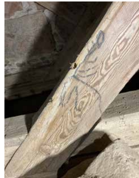
Kuorin kattotuolin kylkeen tehty piirustus voidaan tulkita hirveksi.
