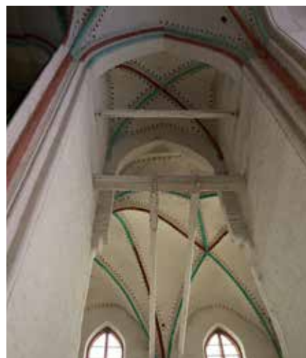
Muuriankkuri- ja vetotankorakenteita.
