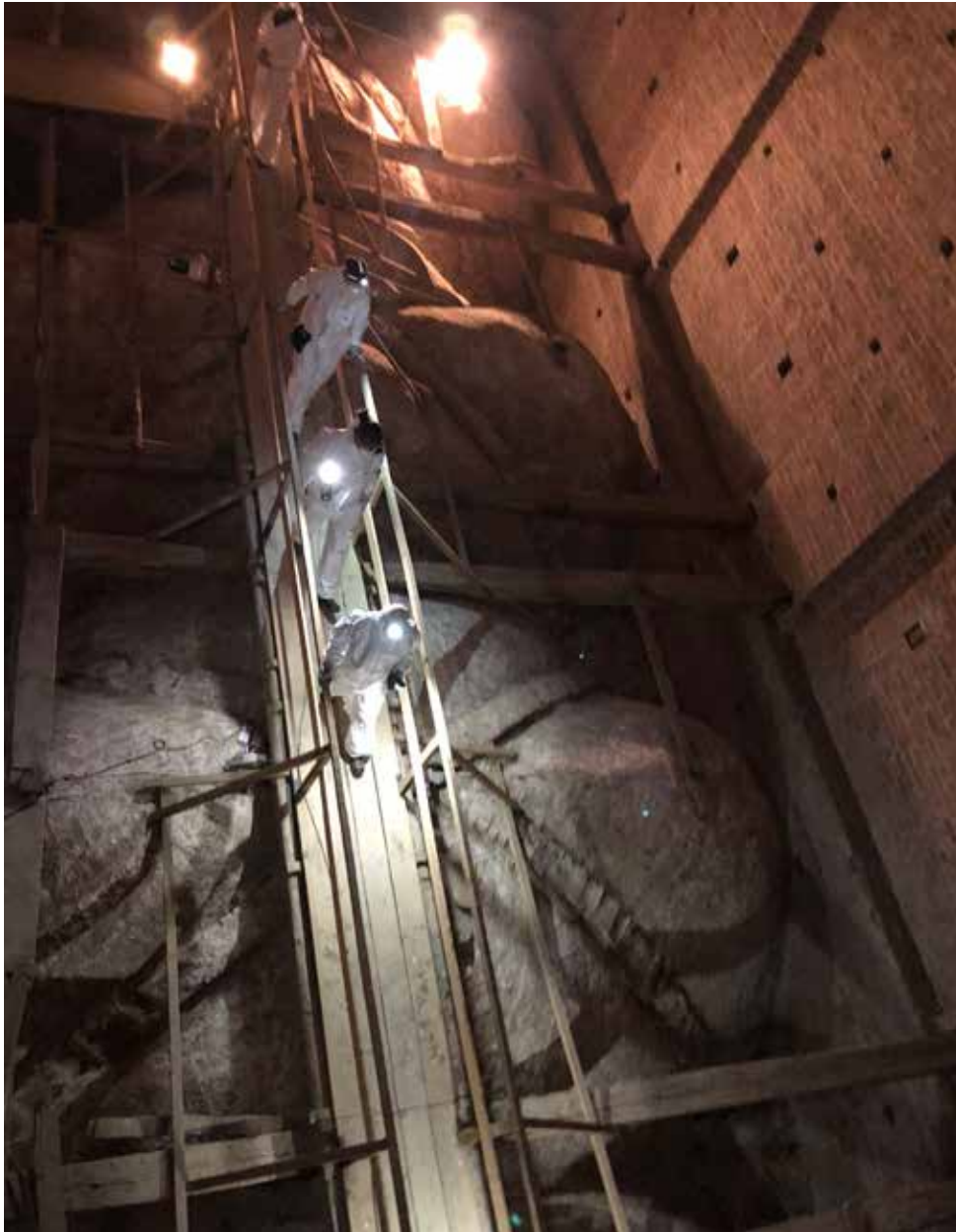
Tutkijaryhmä holvien yläpuolisella kulkusillalla.
