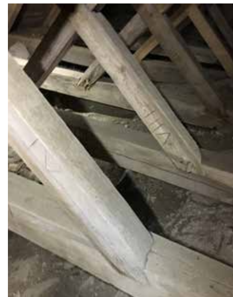
Runkohuoneen kattotuolien numeromerkintöjen kirjoitussuunta vaihtelee.
