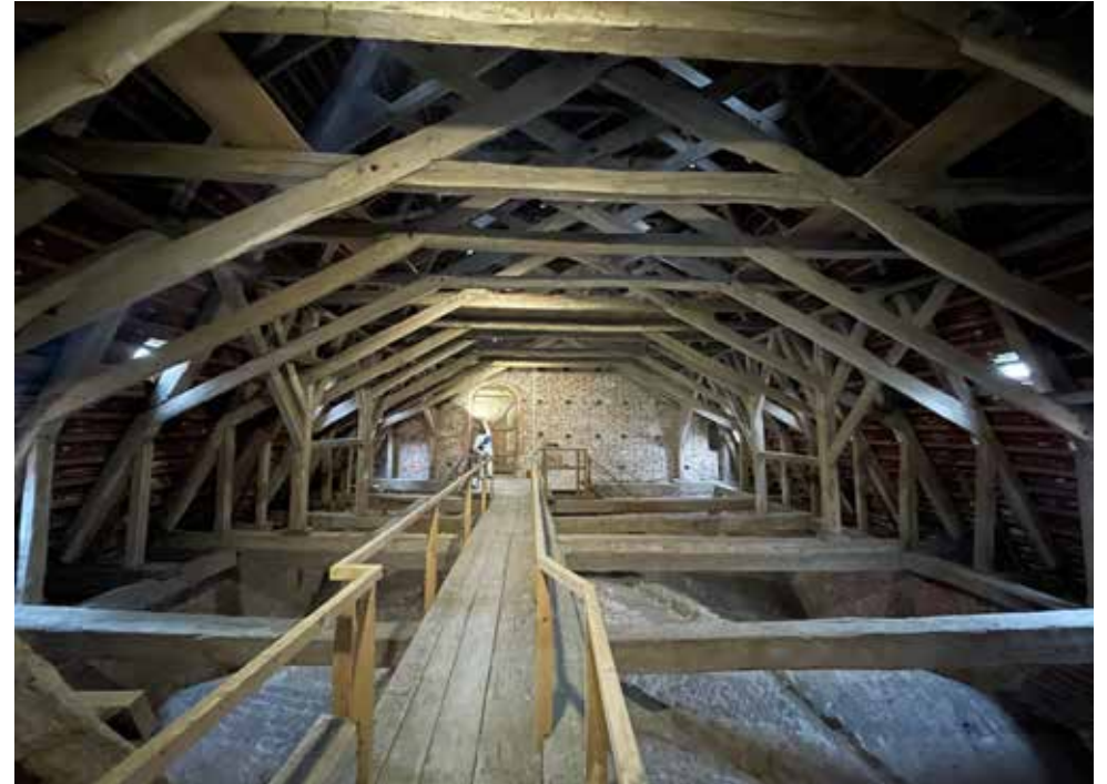
Yleisnäkymä runkokuoneen vintin sillalta. Runkokuoneen kattotuolit ovat 1380- ja 1390-luvuilta.
