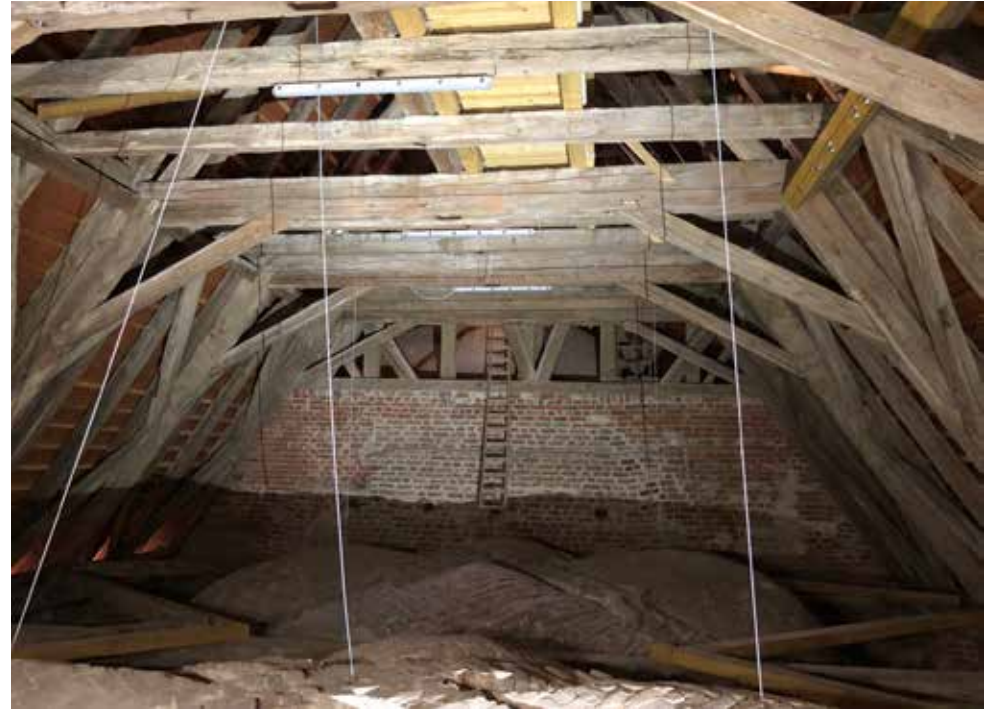
Näkymä kuorin vintiltä kohti länsipuolista runkokuoneen vinttiä.
