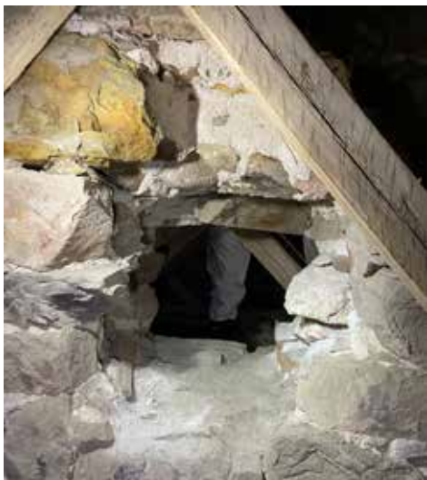
Runkohuoneen ja kuorin vintin välinen aukko.
