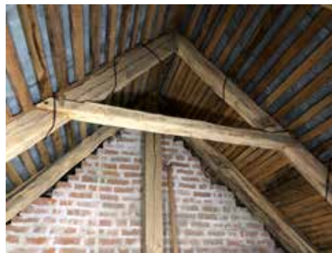
Runkokuoneen vintin selkäpuissa oikealla näkyy puuosien uudelleenkäytöstä kertovia lovia.
