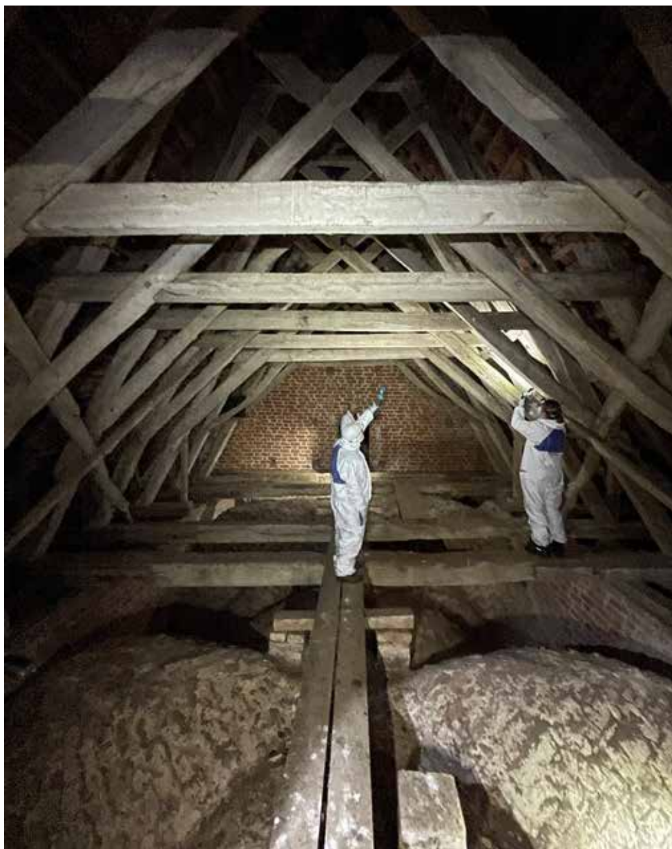
Runkohuoneen vanhimman osan kattotuolit on ajoitettu 1425d. Kattotuoleissa on käytetty myös edellisestä rakennuksesta peräisin olevia 1230-luvun kierrätysosia.
