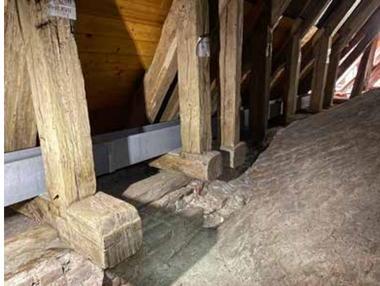
Näkymä runkokuoneen vintin konttikäytävälle.
