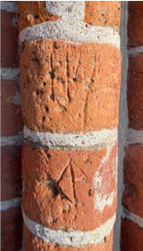
Tiilentekijöiden merkkejä kirkon julkisivussa.
