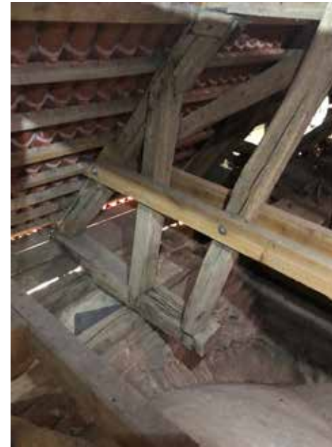
Kuorin 1210-luvun kattotuoleja on vahvistettu.
