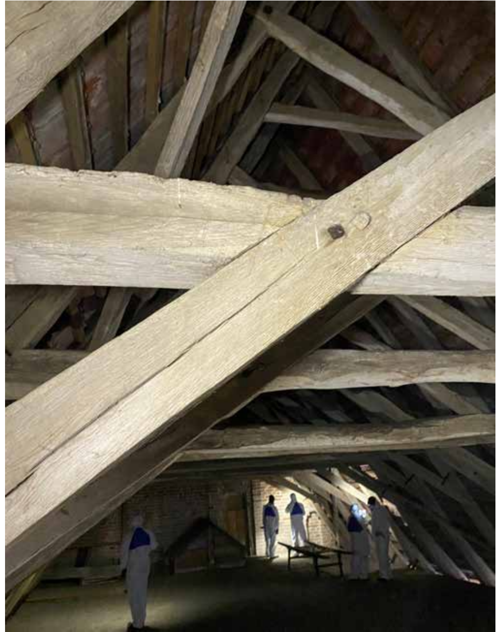
Kattotuoleissa on kaksi kitapuuta.
