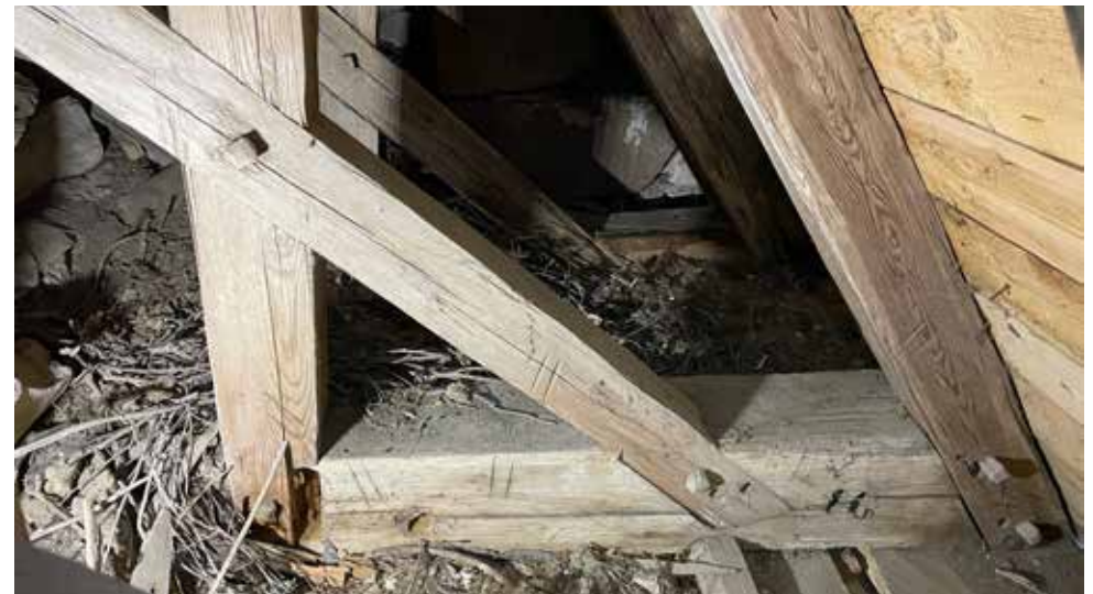
Sakastin konttikattotuolien selkäpuissa, konttipuissa, kápälissä ja saksissa on roomalaiset liitosmerkinnät. Kuva on konttikäytävältä.
