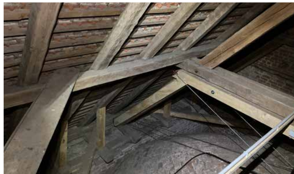
Kattotuoleja on vahvistettu asentamalla uusia osia vanhojen kylkiin. Osa rakenteista on uusittu.
