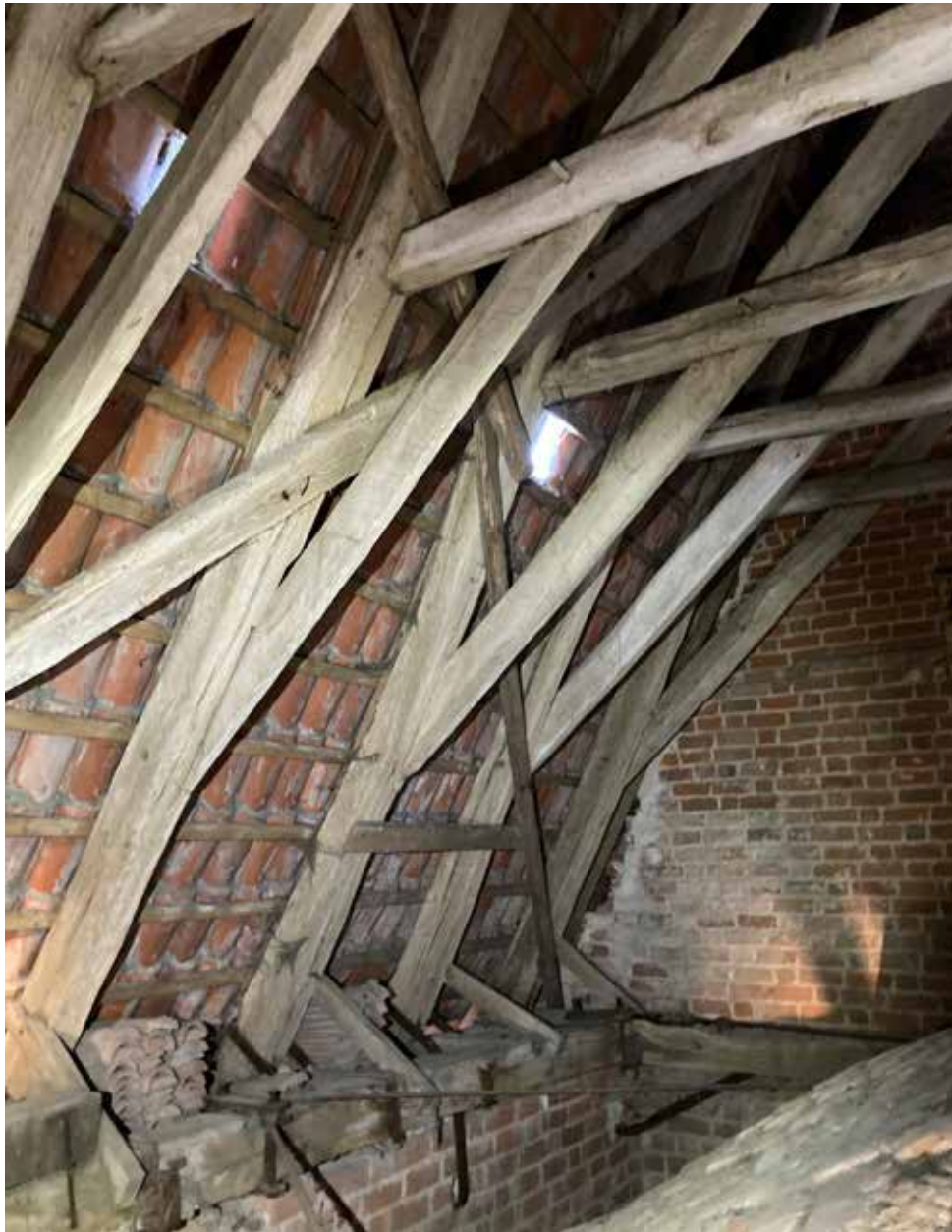
Kattotuolien alanurkissa on myöhemmin lisätyt pienet pönkät.
