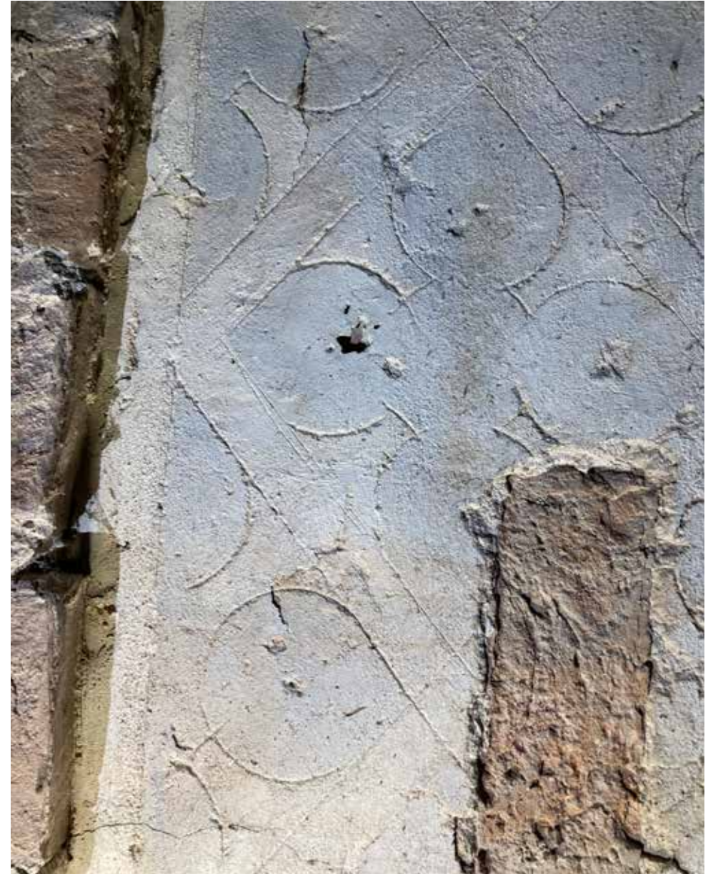
Runkohuoneen vanhaa julkisivukoristelua, joka on sittemmin jäänyt laajennuksen vintille.
