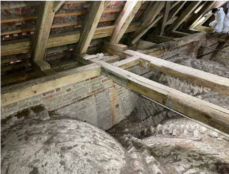
Holvien päällä ei ole eristeitä ja niiden muodot ruoteineen tulevat vintillä kauniisti esiin. Kuvan oikeassa yläkulmassa rakenteita tutkii Antti Haikala.
