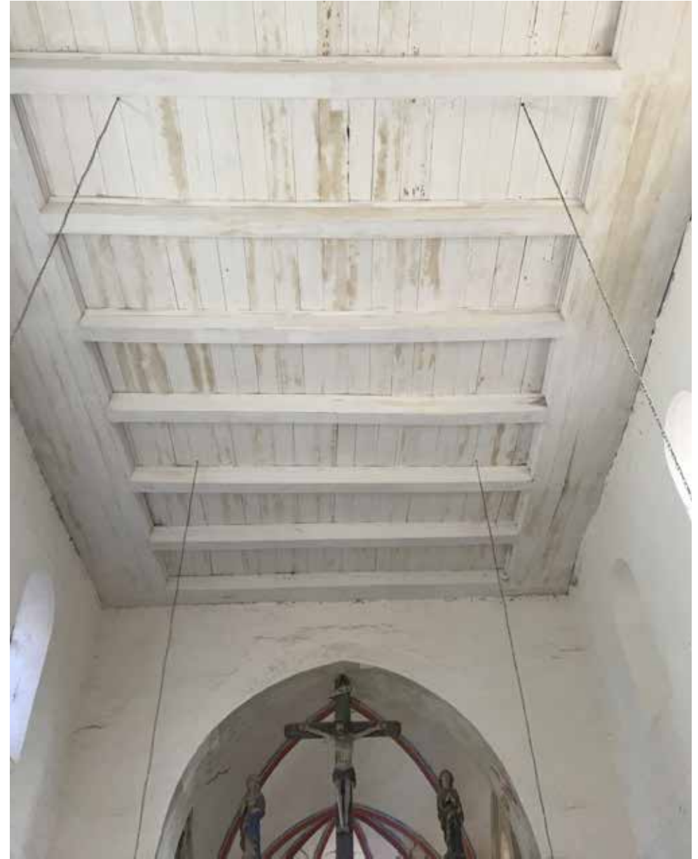
Kirkkosalissa on puinen tasalaipio. Laipiopalkit ovat myöhempi lisäys. Kattotuolien alkuperäisten alapaarteiden pätkät on koteloitu reunoille.
