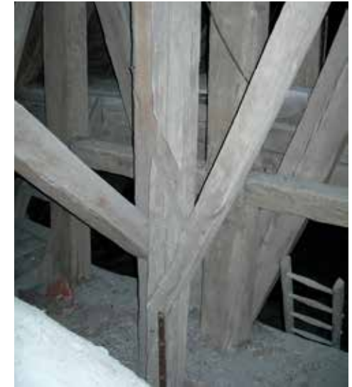
Hängsäule eli ripustusparru. Kuva: Tilo Schöfbeck.
