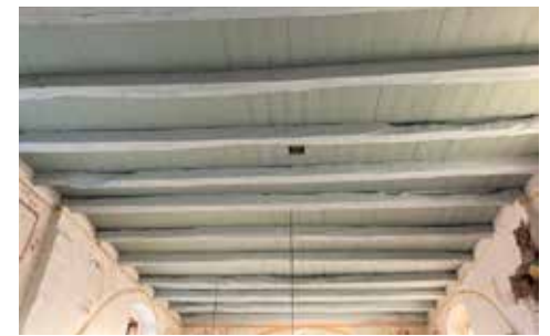
Tasalaipiossa on epäsäännöllisten näköisten alapaarteiden päällä laipiolaudat.
