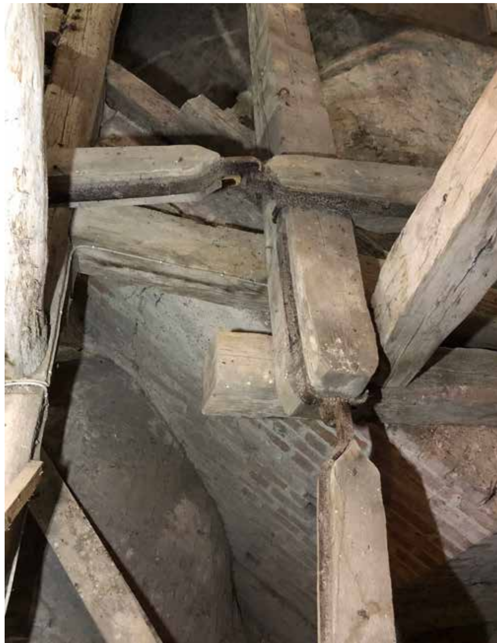
Rakenteeseen 1700-luvulla lisättyjä vetotankoja.
