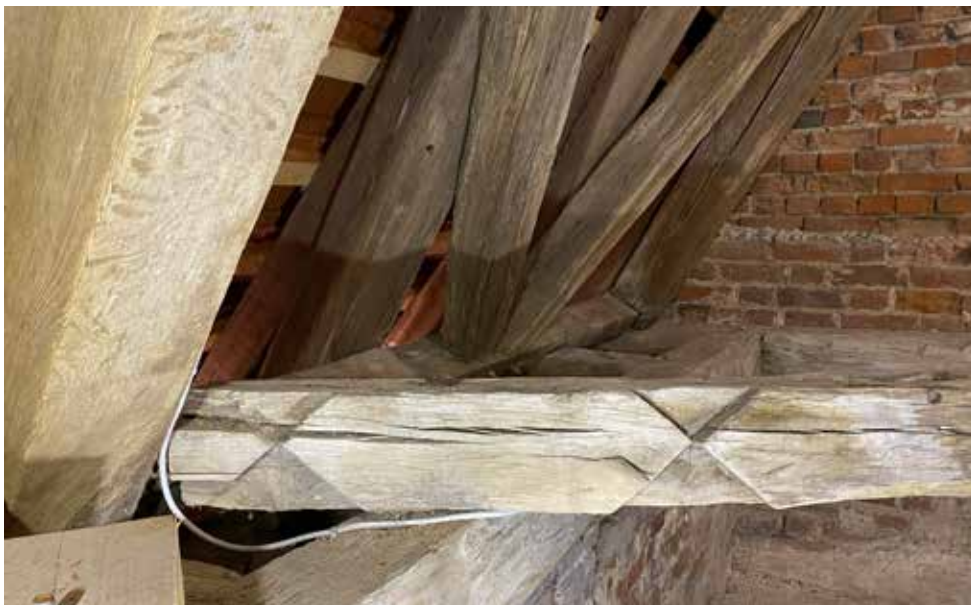
Ullakolla näkyy myös uudelleenkäytön merkkejä puutavarassa..
