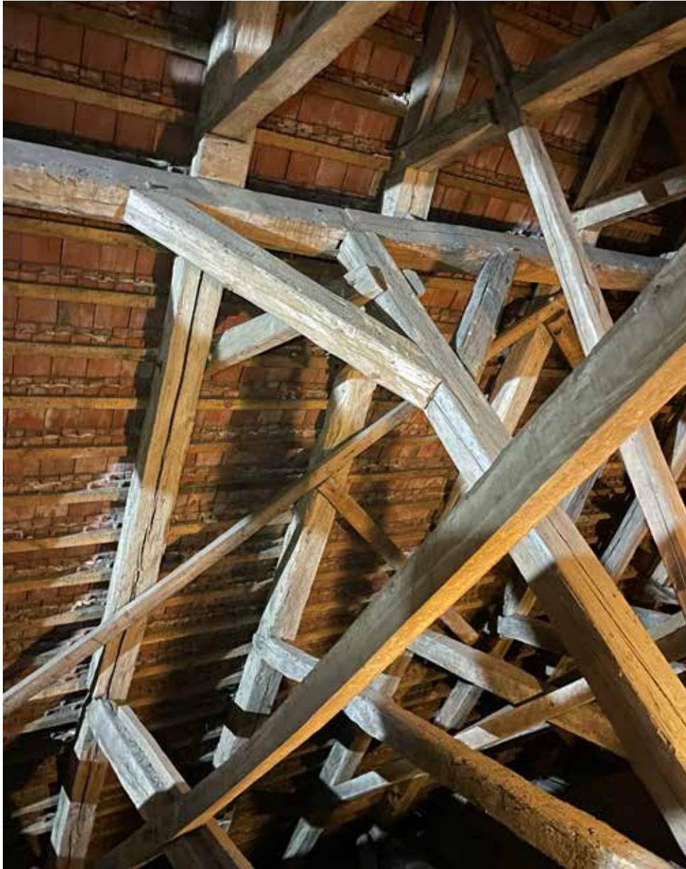
Rehnan luostarikirkon runkokuoneen kattotuolit ovat 1400-luvun puolivälistä. Alapaarteellisessa kattotuoleissa ei ole saksia vaan pönkät king postin alaosasta selkäpuihin
