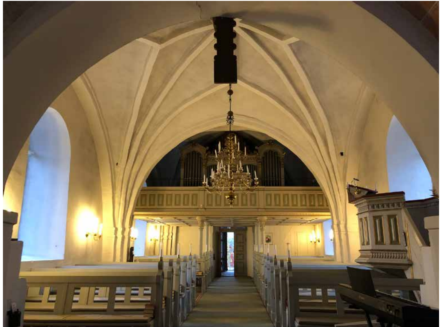
Holvattu kirkkosali kohti länsipäädyn pääsisäänkäyntiä ja urkuparvea.
