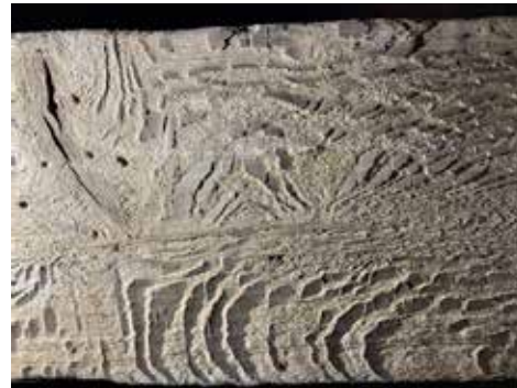
Toisen maailmansodan aikana kattorakenteet suojattiin kalkkimaalilla, joka on myöhemmin poistettu kemiallisella käsittelyllä. Keskiakais- set työstöjäljet ovat tämän vuoksi hävinneet.
