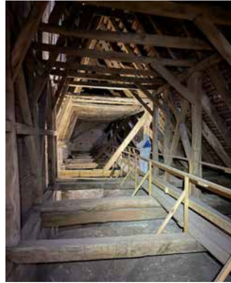
Runkohuoneen sivulaivan kattotuoleja.
