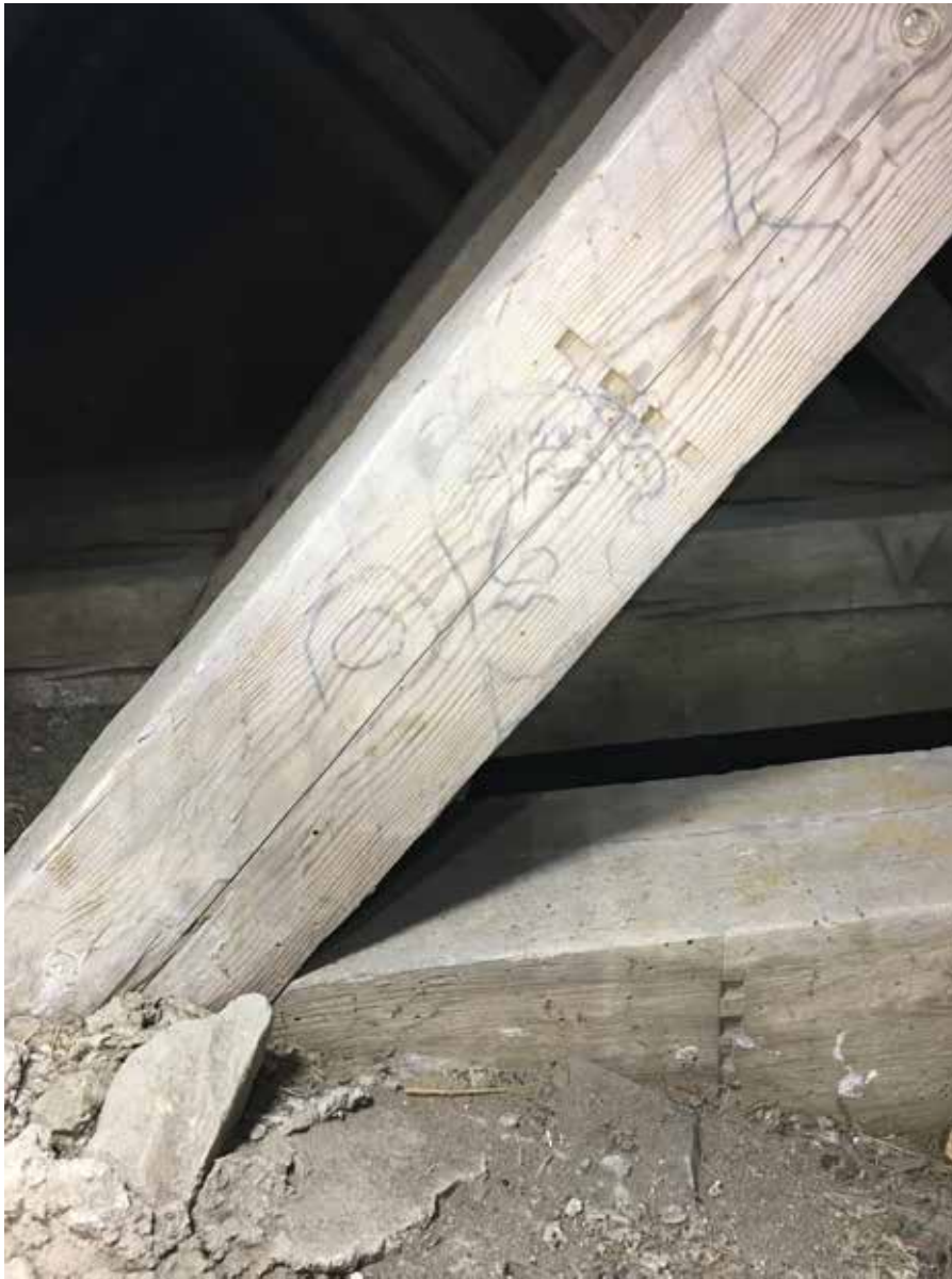
Runkohuoneen kattotuolin kyljessä on miehen kasvoja esittävä piirustus. Sakseen kai-verrettu merkintä on poistanut osan hahmon hiuksista, mikä viittaa siihen, että piirustus on tehty samanaikaisesti kattotuolien kanssa. Piirustus on todennäköisesti 1400-luvun alkupuolelta. (Hallgren, Palmblad, Melin & Thelin 2021, 13.)
