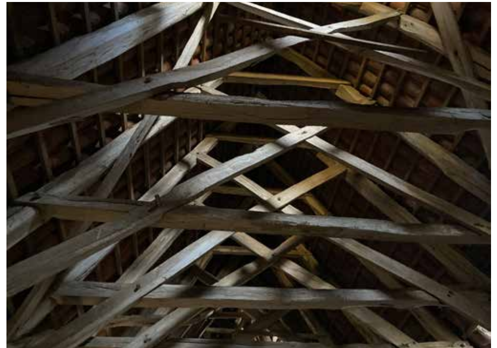
Näkymä kohti harjaa. Saksissa on käytetty paljon varsin väkkyrä puutavaraa.
