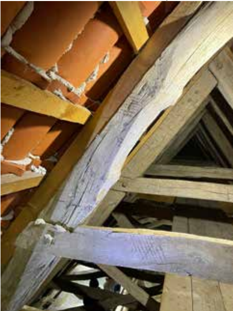
Viivanumerointeja runkokuoneen kattotuolin selkäpuussa ja kitapuussa.
