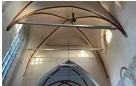
Muuriankkurein kiinnitetyt, tammesta tehdyt vetotangot näkyvät kirkkosaliin.
