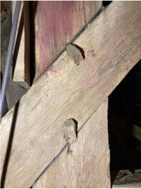
Matkalla nähdyissä kattorakenteissa sakset oli usein tehty muita sauvoja ohuemmasta puutavarasta. Tämä mahdollistaa tarvittaessa saksien taivuttamisen paikoilleen, jolloin vaar-noihin saattaa kohdistua normaalia enemmän vetoa.
