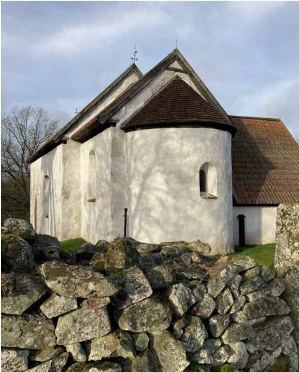
Hemmesjön vanhan kirkon runkokuoneen itäpäädyssä on kuori, jossa on runkokuonetta kapeampi suorakulmainen osa sekä vielä tätä kapeampi puolipyöreä absis. Oikealla näkyy sakasti.
