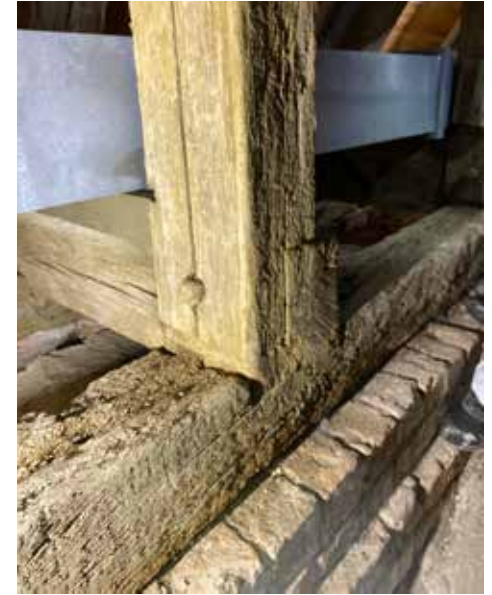
Seinämuurin yläpuolisen jalasparrun, kápälän ja konttipuun liitoskohta.
