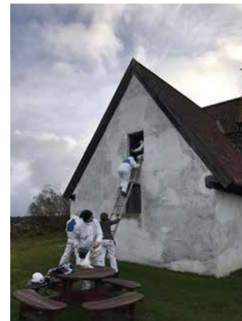
Vintille nouseaan ulkokautta sakastin päädyssä olevasta luukusta tikkaiden avulla. Kuva: Ilari Aalto.
