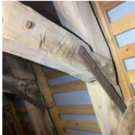
Selkäpuiden ja kitapuiden liitoksia on vahvistettu.
