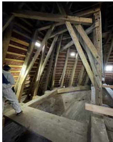
Kuorin kattotuolit on ajoitettu 1316d.
