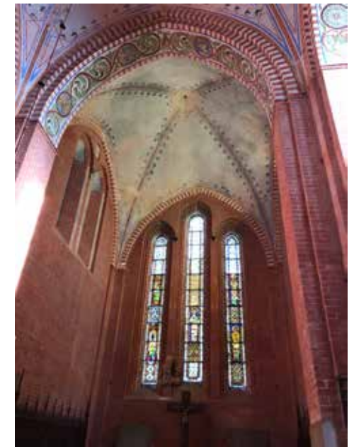
Koristemaalattu kuorin ristiholvi.
