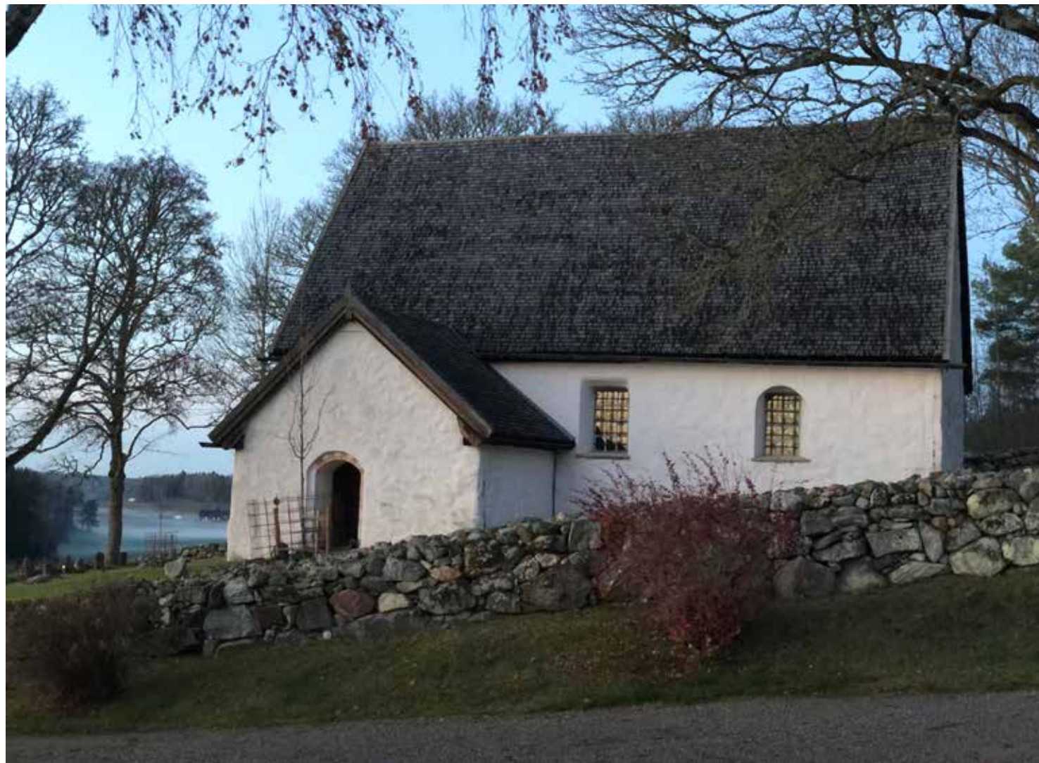
Spelvikin kirkon ainoa sisäänkäynti sijaitsee asehuoneessa. Kirkossa on pärekatto. Seinät on rapattu 1990-luvun restauroinnin yhteydessä. Kirkkopihaa kiertää luonnonkivimuuri.
