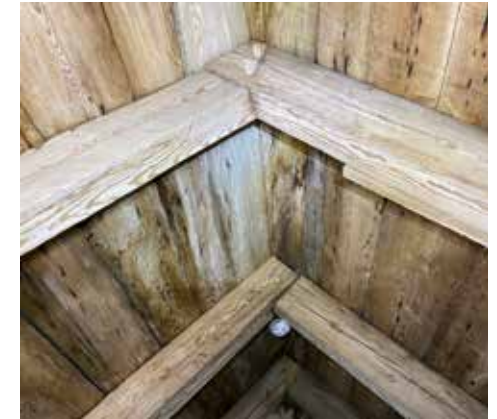
Runkokuoneen selkäpuiden liitokset harjalla on tapitettu kahdella tapilla.
