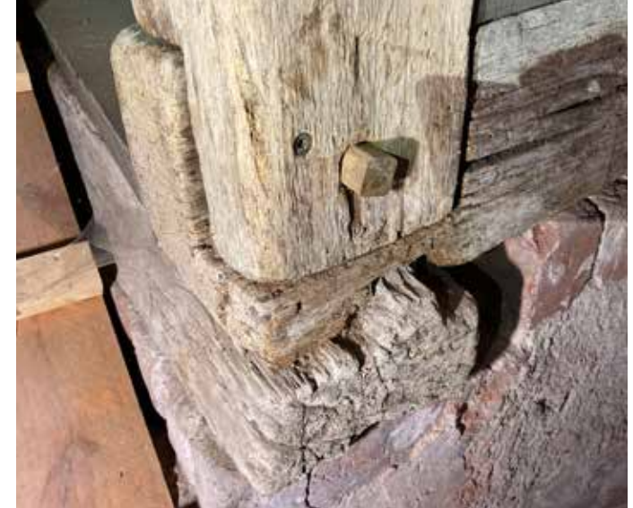
Kápälän ja konttipuun tappiliitosta on vahvistettu ruuvilla.
