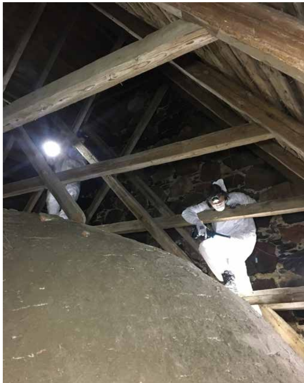
Kattotuoleihin on lisätty holvien muuraamisen yhteydessä uusia kitapuita eri korkeuksille holvin muodon mukaan.
