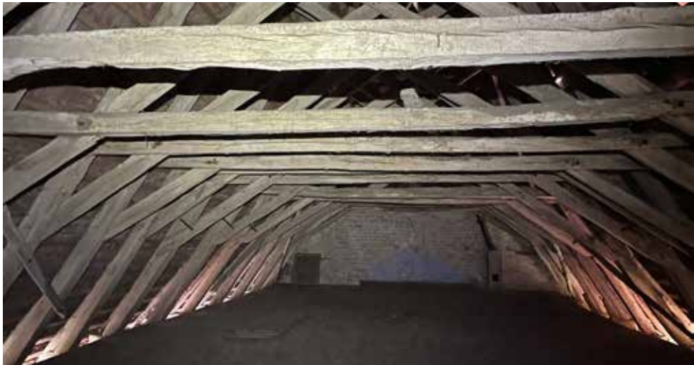
Runkohuoneen kattotuolit on ajoitettu vuoteen 1406d.
