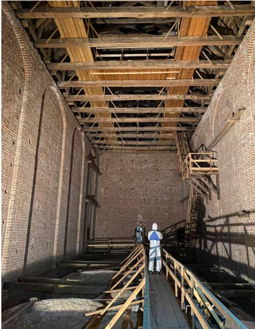
Näkymä kirkon runkokuoneen keskilaivan yläpuoliselta vintiltä, korkeiden tiilimuurien välistä.
