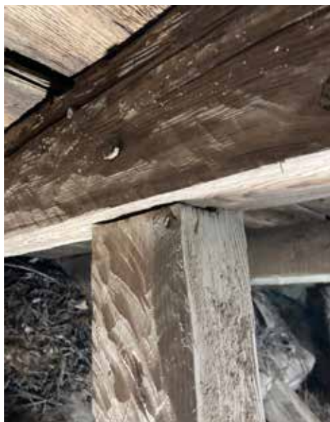
Työstöjäljet tulevat esiin, kun rakenteita valaistaan sivulta. Jälki on tehty kevyellä kirveellä ja pekkaus on vähintään kolmivaiheinen. Ruotsinkielinen termi työstötavalle on sprätthuggning .
