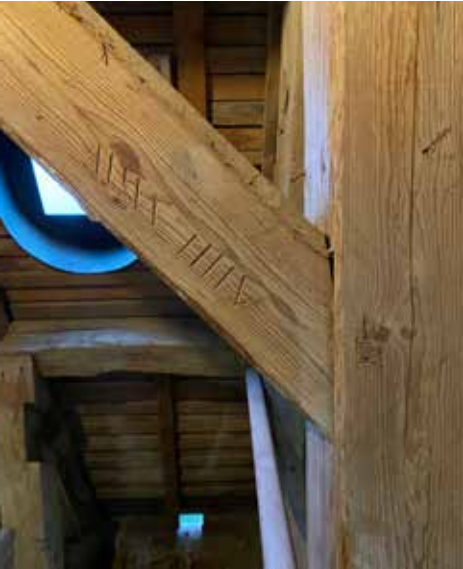
Alkuperäiset liitokset ovat huolella tehtyjä.
