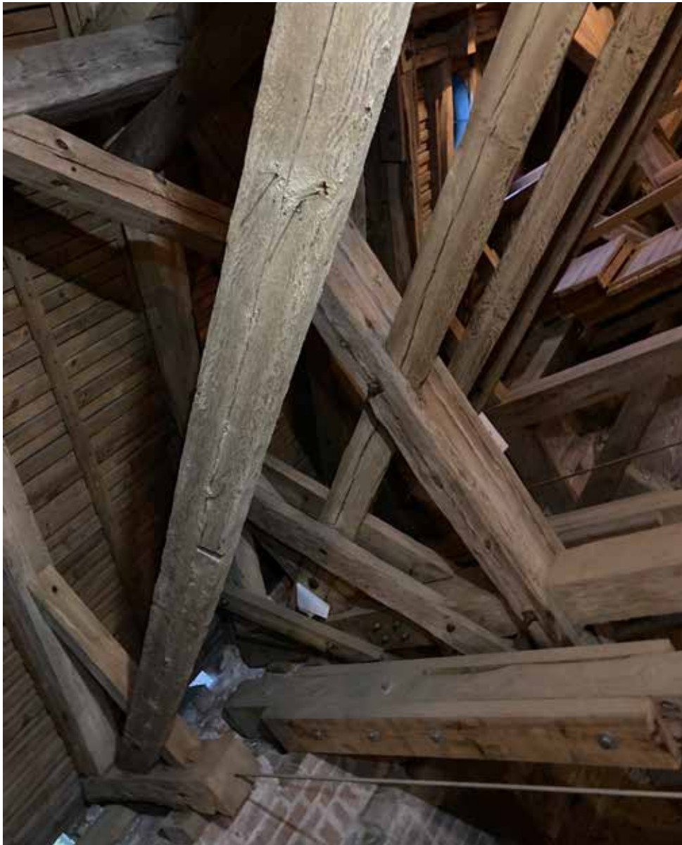
Muurien päällä on sekä sisemmät että ulommat jalasparrut. Sakset lähtevät konttikäytävästä. Saksessa näkyy sahausta helpottaneelle kiilalle kairattu kolo.
