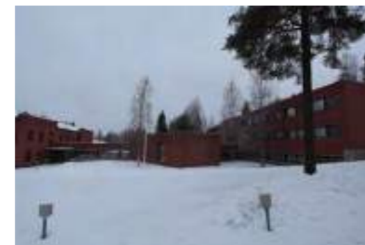
Koulutus- ja kurssikeskuksen (U40) auditorio ja yhdyskäytävä esikuntarakennukseen (V40).
