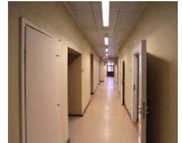
Keskikäytävää on muutoksissa jatkettu läpi talon.
