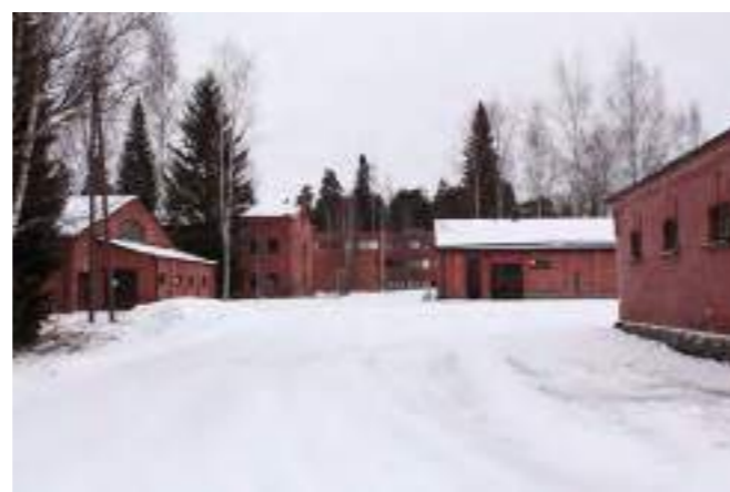
Näkymä etelästä kohti esikuntarakennusta (V40).
