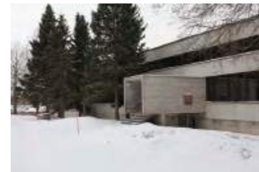
Muonituskeskuksen (30) betoninen sisäänkäyntikatos.
