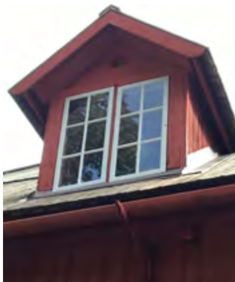
Ullakon kattolyhtyjen ikkunapuitteet on joko kunnostettu tai uusittu 1980-luvulla. Karmit ovat mahdollisesti vanhoja.
