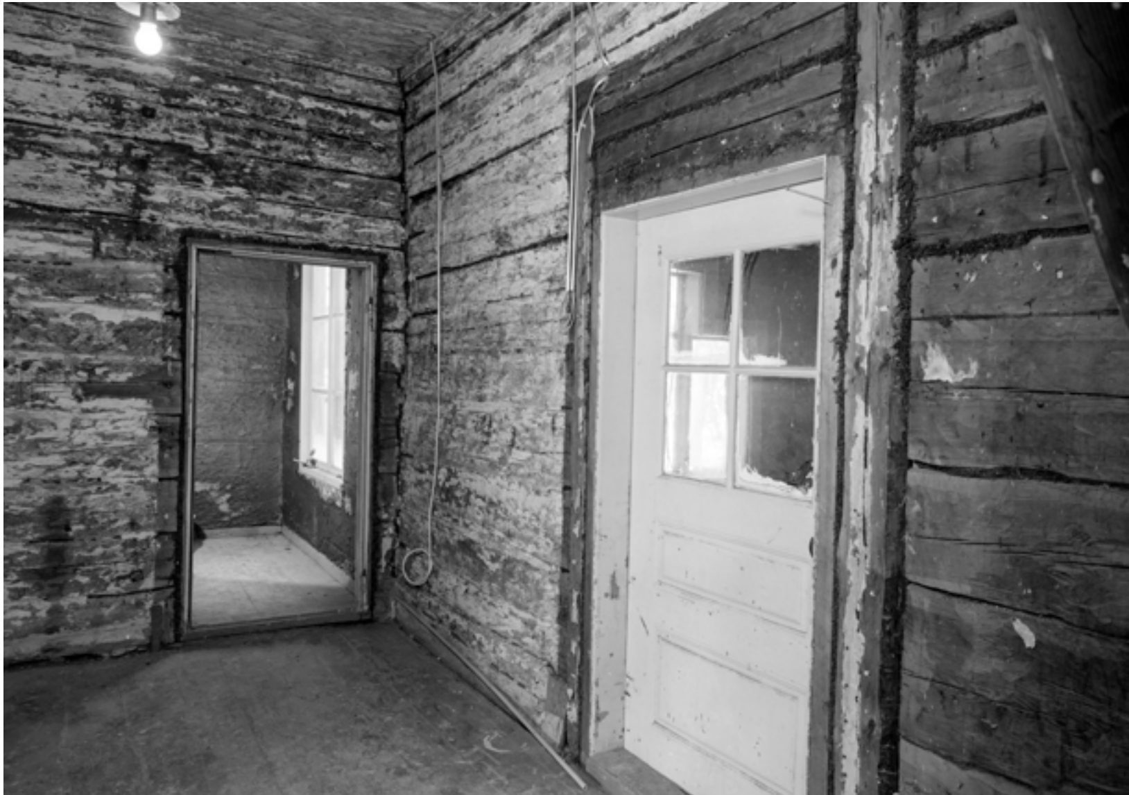
Eteinen helmikuussa 1988. Seinistä on poistettu kaikki vanhat paperit ja tapetoinnit. Eteisen ja pääkuistin h1 välisen oven paikalla on sijainnut alun perin kaksilehtinen ulko-ovi. Oviaukkoa on kavennettu ja madallettu pääkuistin rakentamisen yhteydessä 1800-luvun alkupuolella, kun ovi ja sen yläikkuna siirrettiin kuistiin. Vasemmanpuoleisesta oviaukosta näkyy kamari h3. Kuva: P. O. Welin / MV.
