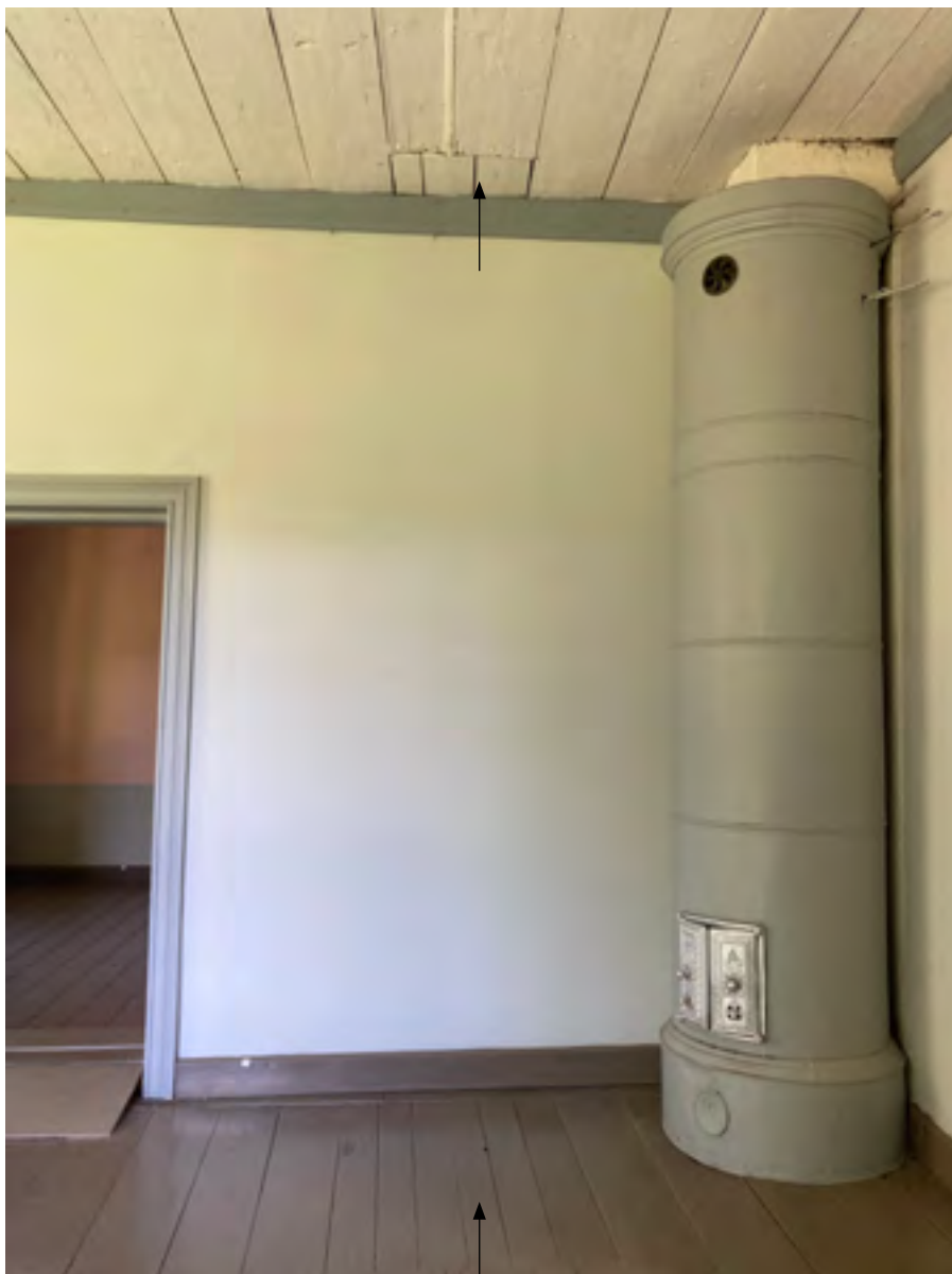
Kamarin h5 koillisseinä vuonna 2023. Puretun uunin kohdalla on sekä lattia- että kattolaudoituksessa paikkapalat. Lattia, katto, listat sekä levytetyt ja pahvitetut seinät on maalattu 1980-luvulla. Peltiuuni on maalattu vaaleanharmaaksi.
