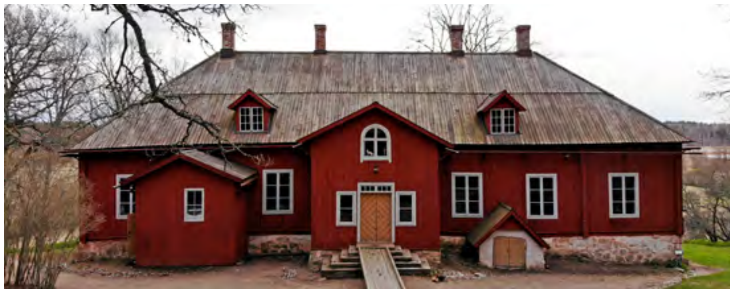
Vuonna 1983 vasemmalta laskien ensimmäinen, kolmas ja neljäs savupiippu purettiin vesikaton tasoon ja muurattiin uudestaan hyödyntäen vanhoja tai vanhankaltaisia tiiliä. Luoteissivun lappeelle aiemmin siirretty keittiön piippu purettiin noin metrin korkeudelle ullakon lattiasta ja uusi piippu muurattiin harjalle, kuten se vuodesta 1756 alkaen oli aiemmin ollut. Tulisijoja ei kunnostettu käyttöön. Kuva on toukokuulta 2022.
