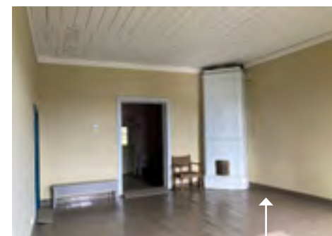
Huoneen lausalattia on mahdollisesti 1700-luvulta. Laudoituksen saumakohdan paikalta on purettu alkuperäinen pitkittäinen väliseinä 1755–1756. Kuva on syyskuulta 2023.
