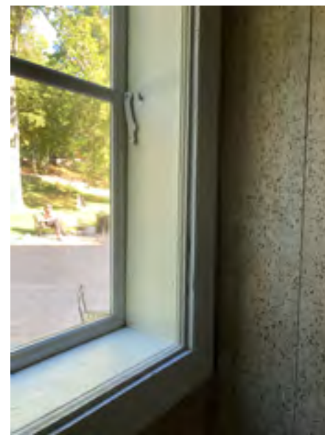
Kuistin seinäautojen konservoitua roiskemaalaukseen ja yksityiskohta luoteissivun 1800-luvun alkupuolen ikkunasta.
