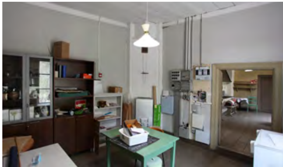
Kamarin h12 seinät koolattiin ja levytettiin vuonna 1988. Etelänurkassa ollut vanha tiilestä muurattu uuni on purettu jo aiemmin. Palomuuria vasten on pieni Rosenlewin valmistama Porin Matti -uuni. Oviaukosta näkyy keittiö h13. Kuva on toukokuulta 2022.
