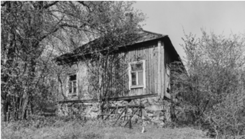
Lounaispäädyn kivijalkaa tuettiin väliaikaisesti. Kuva on vuodelta 1978. Kuva: P. O. Welin / MV.
