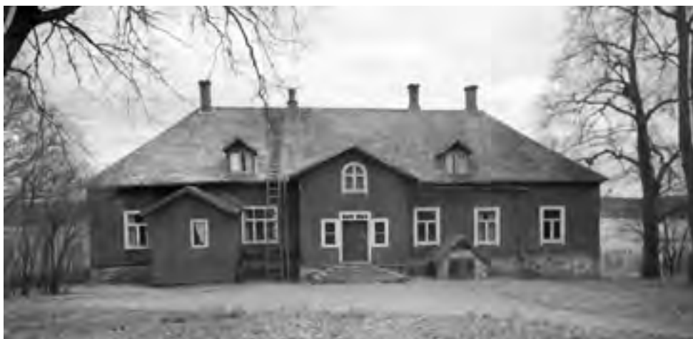
Päärakennus vuonna 1974. Luoteen ja koillisen puoleiset julkisivuverhoilut olivat säilyneet muita sivuja paremmassa kunnossa. Kuva: Lasse Laaksonen / MV.
