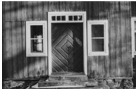
Pääsisäänkäynti vuonna 1974. Ulko-ovi ja yläikkuna ovat vuodelta 1756. Kuisti ja sivuikkunat ovat mahdollisesti 1810-luvulta. Kuva: MV.
