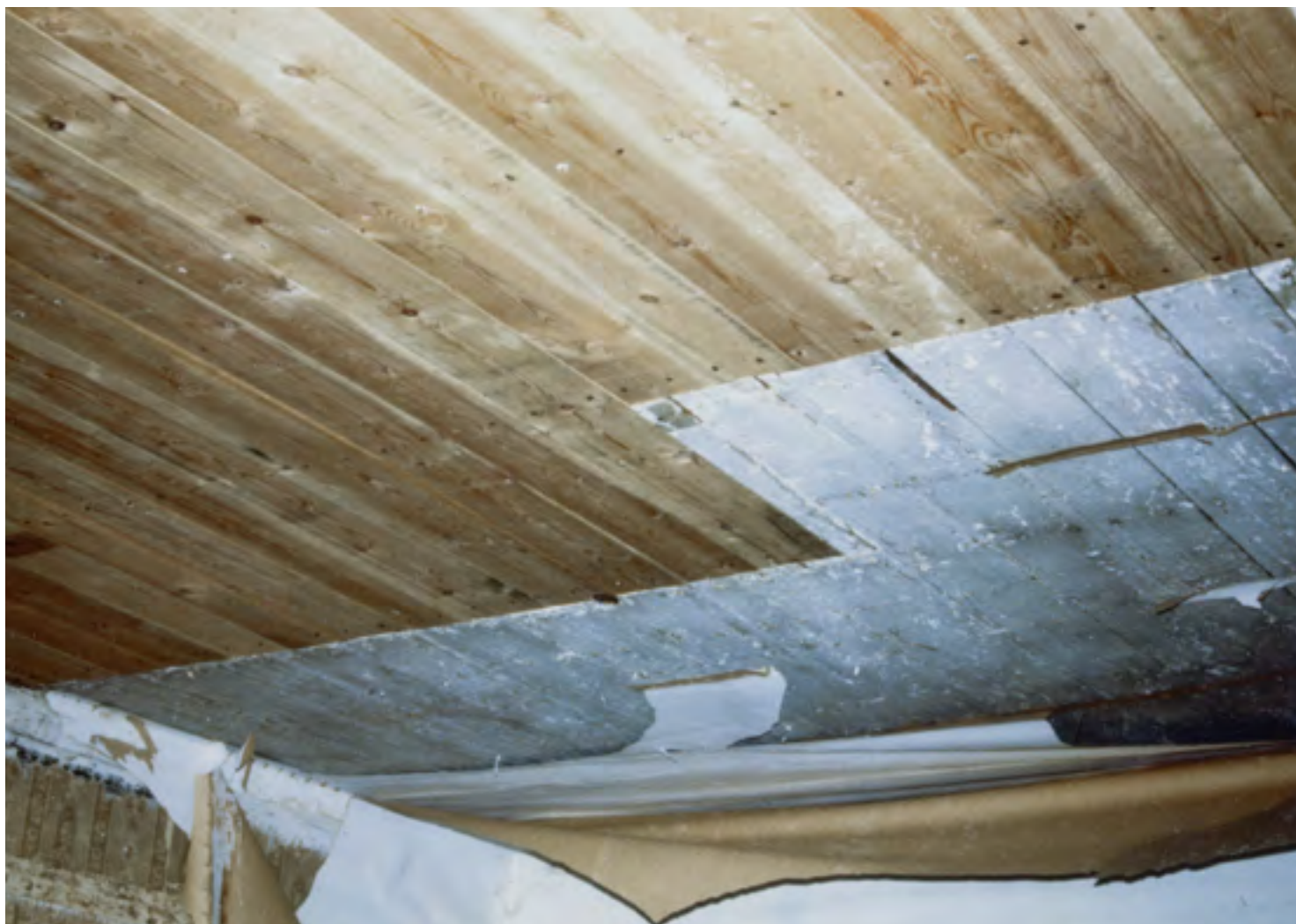
Ruokasalin h8 sisäkatto korjattuna. Osa kattolaudoista uusittiin. Kuva: MV.
