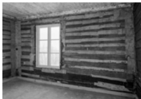
Kulmakamarin h6 lounaisseinä helmikuussa 1988. T-ikkunan paikalle on vaihdettu 6-ruutuinen ikkuna. Kuva: P. O. Welin / MV.
