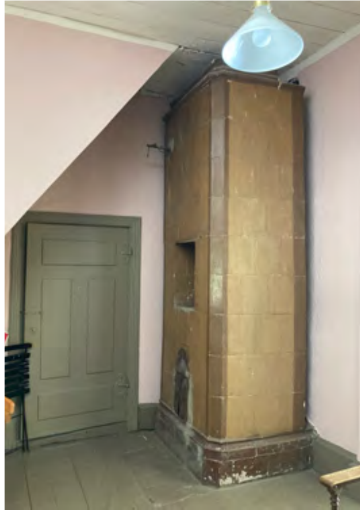
Kattolaudoituksessa on uunin päällä paikkapaloja, joiden kohdalla on voinut olla vanhan ullakonportaan aukko. Keittiön ovi on vuoden 1731 mallikirjan mukainen barokkiovi. Kuva on syyskuulta 2023.
