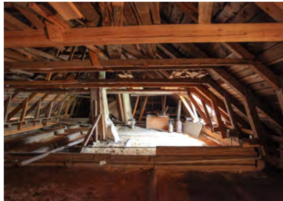
Ullakolle lisättiin 1980-luvulla viisi uutta kattotuolia ja rakenteita vahvistettiin tukiteräksin ja vetotangoin. Kuva on toukokuulta 2022.
