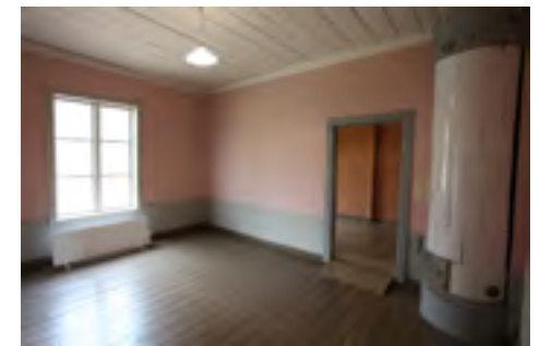
Lautalattia on ajalta 1790–1796. Lattia ja jalkalistat ja kattolaudoitus maalattiin vuonna 1988.
