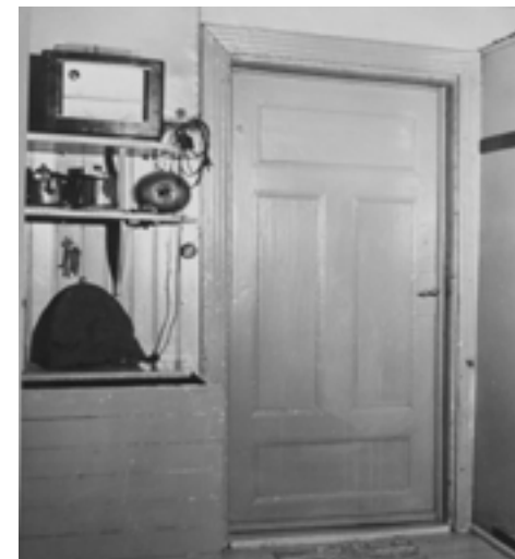
Keittiö h13 vuonna 1966. Kolmella seinällä oli rintapaneelit. Seinien yläosassa oli pahvit ja katossa Halltex-levyt. Vasemmalla näkyvä tiskipöytä ja oikealla nurkassa näkyvä kiintokomero purettiin 1980-luvulla. Oviaukosta näkyy eteinen h2. Kuva: P. O. Welin / MV.
