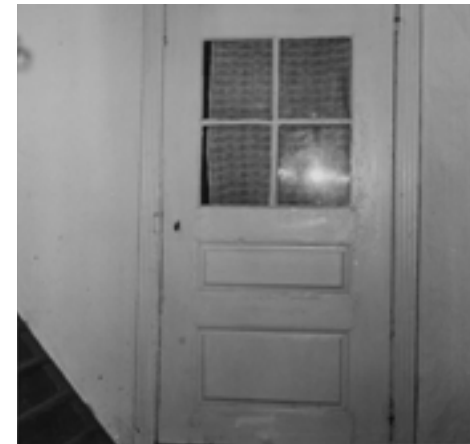
Ovi pääkuistilta eteiseen. Tämän oven paikalla on sijainnut 1800-luvun alkupuolelle asti ulko-ovi. Kolmipeilisen oven ylimpään peillin on laitettu lasi. Vasemmalla näkyy vintille johtava porras. Kuva: Elias Härö 1966 / MV.
