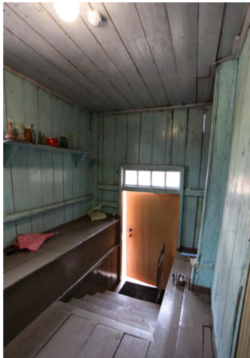
Keittiön kuistin ulko-ovi uusittiin vuonna 1988. Yläikkuna on yhtä vanha kuin kuisti eli 1800-luvulta.
