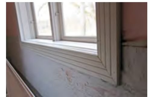
Ulkoseinän alaosassa on vanhaa puolipaneelia, joka on maalattu vuonna 1988. Kuva on syyskuulta 2023.
