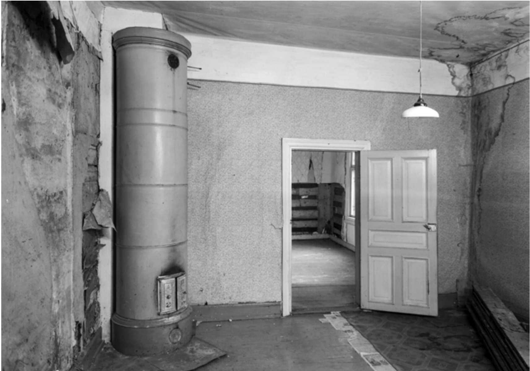
Kamari h5 vuonna 1978. Seinäpintaa on avattu. Oviaukosta näkyy kulmakamari h6. Itänurkassa on peltipönttöuuni. Etelänurkassa on vesivaurion jälkiä. Osa kuvioidusta korkkimatosta on jo purettu. Kuva: P. O. Welin / MV.
