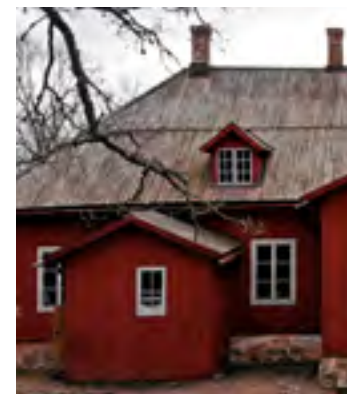
Keittiön ikkunaa on kavennettu 1980-luvulla. Kuva on vuodelta 2022.
