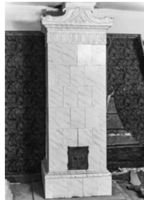
Salin h7 Fortuna-uuni vuonna 1978. Repeytyneen seinätapetin alta on paljastunut alkuperäistä hirsiseinää. Kuva: P. O. Welin / MV.
