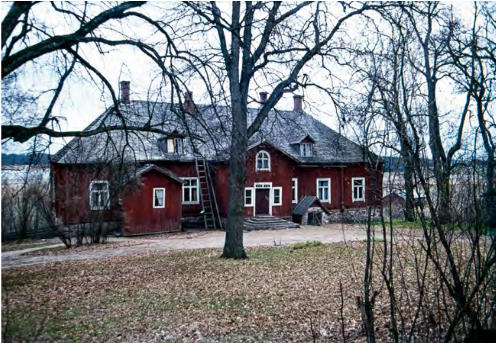
Kuusiston kartanon päärakennus ennen museoksi muuttamista vuonna 1974. Pääosa ikkunoista oli vuoden 1911 T-ikkunoita. Katemateriaalina oli huonokuntoinen päre. Katon harjalla on kolme savupiippua, neljäs piippu sijaitsee luoteen puoleisella katon lappeella. Kuva: Veijo Laine / MV.
