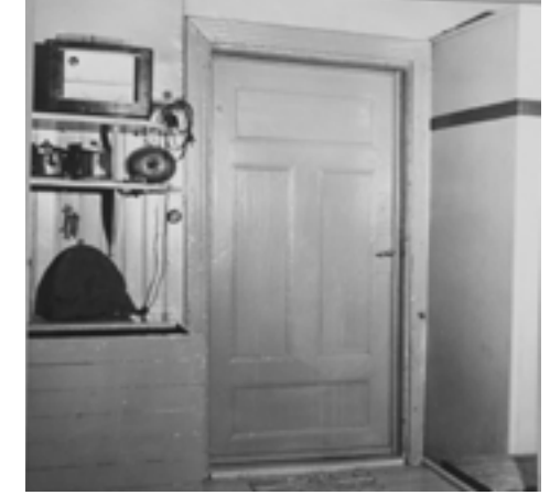
Keittiöstä eteiseen johtava ovi on "niin sanottu päällyspeilillä varustettu puoliranskalainen ovi" (Lounatvuori 1966, 13).
