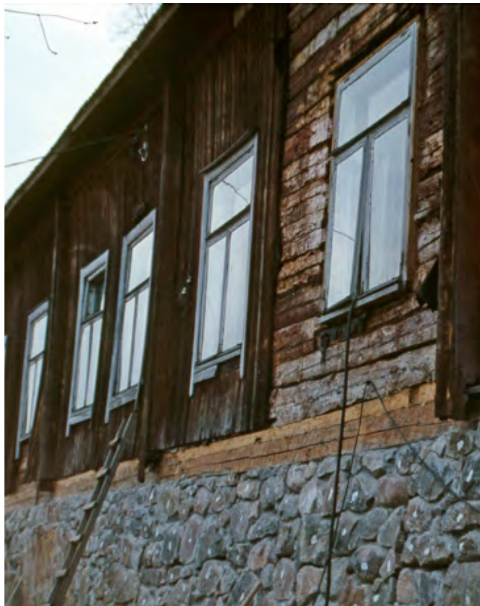
Kaakkoissivu vuonna 1980. Osa huonokuntoisista vuorilaudoista on poistettu ja alimpia hirsä on uusittu. Kuva: Teresia Ijäs / MV.
