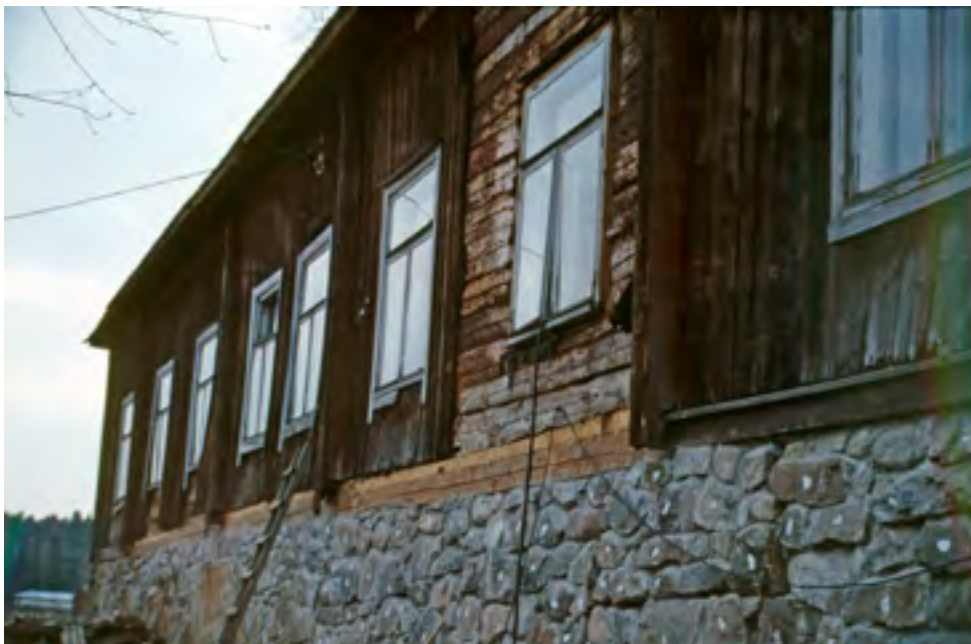
Kaakkoissivu vuonna 1980. Kivijalan sortuneita alueita on purettu ja muurattu uudelleen. Osa huonokuntoisista vuorilautoista on poistettu ja alimpia hirsii on uusittu. Kuva: Teresia Ijäs / MV.
