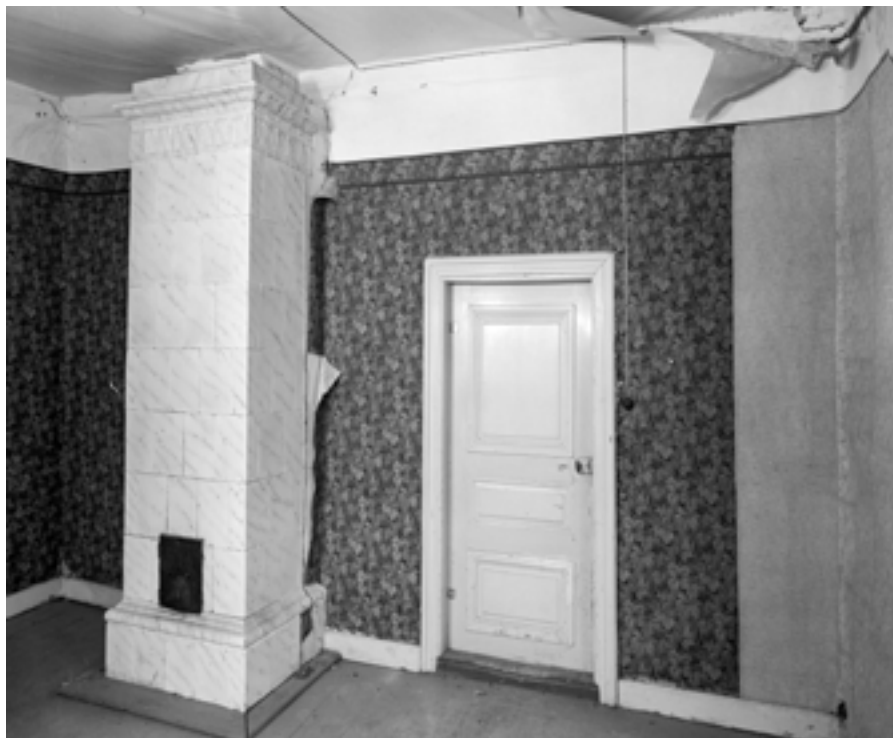
Kulmakamari h6 vuonna 1978. Seinät oli tapetoitu, yläosa seinistä oli maalattu samaan valkeaan sävyyn kuin kattopaperi, joka näkyy kuvassa repaleisena. Kuva: P. O. Welin / MV.
