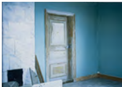
"Sisätyöt loppusuoralla. Fortuna-tehtaan uuni korjattuna ja empiretyylinen ovi odottamassa maalisilausta." Seinät maalattiin vihreiksi, kuva vääristää värejä. Kuva: MV.
