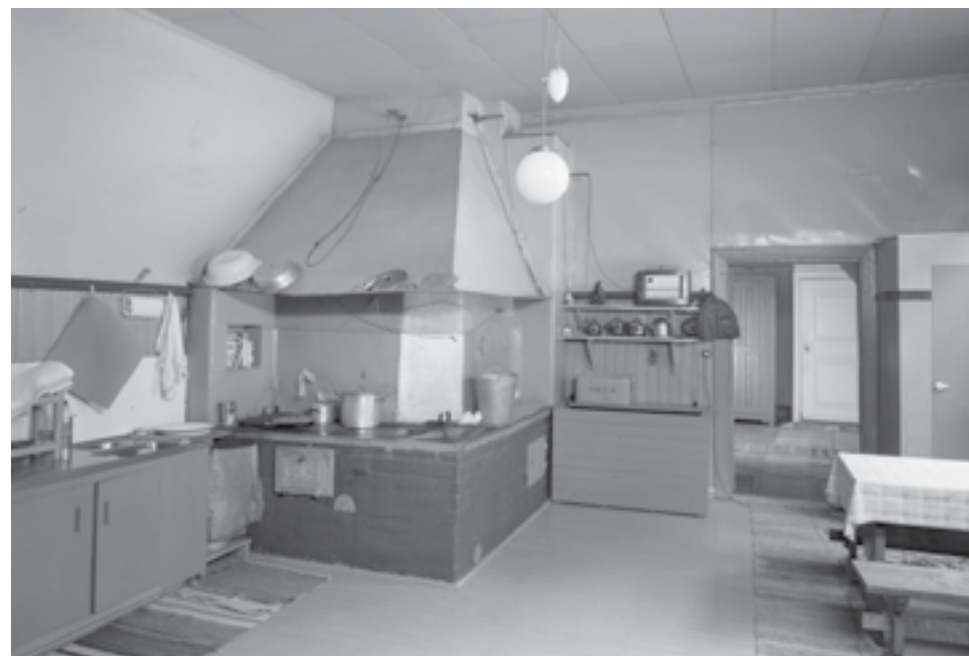
Keittiö h13 vuonna 1966. Kolmella seinällä oli rintapaneelit. Seinien yläosassa oli pahvit ja katossa Halltex-levyt. Vasemmalla näkyvä tiskipöytä ja oikealla nurkassa näkyvä kiintokomero purettiin 1980-luvulla. Oviaukosta näkyy eteinen h2. Kuva: P. O. Welin / MV.
