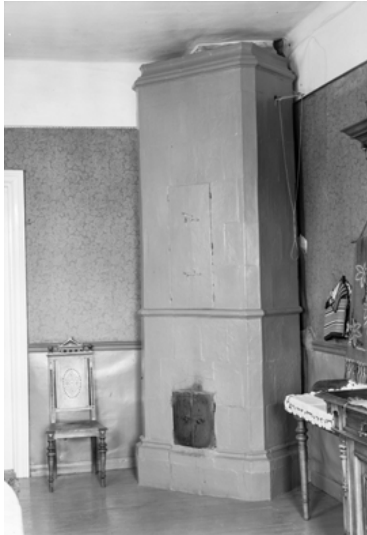
Ruokasalin h8 lasittamaton uuni vuonna 1966. Suorakulmaisen tiililattauinin yläosassa on kaappikomero eli lämmityskaappi. Uunissa on peltinen suuluukku. Ruskean maalin alla oli harmaa, vaalean ruskea ja alinna valkea maali. (Lounatvuori 1966, 10. MV.) Kuvasta käy ilmi, että huoneessa oli tällöin rakennuksen suhteen pituussuuntainen uudempi laualattia, jonka alla ollut vanhempi, poikittaissuuntainen lattialauta on otettu 1980-luvulla esiin. Kuva: Welin / MV.
