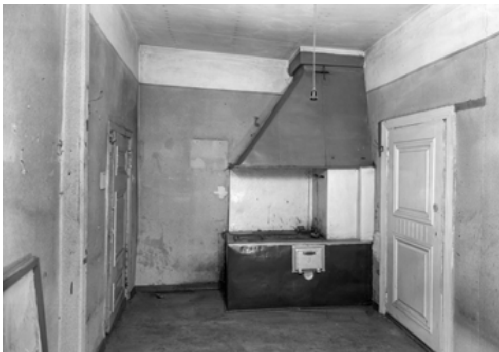
Kamari h3 vuonna 1978. Kulmassa ollut, väliaikaista asumista palvellut liesi purettiin 1980-luvun kunnostustöiden yhteydessä. Vasemmalla näkyy huoneeseen 8 johtava ovi, oikealla huoneeseen 4 johtava ovi. Koillisseinässä oli hirsiseinän päällä kaksi tukipalkkia eli följaria, joista toinen näkyy vasemmalla kuvassa. Katossa oli pahvi. Huoneessa oli lautalattia. Kuva: P. O. Welin / MV.
