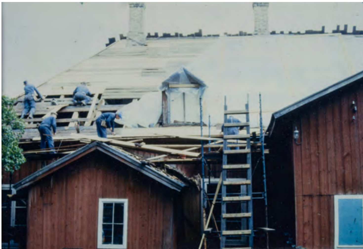
Päärakennuksen huonokuntoinen pärekate purettiin ja korvattiin 1750-luvun mallisella lautakat- teella. Oikeanpuoleinen piippu on siirretty katon harjalle. Kuva on aikaväliltä 1983–1985. Kuva: MV.
