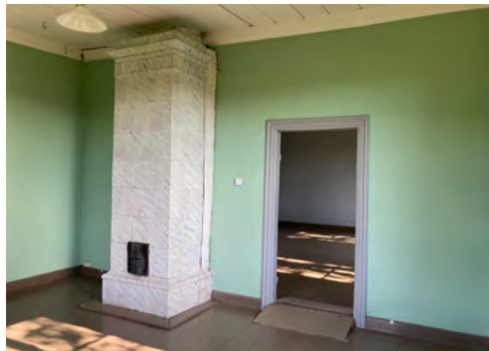
Kulmakamarin h6 hirsiseiniin on vuonna 1988 pingotettu mahdollisesti pellavakankaat, joihin on kiinnitetty makulatuuri-paperit. Seinät, kattolaudoitus ja lattia on maalattu. Kuva on syyskuulta 2023.
