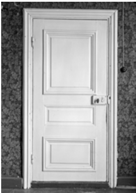
Salin h7 ja ruokasalin h8 välinen ovi vuonna 1966. Kustavilaistyylinen ovi on aikaväliltä 1770–1797. Ovessa on empiresaranat ja rokokootyyliset listat. Kuva: P. O. Welin / MV.
