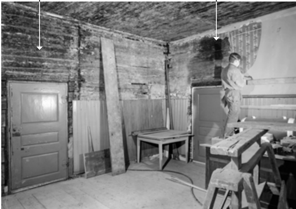
Keittiön seiniä avataan helmikuussa 1988. Kuva on otettu kohti itänurkkaa. Kuva: P. O. Welin / MV.
