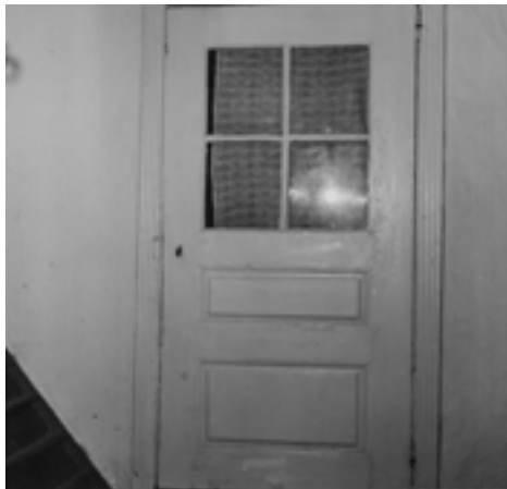
Ovi pääkuistilta h1 eteiseen h2. Vasemmalla näkyy ullakolle johtava porras.
