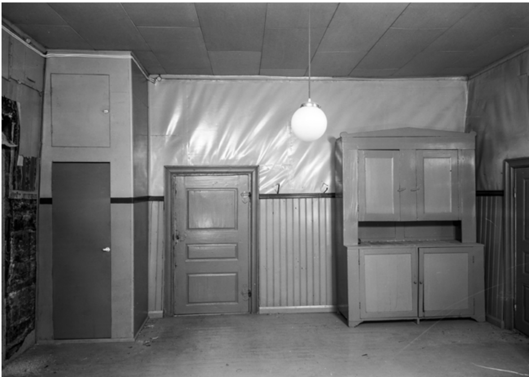
Keittiön koillisseinä ennen avauksia vuonna 1978. Vasemmalla näkyvä itänurkan komero purettiin 1980-luvulla. Kuva: P. O. Welin / MV.
