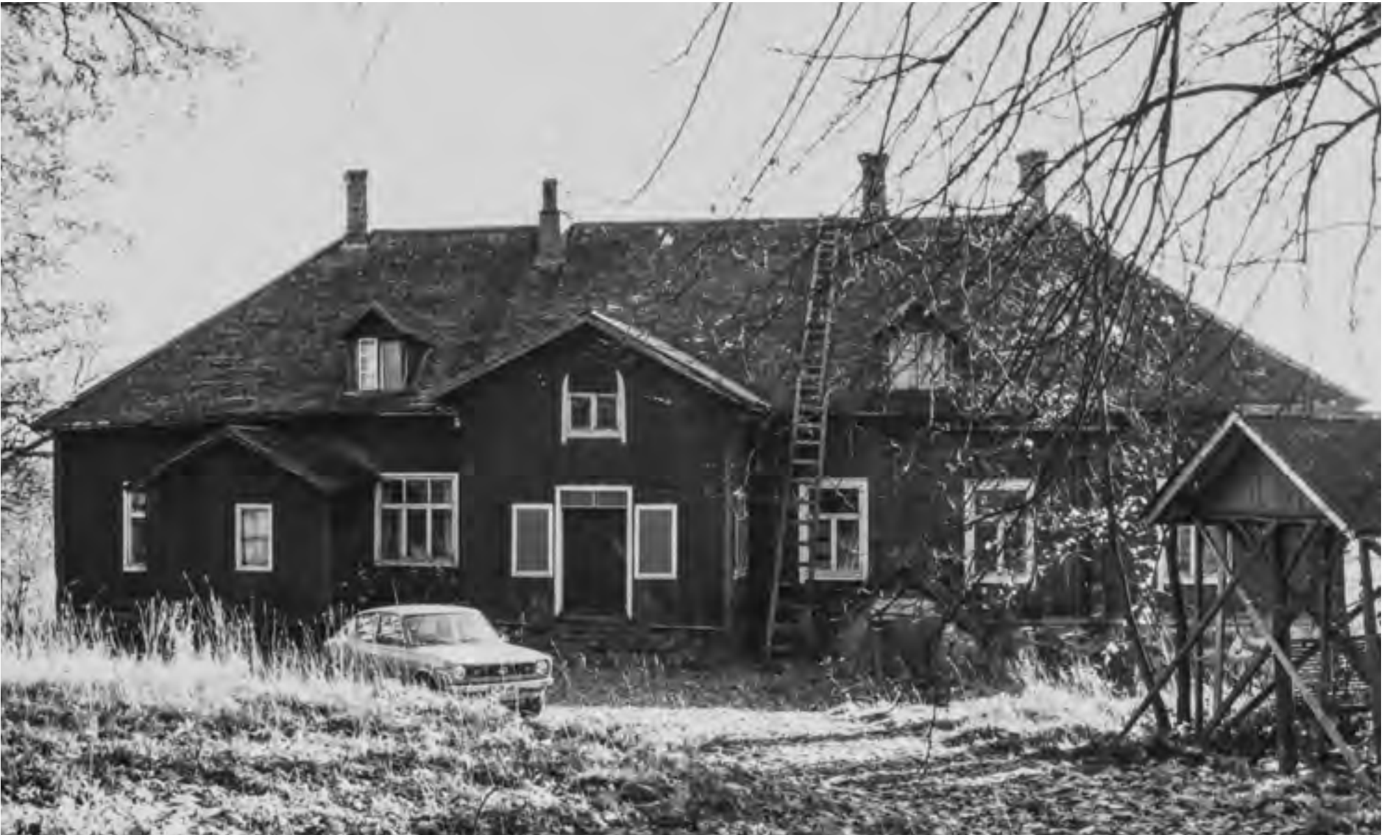
Luoteissivu vuonna 1979. Osa ikkunoista on levytetty umpeen. Ullakon 12-ruutuiset ikkunat on mahdollisesti nostettu pois ja kummassakin aukossa on levyn edessä vain yksi kolmiruutuinen ikkunapuite. Kuva: Veijo Laine / MV.
