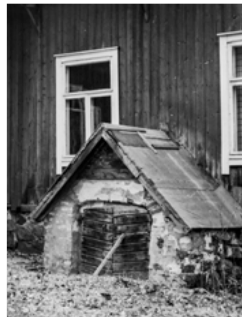
Kellarin sisäänkäynti vuonna 1974. Ulko-ovi oli huonokuntoinen. Sisäänkäynnin harjakatossa oli tervahuopakate. Kuva: Veijo Laine / MV.
