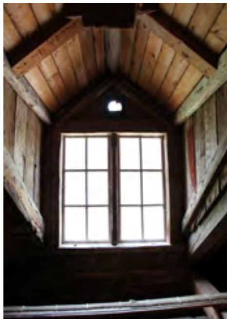
Kattolyhtyjen ikkunoissa on kuusiruutuiset ikkunapuitteet. Pystyvälirkarmissa on veistetty profiili ja se vaikuttaa vanhalta. Puitteet ovat joko kunnostettuja tai uusittuja.
