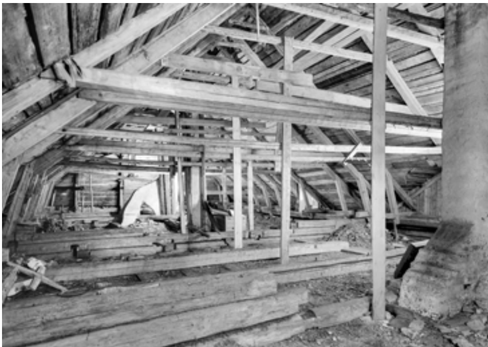
Ullakko ennen muutostöitä vuonna 1978. Vuoden 1756 kattotuoleihin on lisätty tukirakenteita. Vesikaton aluslaudoitus oli tehty entisistä vesikattolaudoista (Kaila 24.3.1982, 1. MV RHO). Kuva: P. O. Welin / MV.
