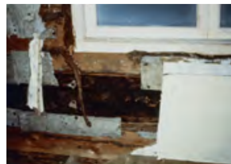
Vihreän kulmakamarin h6 kuntoa tutkittaessa paljastui suuri määrä erilaista rakennusmateriaalia. Kuva: MV.
