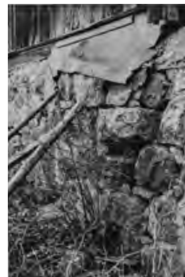
Kaakkoissivun osittain sortunut kivi-jalka vuonna 1974. Kuva: MV.
