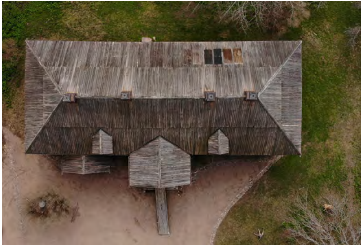
Päärakennukseen tehtiin vuosien 1985–1986 aikana painekyllästetyistä laudoista tehty kaksinkertainen lautakate, joka tervattiin. Kuva on toukokuulta 2022. Koillislappeella on 2020-luvun käsittelykokeiluja.
