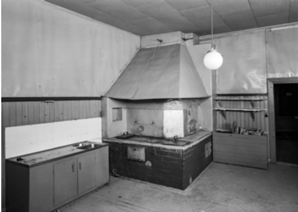
Keittiö ennen avauksia vuonna 1978. Lähes kaikki oli ennallaan verrattuna vuoden 1966 tilanteeseen. Kuva: P. O. Welin / MV.
