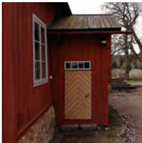
Keittiön kuistin h14 ulko-ovi uusittiin 1980-luvulla. Oven yläpuolinen neliruutuinen ikkuna on yhtä vanha kuin kuisti eli 1800-luvulta.
