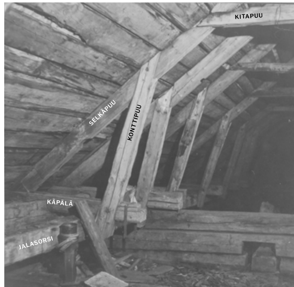
Ullakon kaakkoissivun vesikattorakenteita vuonna 1966. Katto oli rakennettu vuonna 1756, jolloin päärakennuksen kattoa korotettiin nykyiseen muotoonsa. Etualalla näkyy ruokasalin h8 lounaan puoleisen poikkiseinän yläosa. Oikealla ylhäällä näkyy kattotuolin alin kitapuu. Oikealla alhaalla on salin läntinen poikkiseinä. Kuva: Elias Härö / MV. Kuvaan on lisätty konttikattotuolien osien nimitykset.
