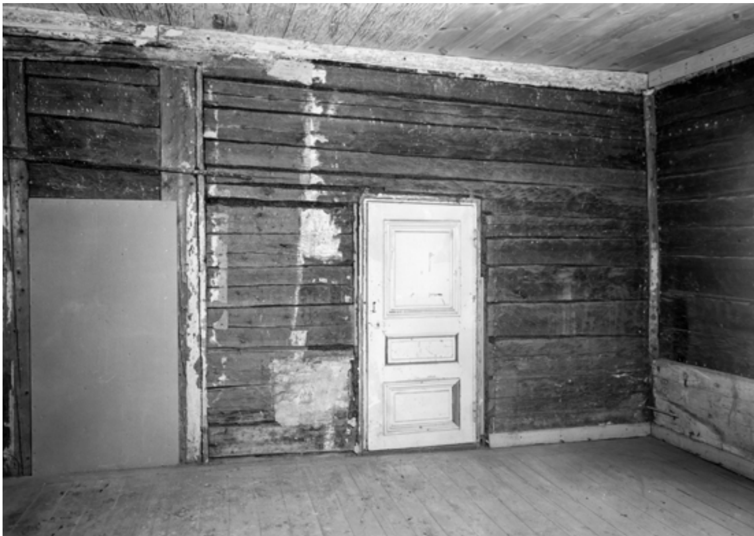
Kamarin h4 lounaisseinä helmikuussa 1988. Entisen garderoabin oviaukko on levytetty umpeen. Oviaukkojen välistä seinää vasten on sijainnut uuni vuodesta 1756 aina 1800-luvulle. Oikealla näkyvän ulkoseinän alaosassa on vaakaponttilaudasta tehdyn vanhan rintapaneelin fragmentti. Ulkoseinää lähinnä olevat kattolaudat on uusittu vuotovaurion vuoksi. Kuva: P. O. Welin / MV.
