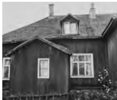
Keittiön kuisti ja keittiön leveä ikkuna vuonna 1979. Kuva: Veijo Laine / MV.
