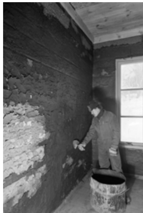
Savirappauskokeilu kamarissa h3 helmikuussa 1988. Kattolaudoitusta on uusittu läheltä ulkoseinää. Ikkuna on uusittu jo vuonna 1983. Kuva: P. O. Welin / MV.
