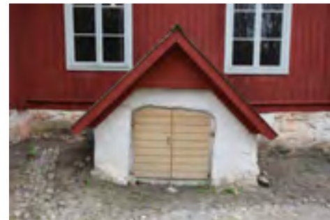
Kellarin sisäänkäynnin ulko-oven ulkopuolinen panelointi ja katoksen vesikate uusittiin 1980-luvulla.
