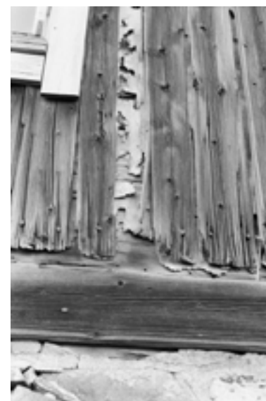
Auringon kuluttamaa ulkovuorausta. Kuva: Margaretha Ehrström / MV.
