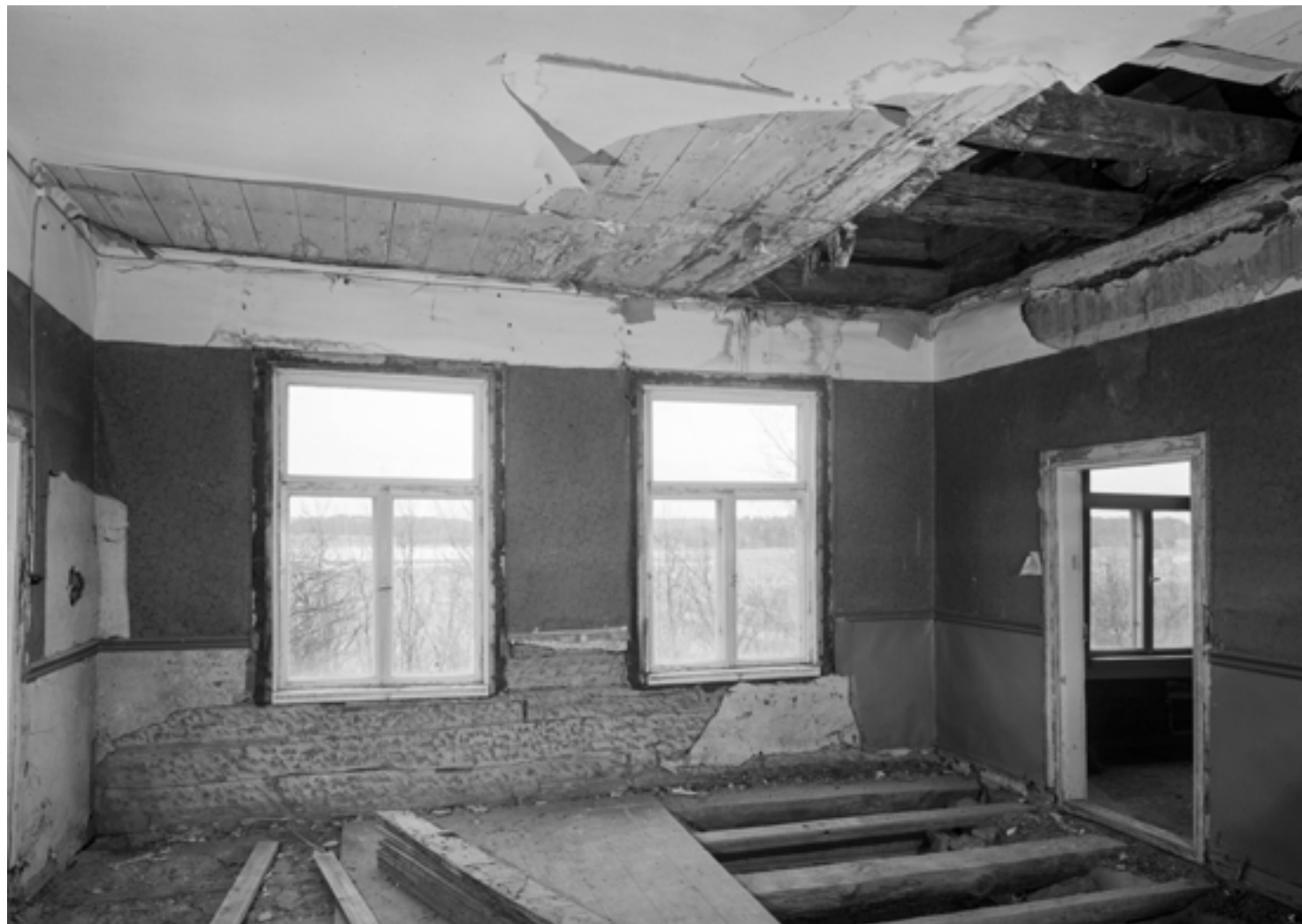
Ruokasali h8 kuvattuna kohti kaakkoa vuonna 1978. Rakenteita on avattu: lattian ja sisäkaton laudoitusta on purettu, seinätapettia on poistettu. Huoneessa on vielä vuoden 1911 T-ikkunat. Lounatuuren ja Kailan tekemien tutkimusten ja havaintojen mukaan huoneessa olisi ollut alun perin kahden ikkunan sijaan vain yksi ikkuna, joka sijaitisi vuosien 1738–1756 aikana nykyisten ikkunoiden välissä. Hirren päällä on ollut tikutus ja savilaastilla tehty rappaus. Kuva: P. O. Welin / MV.
