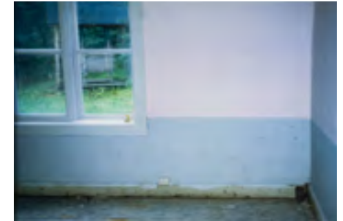
Kamarin h4 luoteen puoleinen ulkoseinä vuonna 1988. Kosteat ja lahot laudat ja tapetit poistettiin ja uudet pinnat maalattiin vanhoilla sävyillä. Uudet ikkunat on jo asennettu. MV.
