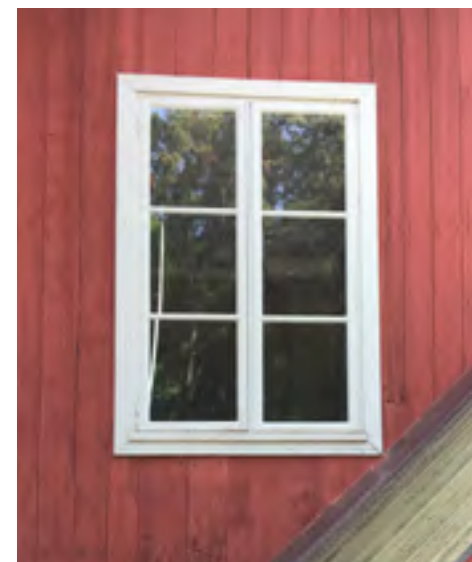
Kamarin h3 ikkuna luoteeseen ulkoa katsottuna. Ikkunapuitteet ovat julkisivulaudoituksen kanssa samassa tasossa.
