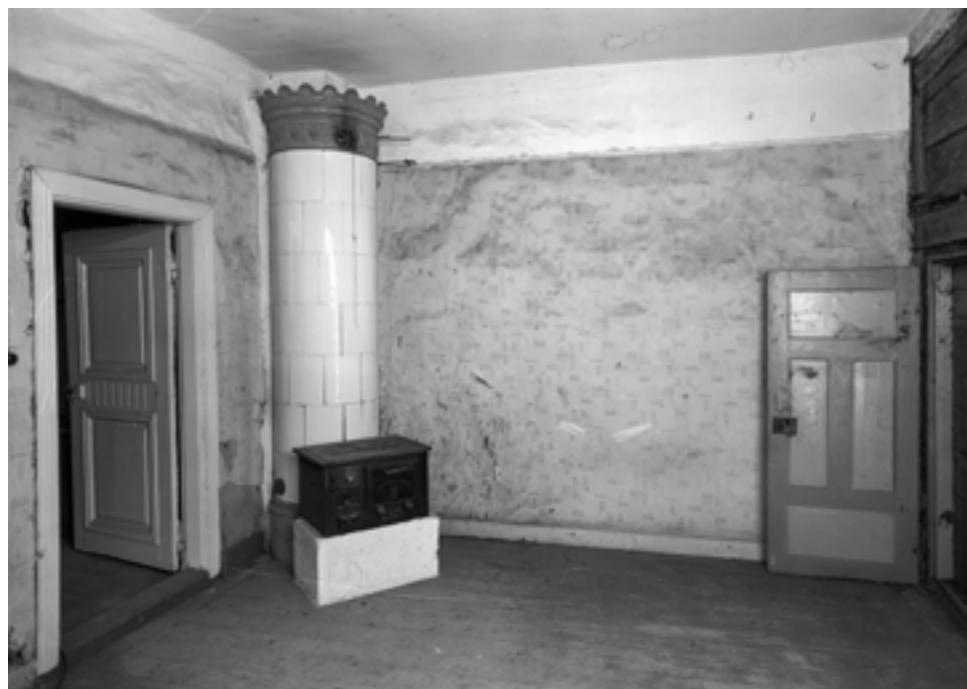
Kamari h4 vuonna 1978. Oikealla näkyy seinän sisältä löydetty barokkiovi. Uunin edessä näkyvä pieni hella purettiin restaurointitöiden yhteydessä. Uuusrenessanssityylinen uuni on 1800-luvun lopulta. Katto oli valkean pahvin peittämä. Kuva: P. O. Welin / MV.
