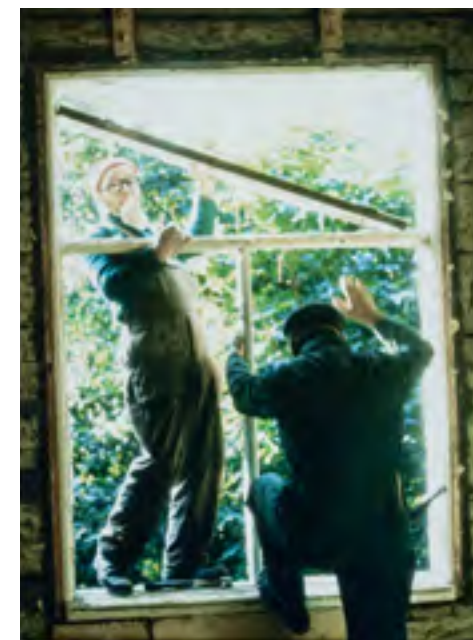
Vanhat, vuoden 1911 T-ikkunat irrotettiin karmeineen ja korvattiin uusilla 6-ruutuisilla ikkunoilla. Päärakennus sai 1800-luvun alkupuolen ulkonäön. Kuva on vuodelta 1983. MV.
