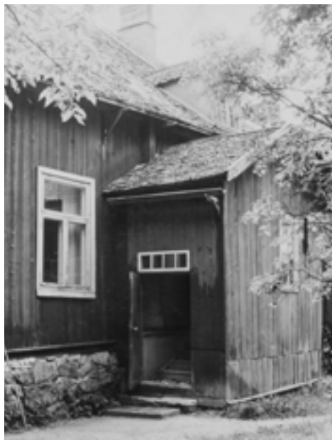
Keittiön kuistin sisäänkäynti vuonna 1967. Kuva: Elias Härö / MV.
