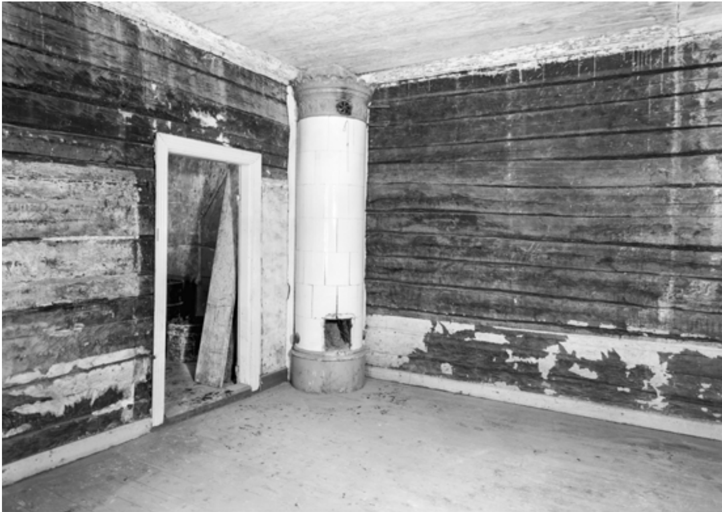
Kamari h4 helmikuussa 1988. Uunin edessä sijainnut hella on purettu, uuninluukkuja ei ole vielä hankittu. Kattolaudoitus on otettu esiin poistamalla kattopahvi. Tapetit on poistettu, mutta uunin sivulle on kuvan perusteella saatettu jättää pätkä vanhaa tapettia. Uunin oikeanpuoleinen pitkittäinen väliseinä on vuodelta 1756. Jos seinässä olisi käytetty seinän siirtämisen yhteydessä vuoden 1738 hirsiä, pitäisi uunin sivulla näkyä oviaukon paikka. Jos taas kyseisessä seinässä ei vuoden 1731 mallipiirustuksesta poiketen olekaan ollut alun perin oviaukkoa, on mahdollista, että hirret on uudelleen käytetty seinän siirron yhteydessä vuonna 1756. Kuva: P. O. Welin / MV.
