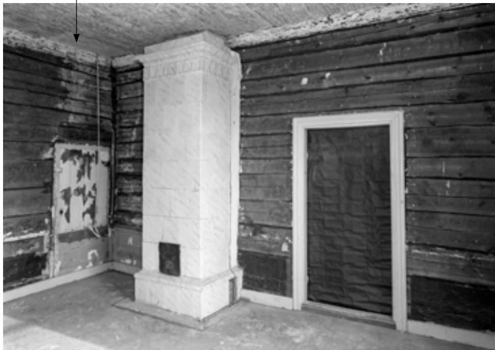
Kulmakamari h6 helmikuussa 1988. vasemmalla puolella näkyy 1790-luvulla rakennetun garderoabin ovi, joka on otettu pois käytöstä noin vuonna 1911. Nurkassa on kahdella seinällä paneelia. Kuvan vasemmassa reunassa näkyy hirressä kirjoitus "Ramstedt 1815". Kuva: P. O. Welin / MV.
