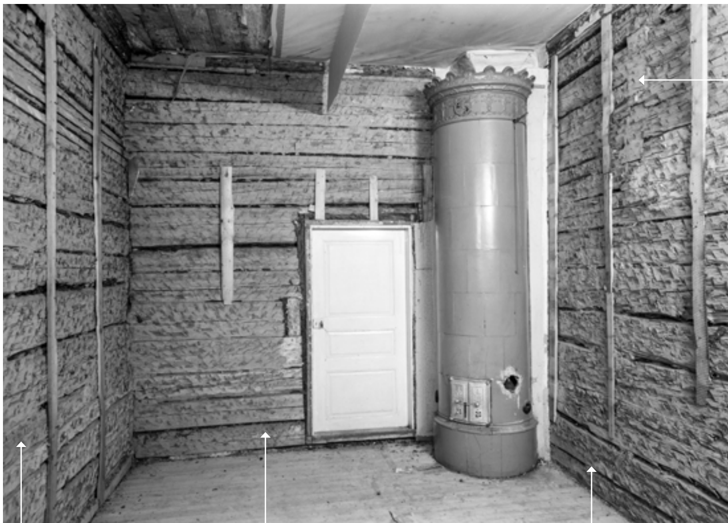
1755–1756 rakennettu, kabinetin h9 vastainen seinä
