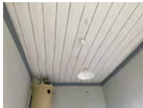
Kabinetin h9 vanha lattialaudoitus ja lautakatto on otettu 1980-luvulla esiin ja maalattu. Katto- laudoituksessa on sauma puretun alkuperäisen seinän kohdalla. Listat on uusittu. Uunin runko ja kruunu on maalattu samaan sävyyn. Kuva on syyskuulta 2023.
