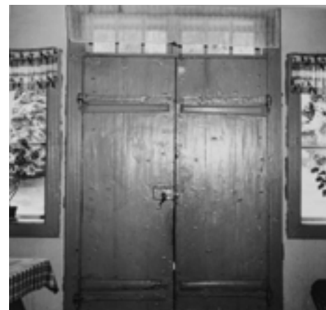
Pääkuistin ulko-ovi vuonna 1966. Ovesta on suuret saranat ja vaakasuorat tuet. Oven sivuilla olevissa kaksiruutuisissa ikkunoissa on rihlatut vuorilaudat. Kuva: Elias Härö / MV.
