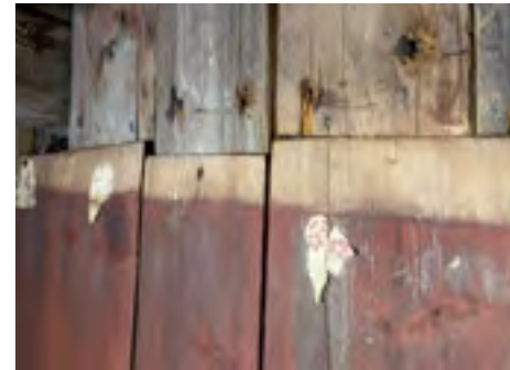
Pääkuistin vintin kaakkoissivu on entistä ul- koseinää, jossa on vanhaa lautaverhoilua sekä poistettujen tapettien paloja.
