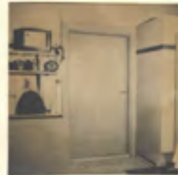
Eteiseen vievä ovi. Ovi on ns. pölyllyspeilillä varustettu puolirenskalainen ovi.
