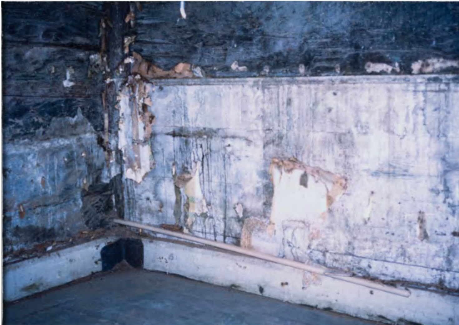
Yksityiskohta kamarin h4 nurkasta. Museoviraston arkistossa säilytettävän Kuusiston kartanon kuva-albumin kuvatekstissä lukee näin: "Hiiret ja hämähäkit asustivat tapettikerrosten alla, mistä löytyi myös kappale alkuperäistä puista rintapaneelia." Lounatuoreen ja Kailan huoneinventoinnissa (1978–1987) paneeli on tosin ajoitettu vuoteen 1756.
