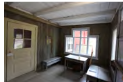
Pääkuistin lounaissivun ikkunassa on neljä puitetta, joista keskimmäiset ovat kaksiruutuisia ja sivuilla olevat yksiruutuisia.
