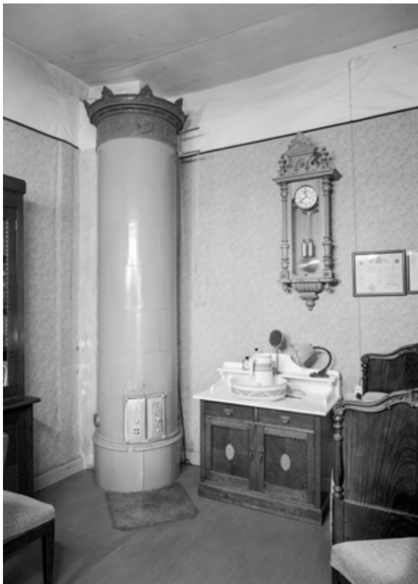
Kabinetin h9 uuni vuonna 1966. "Uuni: pyöreä tiillaattuuni, uusi suuluukku. Jalkalista: 11,5 cm korkea, suora, yläreunassa kevyt profilointi. Lattia: korkkimatto. Katto: valkealla pahvilla peitetty. Seinät: tapetit, tapetin alla rappauspinta." (Lounatvuori 1966, 11.) Kuva: P. O. Welin / MV.
