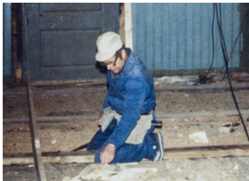
Vesikaton ja keittiön korjaustöitä 1980-luvulla. Kuvat: MV.
