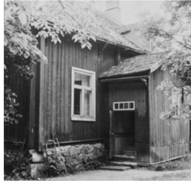
Keittiön kuistin sisäänkäynti vuonna 1967. Kuva: Elias Härö / MV.
