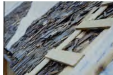
Asumattomuus oli kohtalokasta pääraken- nuksen rakenteille. Pärekattoa oli paikkailtu 1960-luvulla, mutta päreet olivat hajalla jo 1970-luvun lopulla. Kuva on Museoviraston valokuva-albumista.
