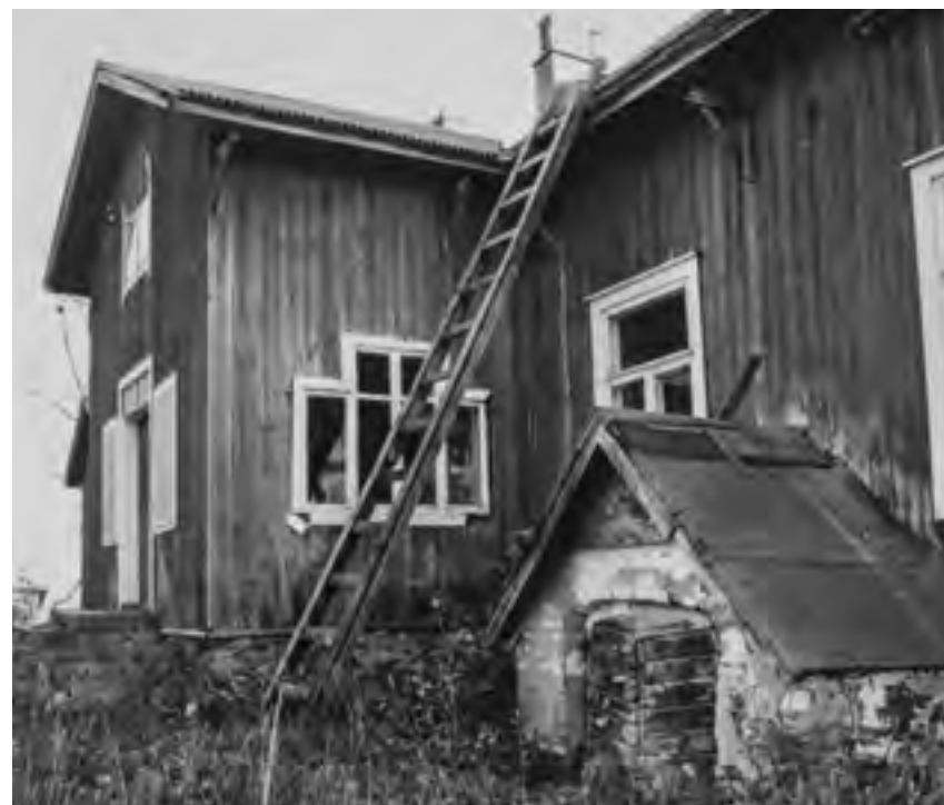
Osa pääkuistin ikkunoista oli vuonna 1979 levytettyinä, kun vanhat puitteet oli nostettu suojaan. Kuva: Veijo Laine / MV.
