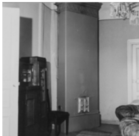
Kamari h11 vuonna 1966. Huoneessa oli lautalattia, profiloimattomat jalkalistat ja tapetoidut seinät. Kuva: Elias Härö / MV.
