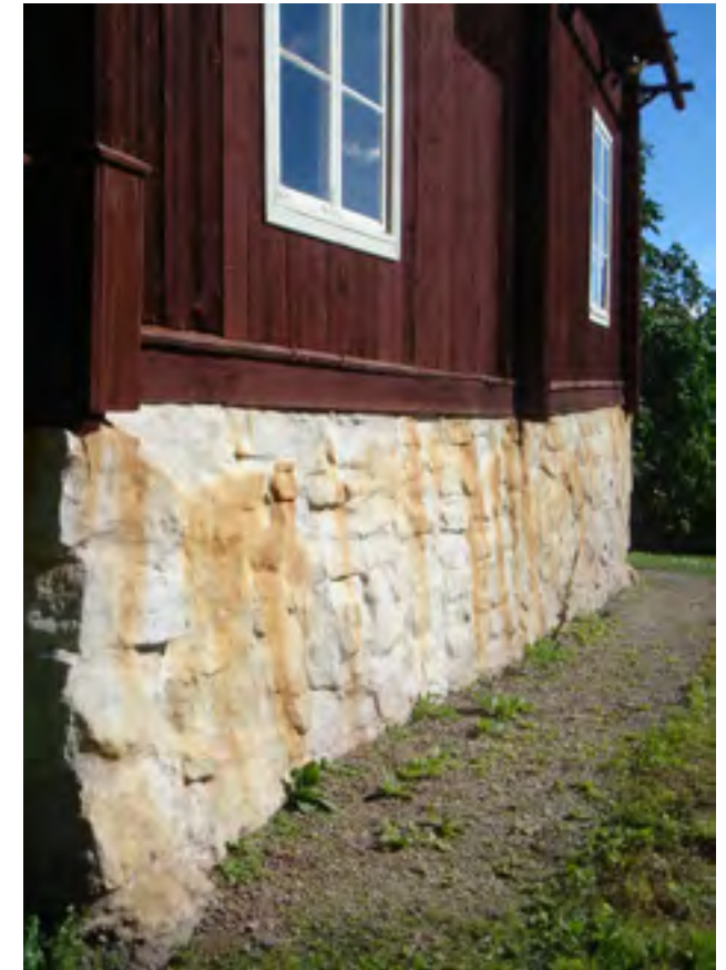
Osa lounaispäädyn sokkelista ladottiin, muurattiin ja slammattiin uudelleen 1980-luvulla. Kuva: Kiinteistöyksikkö 2004 / Sk BEM.
