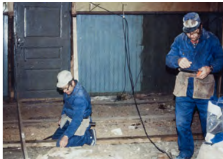
Keittiön lattiavasoja korjattiin. Osa 1800-luvun lopun seinäpaneeleista uusittiin. Kuva: MV.
