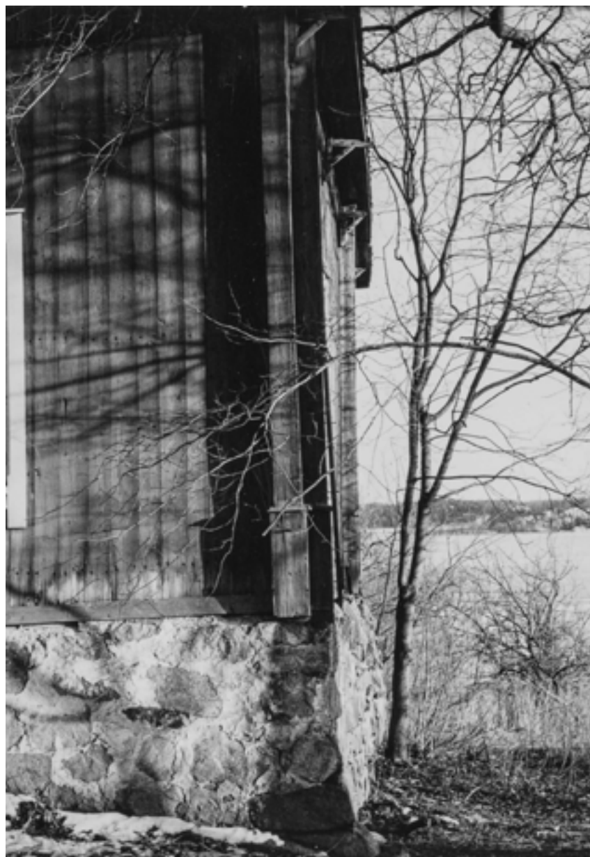
Talon länsinurkka vuonna 1974. Kuvassa näkyy viistosti lounaispäätty ja sen pullistunut kivijalka. Kuva: MV.
