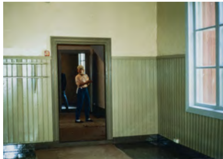
"Keittiö valmiina vastaanottamaan eväidensyöjät ja kahvinjuojat." Valmis keittiö vuonna 1989. Länsinurkan kiintokomero on purettu. Ikkunaseinäänkin on tehty rintapaneelit. Kuva: MV.
