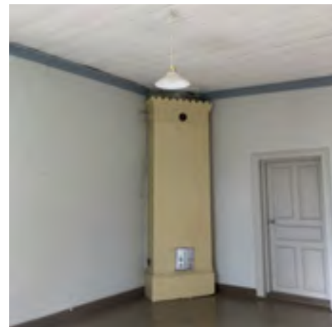
1980-luvulla kamarin h11 seinät levytettiin, kattopaperi poistettiin ja lattialauditus uusittiin. Kuva on vuodelta 2023.
