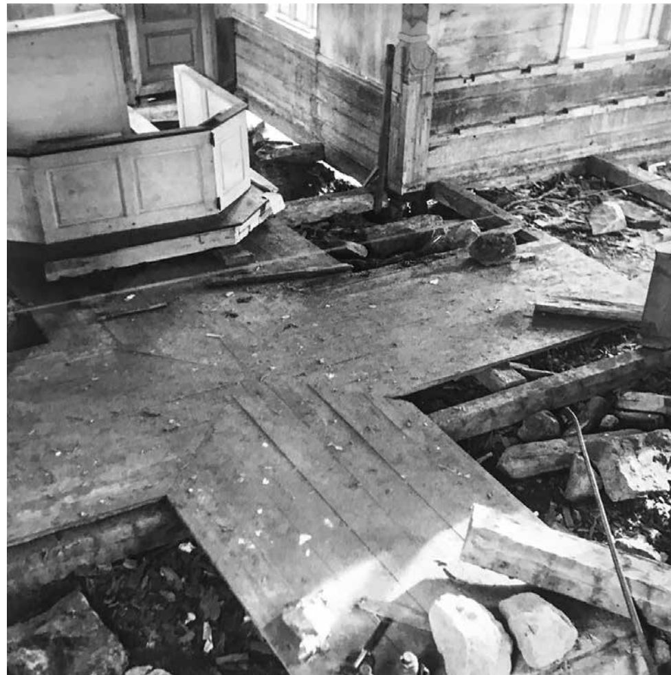
Ristikeskuksen lattiarakennetta vuosien 1973–74 työmaan aikana. 14457, MV, digitoimaton.
