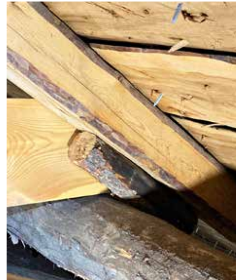
Vesikattoa on ristikeskuksessa nostettu parikymmentä senttiä: kurkihirret on pönkätty ja vasat kiilattu ylemmäs.
