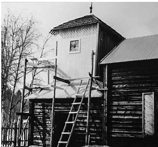
Valokuva vuodelta 1974 ennen paanujen asennusta alumiinikatteen päälle. Museovirasto.
