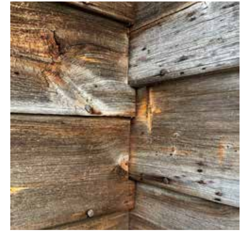
Verhoilulautojen huolellista sovitusta kirkon sisänurkassa.
