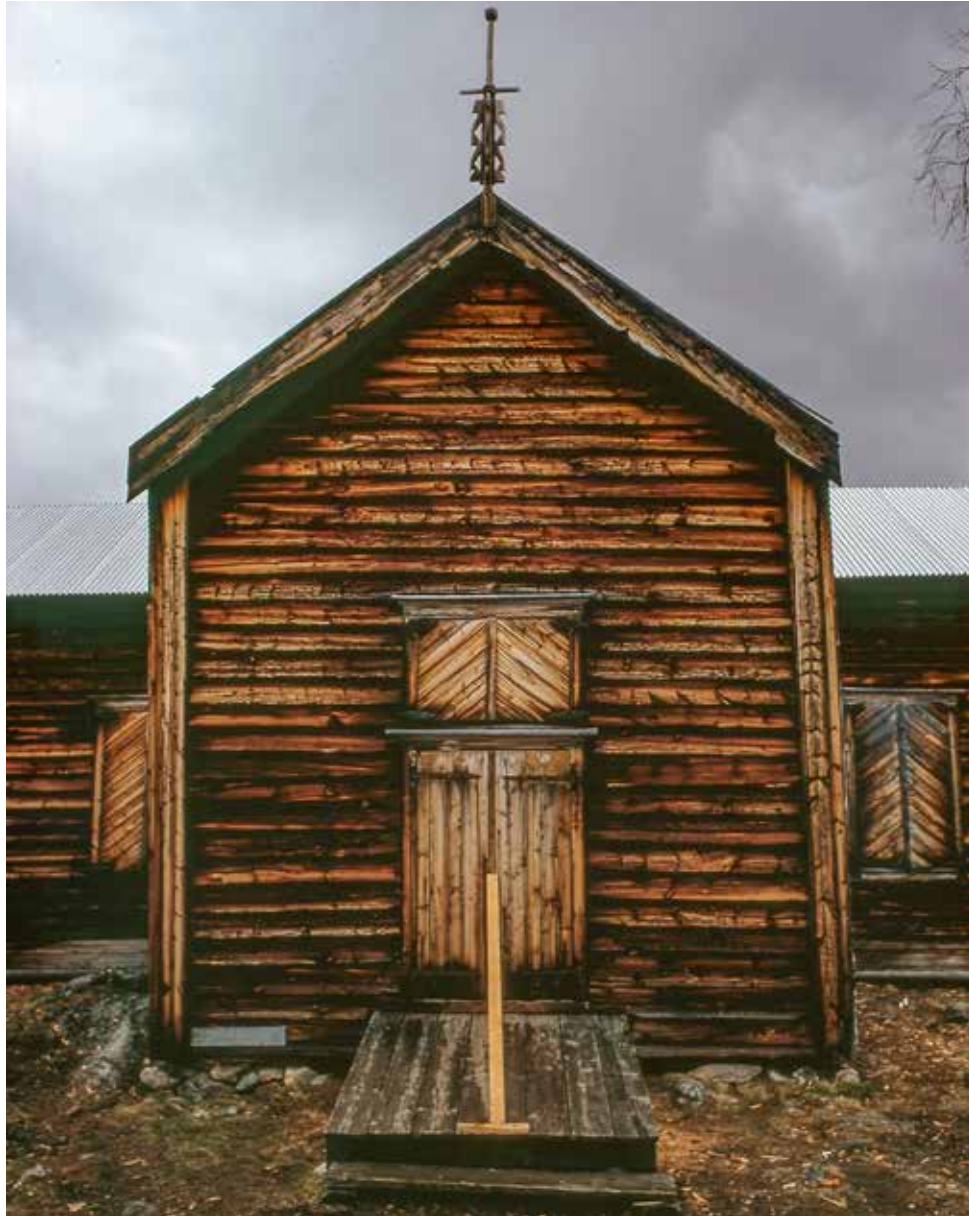
Kirkon korjausten aikaan vuonna 1974. Katolla näkyy alumiinipeltinen aluskate. Päädyn räystääslaudan päällä on korokerima. O. Kallionpää, MV.
