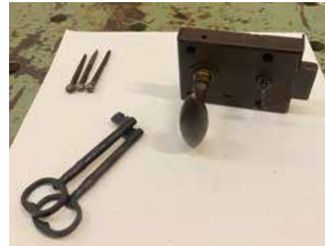
Eteläsakaran ulko-oven lukko ruuveineen huollon jälkeen. Lukkoon on tehty kaksi uutta avainta.
