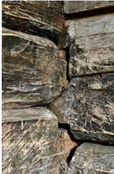
Lehterien etuseinät on salvottu osaksi kehikkoa, mutta niiden lattiarakenteet on asennettu valmiiseen kehikkoon. Tästä kertovat seinähirsiiin hakatut asennuslovet.
