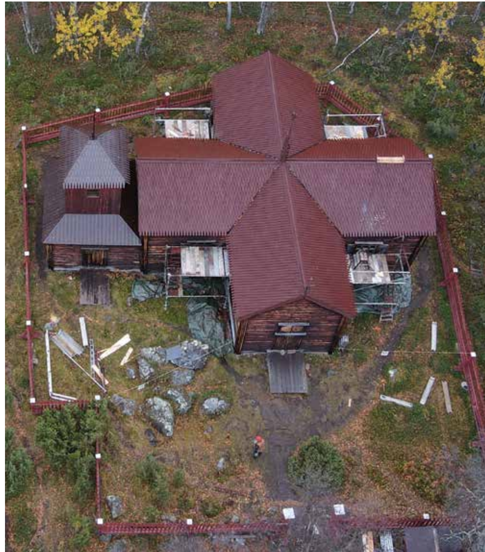
Tapulin vastikään korjatut ja tervattut katteet lokakuussa 2025. Ristivarsien katteista on tervattu ainoastaan uusitut paanut. Kuva Tuomo Rinne.
