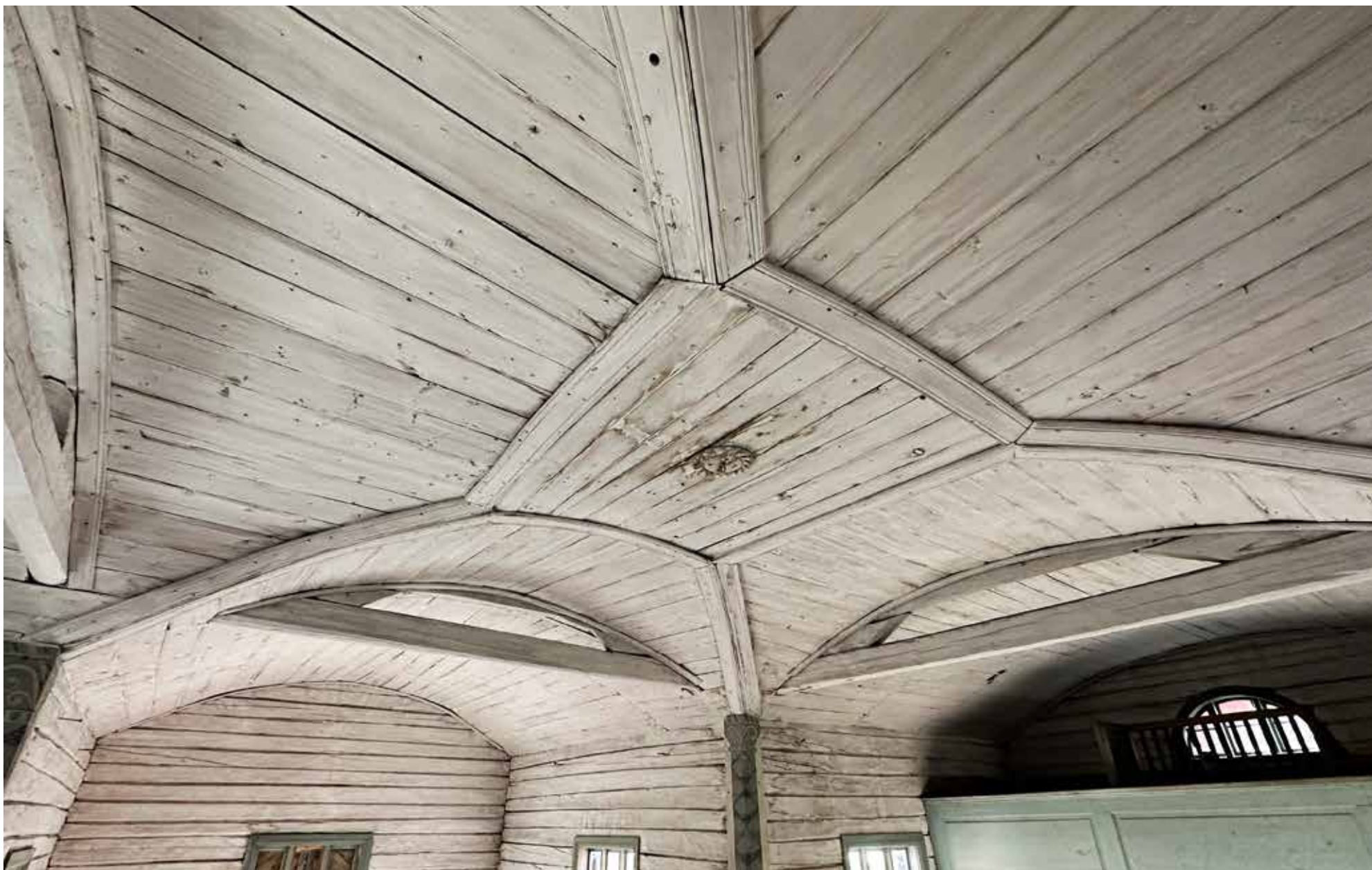
Kirkkosalin laipio vuonna 2021. Ristikeskuksen hirsikehän hirret työntyvät laipion läpi kirkkosaliin.
