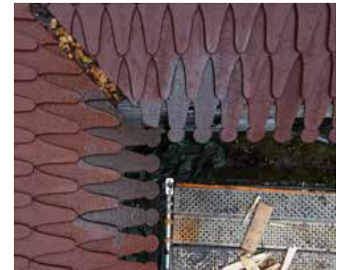
Itäisen ja pohjoisen riistivarren jirissä on uusittu vaurioituneita paanuja. Uudet paanut on käsitelty kimröökkiä sisältävällä tervamaalilla. Kuva Tuomo Rinne.
