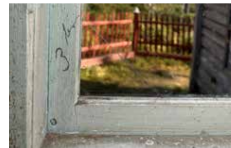
Kirkkosalin ikkunoissa on kauttaaltaan samantaiset numeroinnit kuin alttarin etupaneelissa.
