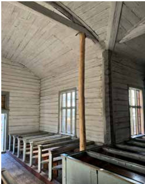
Hirren väliaikainen tuenta. Kuva Tuomo Rinne.
