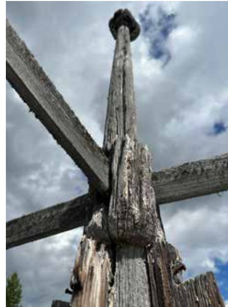
Ristikeskukseen päällä olevan spiiran haristunut huippu (vas.) ja korjattu tyvi (oik.) kesällä 2024.
