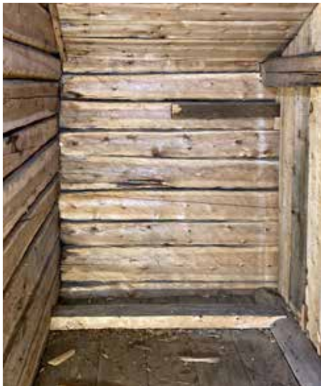
Alttariseinän lautarakenteen naulauspuu on sovitettu asennuskoloon ja lukittu paikalleen pätkällä sakastin vanhaa laipiopalkkia.
