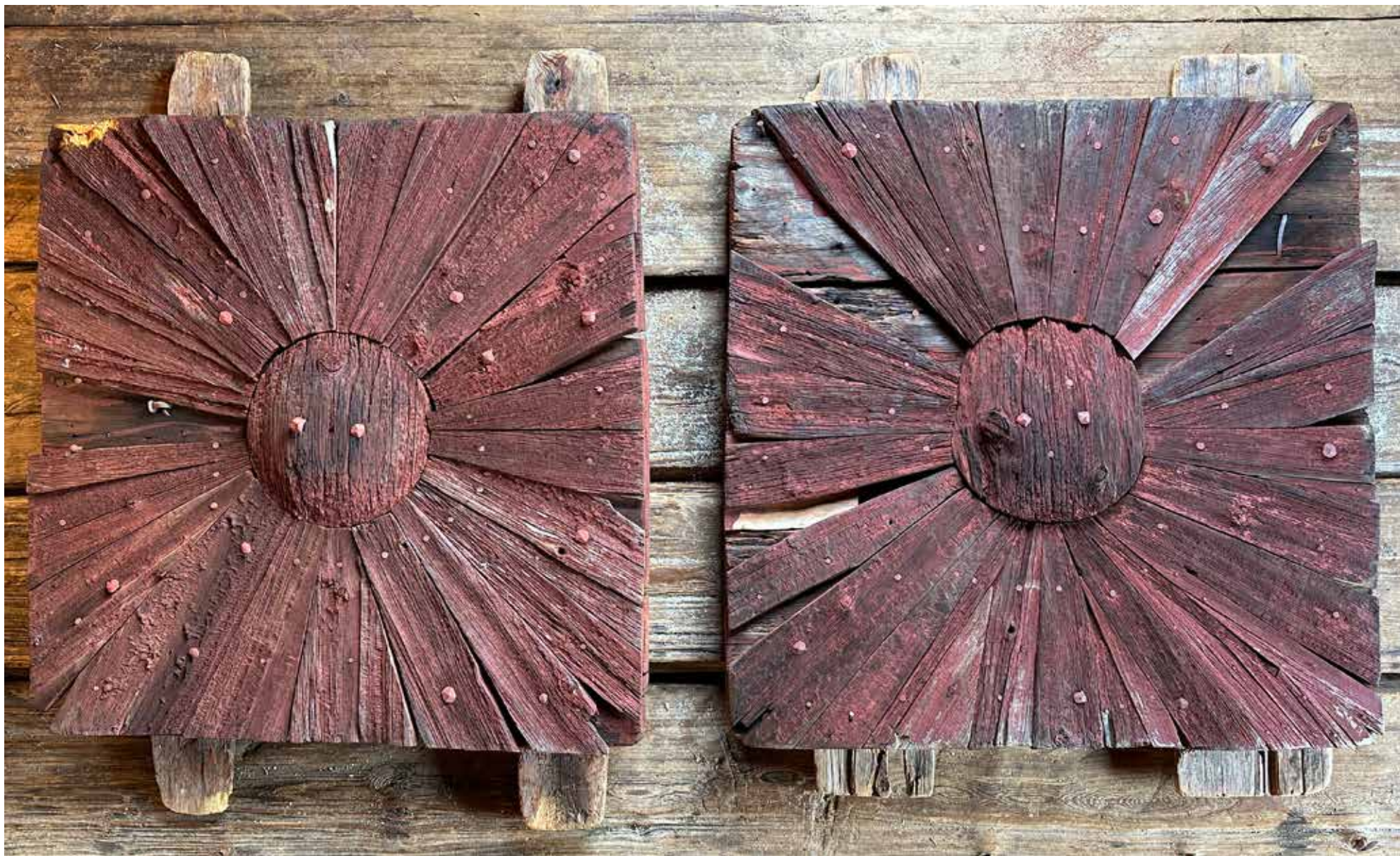
Luukut lienee korjattu viimeksi vuonna 1974. Luukkujen korjaamiseen käytettiin tapulin vanhoja seinälautoja.* (* Maija Kairamon matkakertomus 27.4.1974; Muistio korjaustöistä 1973_Raatikainen).
