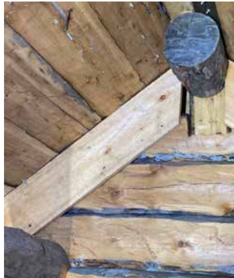
Vesikattoa on ristikeskuksessa nostettu parikymmentä senttiä: kurkihirret on pönkätty ja vasat kiilattu ylemmäs.
