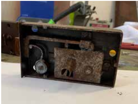
Sakastin eteläoven lukon sisäosat puhdistuksen ja rasvauksen jälkeen.
