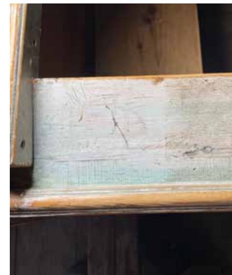
Eteläsakaran penkin kaiteen tussimerkintään kokeiltiin liuottimia, joista mikään ei liuottanut pohjalla olevaa öljymaalipintaa. Tehokkaimmaksi to-dettiin etyyliasettaatti. Merkintää poistettaessa alustasta irtosi myös pinttynyttä likaa, mikä sai poistokohdan erottumaan selvästi ympäristöstään. Vaikutelmaa hävytettiin puhdistamalla ympäröivä pinta rajatulta alueelta pellavaöljysuovalla ja vedellä.
