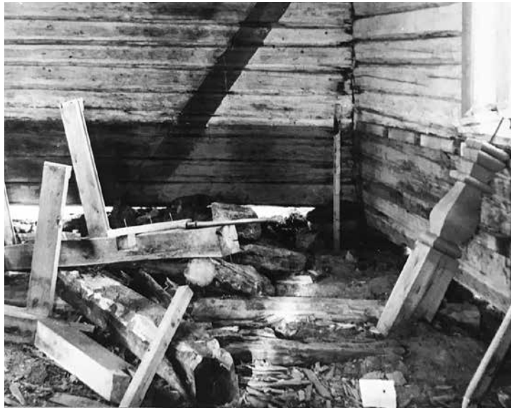
Lattiarakennetta pohjoissakarassa vuosien 1973–74 työmaan aikana. 14476, MV, digitoimaton.
