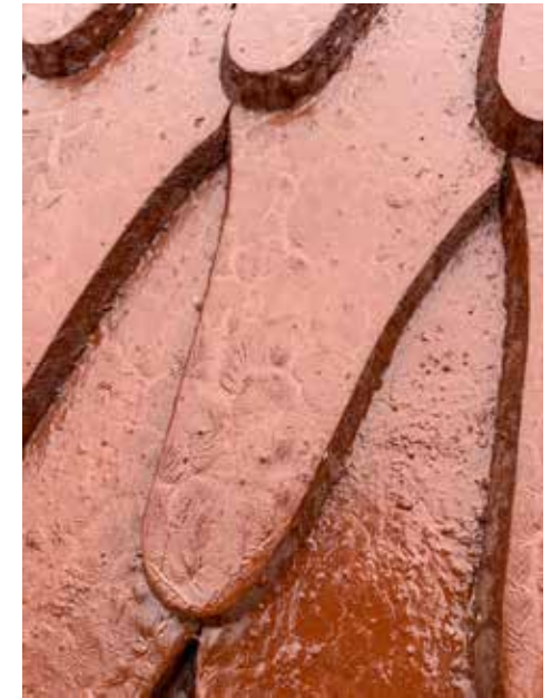
Lähikuva tapulin paanuista pian toisen tervauksen jälkeen. Kuva Tuomo Rinne.
