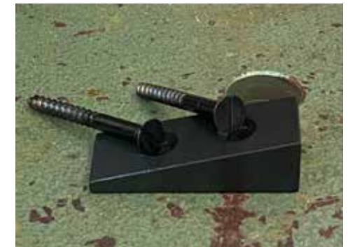
Kirkon eteläoven lukon passiivinen vastakappale.
