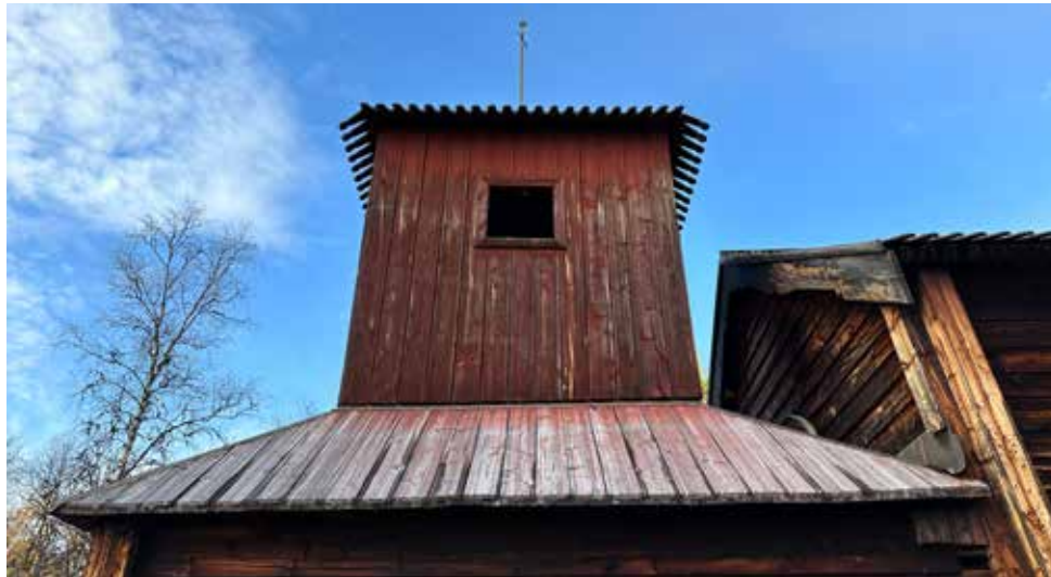
Tapulिन lautakatteen etelälape syksyllä 2023. Katon ja kirkon länsiseinän välissä on kuparipelti, joka johtaa sadeveden pois. Se vaikuttaa pysyneen täysin tiiviinä.
