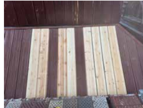
Yllä eteläisivun korjattu lautakate.
