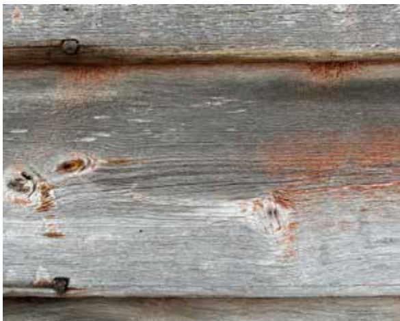
Pohjoispuolen laudoituksessa on jäämiä punamultamaalista. Naulaus on tehty helmellä koristellun pontin läpi.
