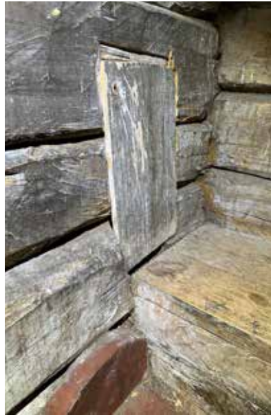
Lehterien etuseinät on salvottu osaksi kehikkoa, mutta niiden lattiarakenteet on asennettu valmiiseen kehikkoon. Tästä kertovat seinähirsiiin hakatut asennuslovet.
