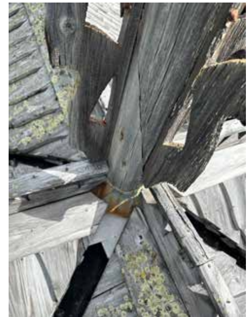
Ristikeskukseen päällä olevan spiiran haristunut huippu (vas.) ja korjattu tyvi (oik.) kesällä 2024.
