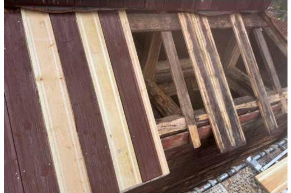
Lautakатteen korjaus käynnissä tapulin länsisivuilla.
