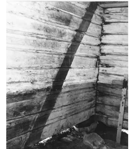
Kirkon koillisnurkka vuosien 1973–74 työmaan aikana. 14442, MV, digitoimaton.
