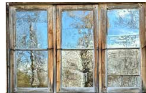
Kirkon ikkunoissa on paljon lasinsäästöjatkoksia. Osassa lasit ovat siirtyneet hiukan pois paikoiltaan. Kuvassa ikkunan 6 yläpuitteet.
