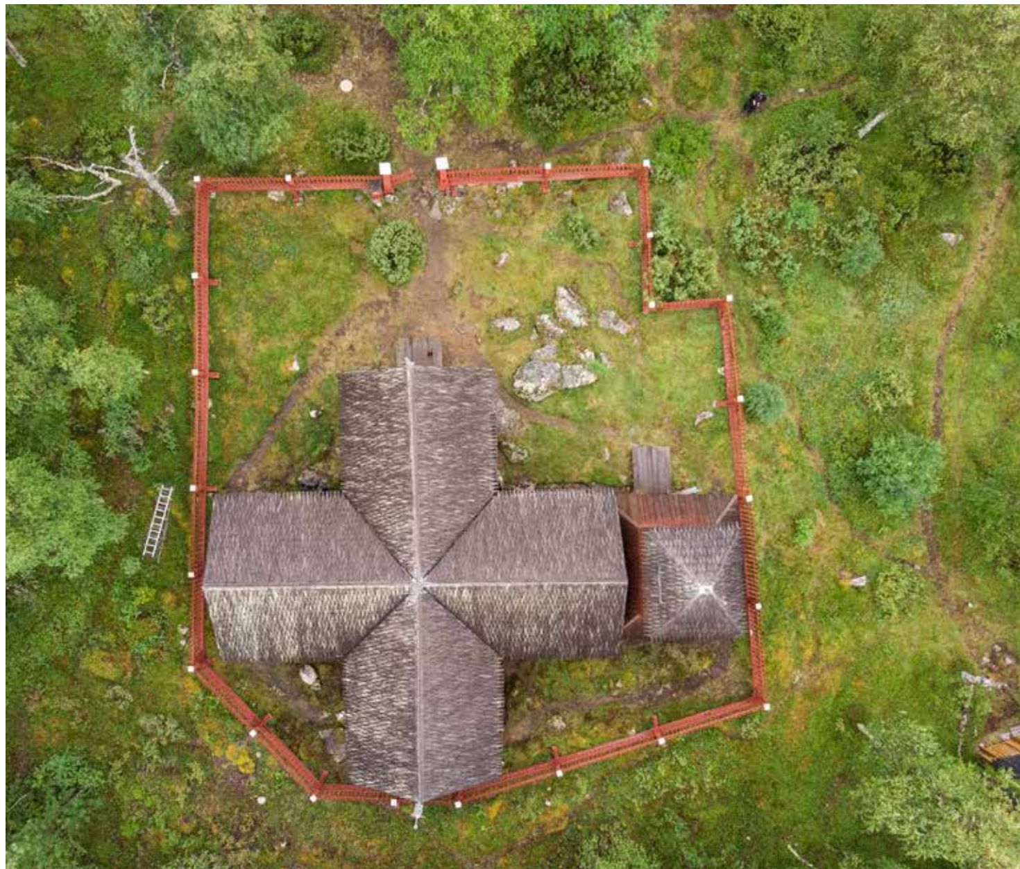
Kopterikuva kirkosta vuonna 2021. Aita on hyvässä maalissa, mutta katolla ei ole tervaa.
