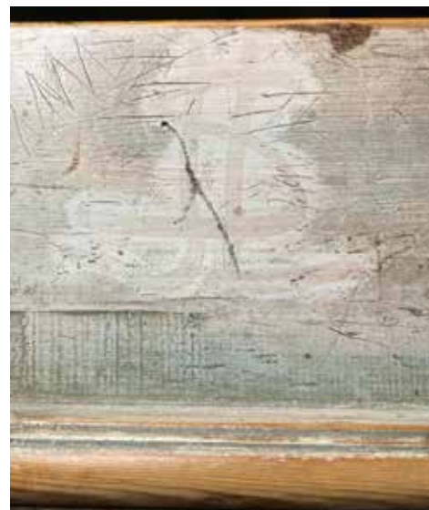
Eteläsakaran penkin kaiteen tussimerkintään kokeiltiin liuottimia, joista mikään ei liuottanut pohjalla olevaa öljymaalipintaa. Tehokkaimmaksi to-dettiin etyyliasettaatti. Merkintää poistettaessa alustasta irtosi myös pinttynyttä likaa, mikä sai poistokohdan erottumaan selvästi ympäristöstään. Vaikutelmaa hävytettiin puhdistamalla ympäröivä pinta rajatulta alueelta pellavaöljysuovalla ja vedellä.
