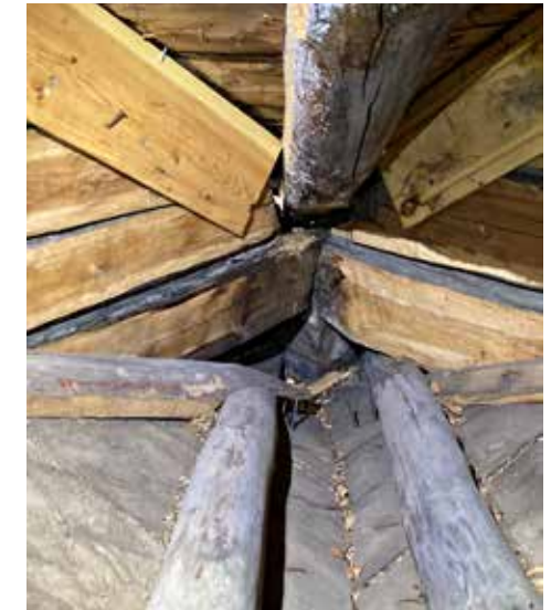
Ristikeskuksen laipiolaudoituksen naulauspuita vintiltä kuvattuna. Kuvan keskellä näkyy kehikon sisänurkan hakasalvain, jonka päälle ristikeskuksen hirsikehä tukeutuu. Hirsikehän päältä nousevat sakaroiden päätykolmiot ja ristikeskuksen jiiripalkit.
