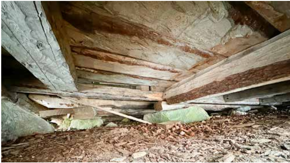
Lattiarakennetta itäpäädyn ali kuvattuna. Etualalla näkyvät sakastin lattiapalkit on kuvan ulkopuolella tuettu itäpäädyn pelkkakertaan klossilla.
