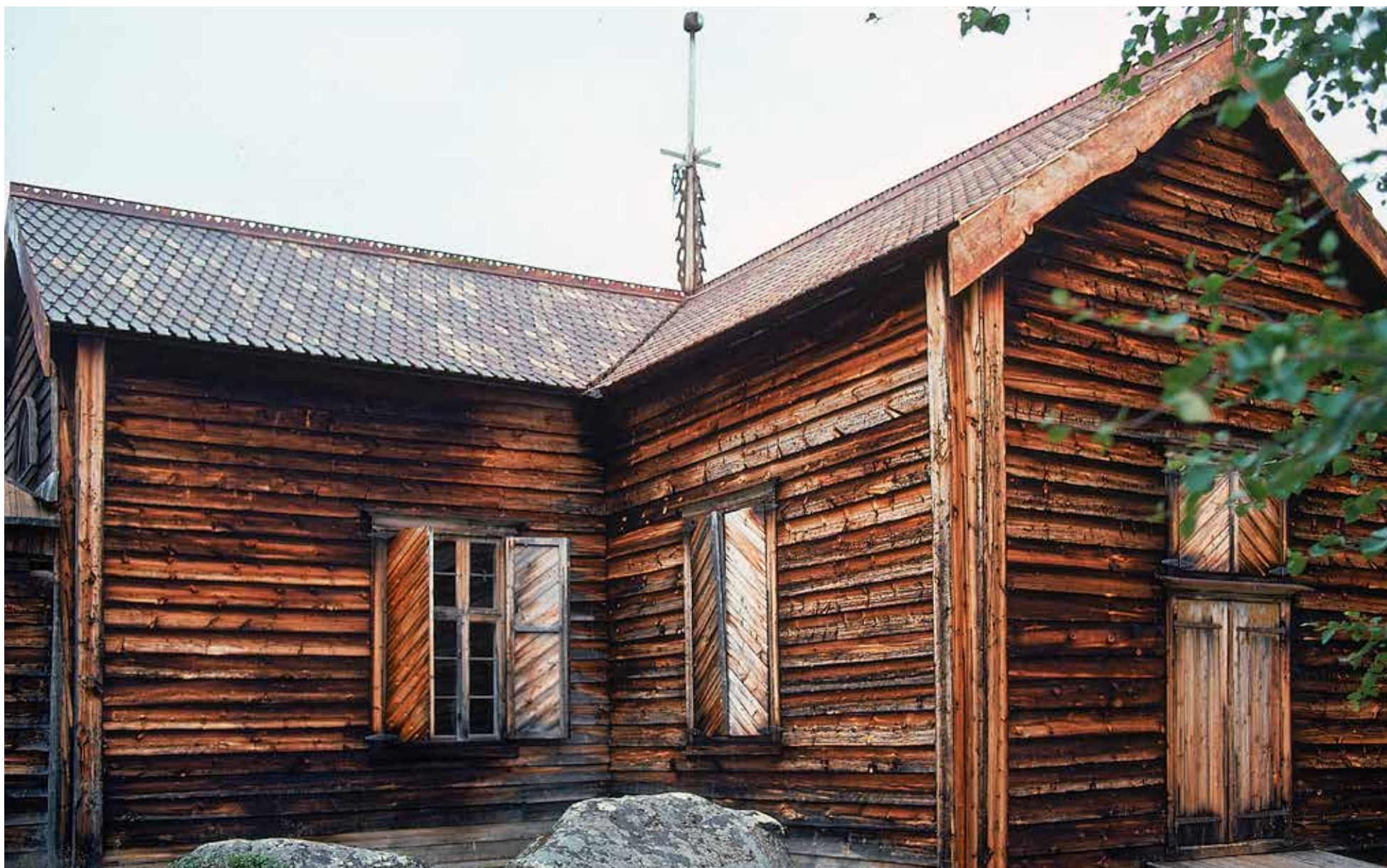
Paanukate valmiina, vain räystäslaudan korokerimat puuttuvat. O. Kallionpää, 1974, Rakennushistorian kuvakokoelmat, Museovirasto.
