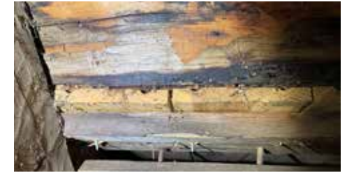
Katelautojen yläpäät näkyvät ullakolla.
