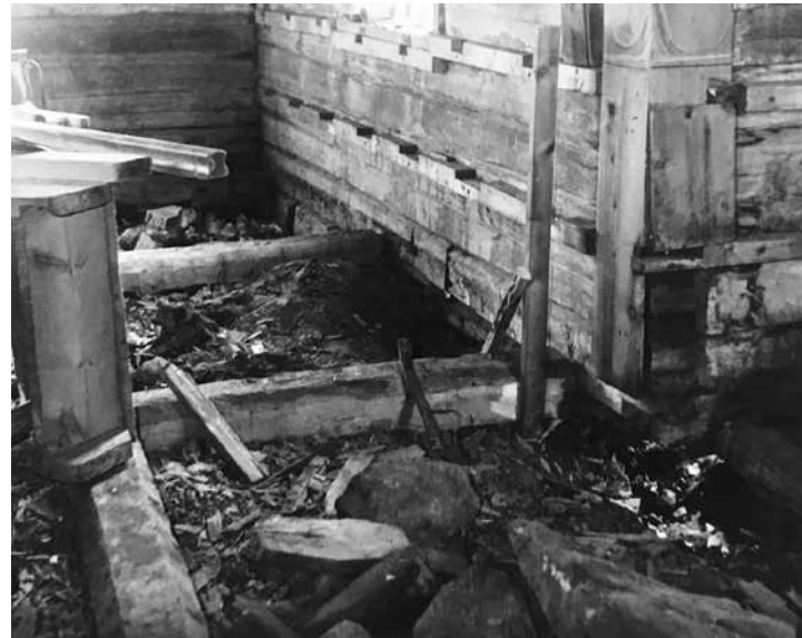
Lattiarakennetta eteläsakarassa vuosien 1973–74 työmaan aikana. 14475, MV, digitoimaton.
