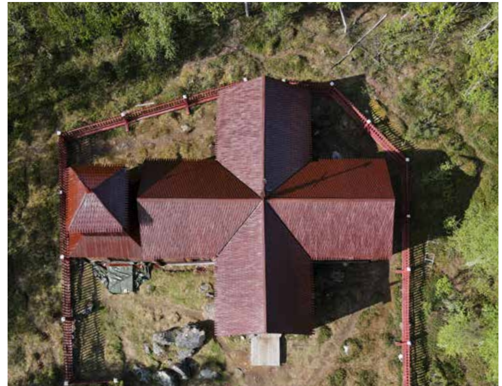
Kokonaan tervattu katto 13.6.2025. Kuva Tuomo Rinne.
