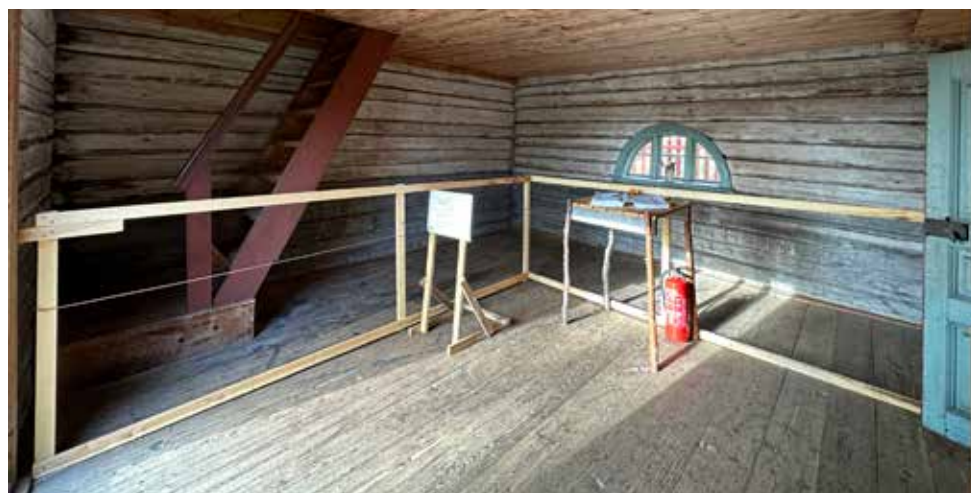
Tuhannet vuosittaiset vierailijat myös kuluttavat kirkkoa: esimerkiksi talvikenkien nastat rikkovat puulattian pinnan. Tämä näkyy erityisesti kirkon eteläsakarassa.
