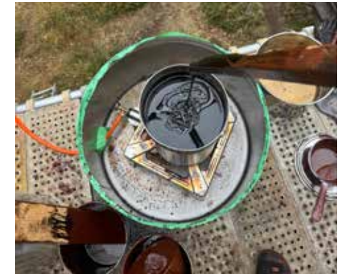
Tervamaali lämmitettiin telineillä levityslämpötilaan pienissä erissä. Kuva Tuomo Rinne.
