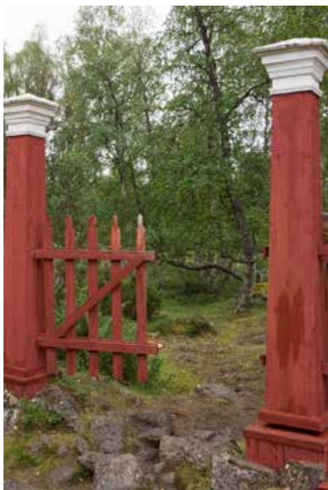
Portinpylväistä puuttuvat sipulikoristeet. 2021.
