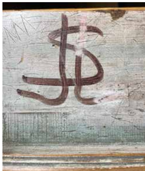
Eteläsakaran penkin kaiteen tussimerkintään kokeiltiin liuottimia, joista mikään ei liuottanut pohjalla olevaa öljymaalipintaa. Tehokkaimmaksi to-dettiin etyyliasettaatti. Merkintää poistettaessa alustasta irtosi myös pinttynyttä likaa, mikä sai poistokohdan erottumaan selvästi ympäristöstään. Vaikutelmaa hävytettiin puhdistamalla ympäröivä pinta rajatulta alueelta pellavaöljysuovalla ja vedellä.
