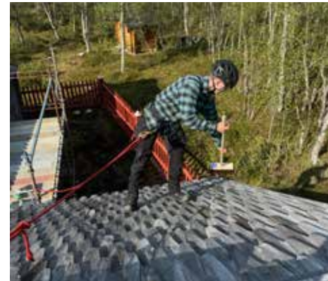
Ennen pintakäsittelyä katot puhdistettiin harjaamalla. Kuva Tuomo Rinne.
