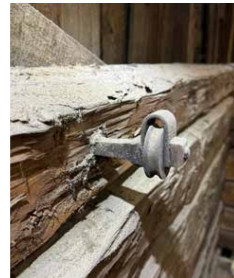
Hirsiseinään kiinni lyöty rissapyörä, jonka käyttötarkoitus ei ole selvä. Kirkonkellojen soittamiseen sitä ei ole käytetty, sillä Vanhan kirkon kellotorniin ei alun perinkään harkittu kellojen asentamista (Sinisalo 1965, 6). Pyörää on mahdollisesti voitu käyttää esimerkiksi ilmanvaihtoluukkujen säätämiseen.
