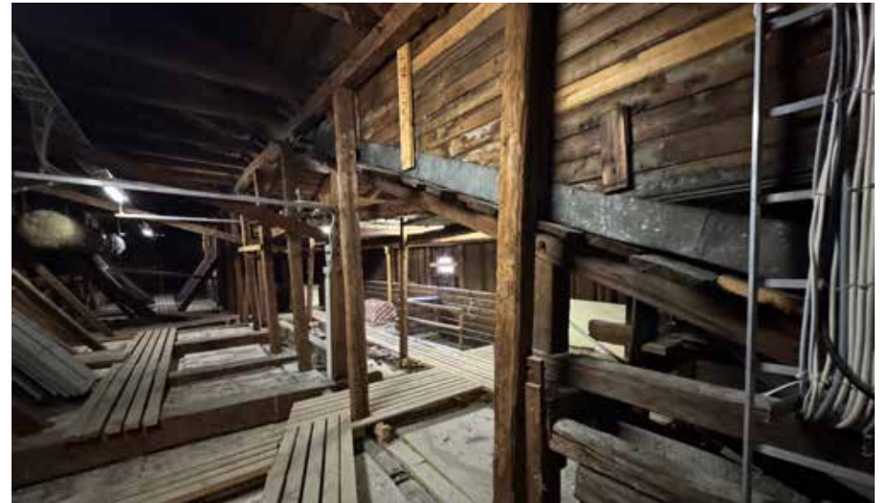
Pohjoisen puolen eteisosan katto kuvan oikeassa laidassa. Myös tätä kautta on luukku ullakkotiilaan.
