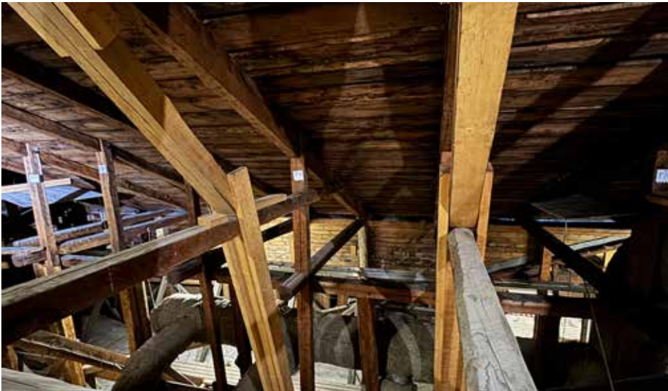
Uusitut ja korjatut kattorakenteen osat erottuvat vanhoja vaaleampina. Myös materiaali, liitokset ja käytetyt työtavat poikkeavat alkuperäisistä osista (P15 ja P16).
