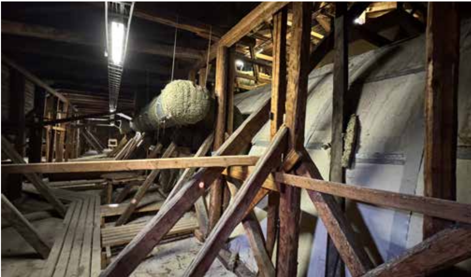
Holvin pohjoispuolista ullakkoa kuvattuna itään päin. Eristyslevyillä päällystetty holvi näkyy kuvan oikeassa laidassa.
