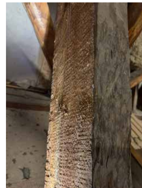
Vasemmalla näkyy sahattua pintaa ja oikealla veistettyä työstöjälkeä Vanhan kirkon kattorakenteissa.
