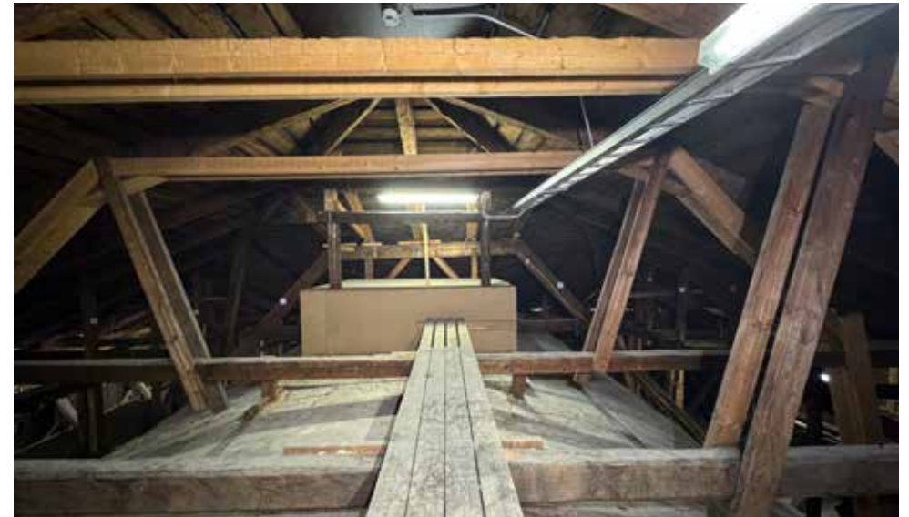
Holvin päällä on kitapuiden varaan asennettuja kulkusiltoja.
