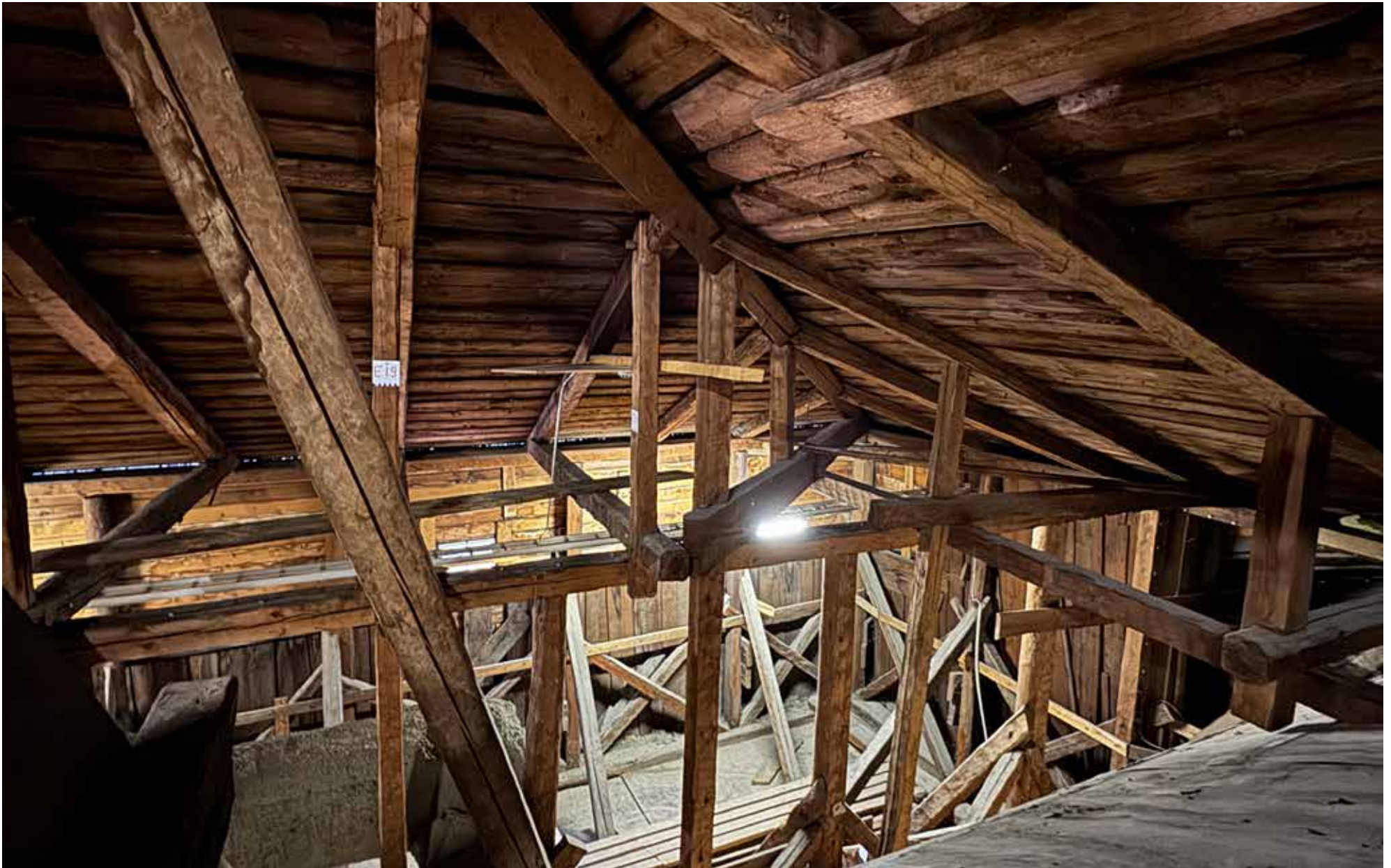
Lounaiskulma kuvattuna holvin päältä kattotuolin 19 kohdalta. Keskellä ylhäällä auman jiiri.
