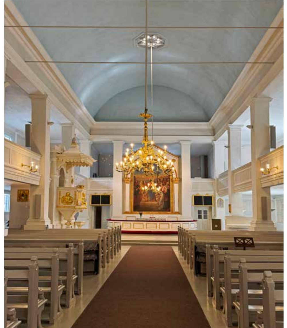
Kirkkosalissa on koko pituudelta lännestä itään ulottuva kaariholvi. Teräksiset vetotangot on asennettu jo vuonna 1886 estämään ulkoseinien pullistumista ulospäin. Tornin paino ja pitkäkirkon kattotuolien vaakakuormat olivat oletettavasti aiheuttanut ongelmia seinärakenteen kestävyydelle. Keskilaivan molemmiin puoliin on lehterit ja tiilliset pylväsritvit, joihin kattorakenteet osin tukeutuvat.
