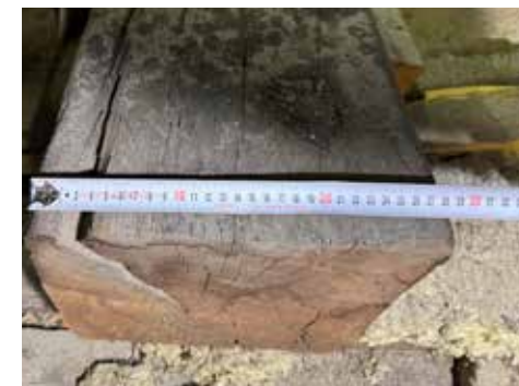
Vanhan kirkon suurten vaakaparrujen mitat ovat n. 28 x 28 cm, eli 11 x 11 tuumaa. Ulkopinta on veistetty.
