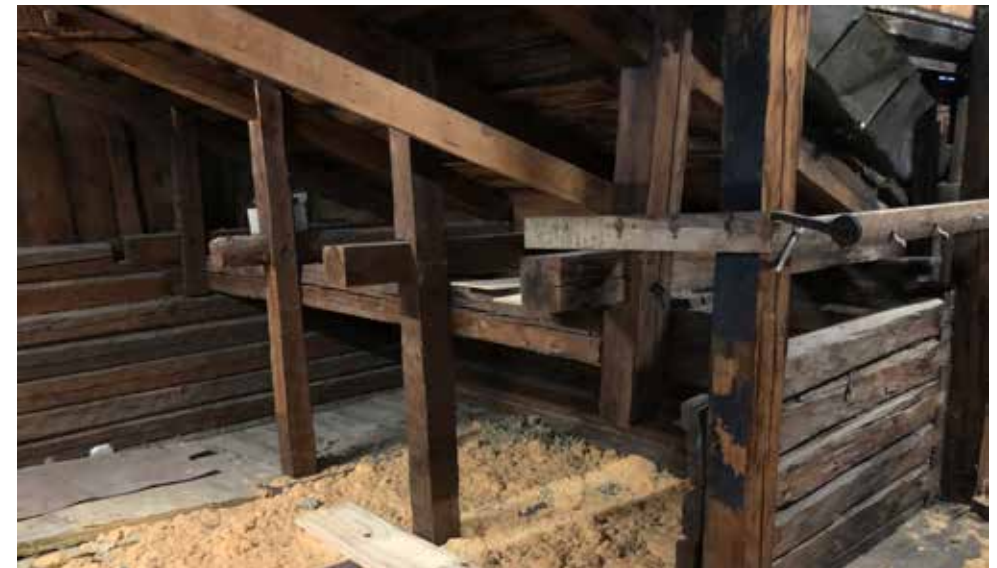
Etelän puoleisen eteisosan konttikattotuoleja.
