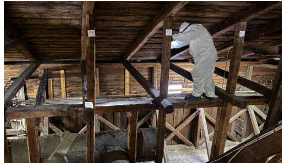
Kattotuolien koodausta merkkilapuilla ullakon pohjoispuolella.
