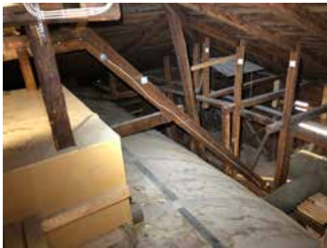
Tornia kannattava vinopalkki kuvattuna holvin päältä pohjoisen puolelta (P18–19).
