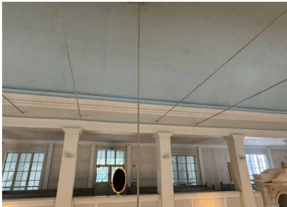
Kirkkosalin holvin yläosassa on näkyvissä vetotankoja, joiden tarkoituksena on estää hirsiseinien pullistuminen ulospäin. Ensimmäiset vetotangot on asennettu vuonna 1886 (Sinisalo 1965, 6).
