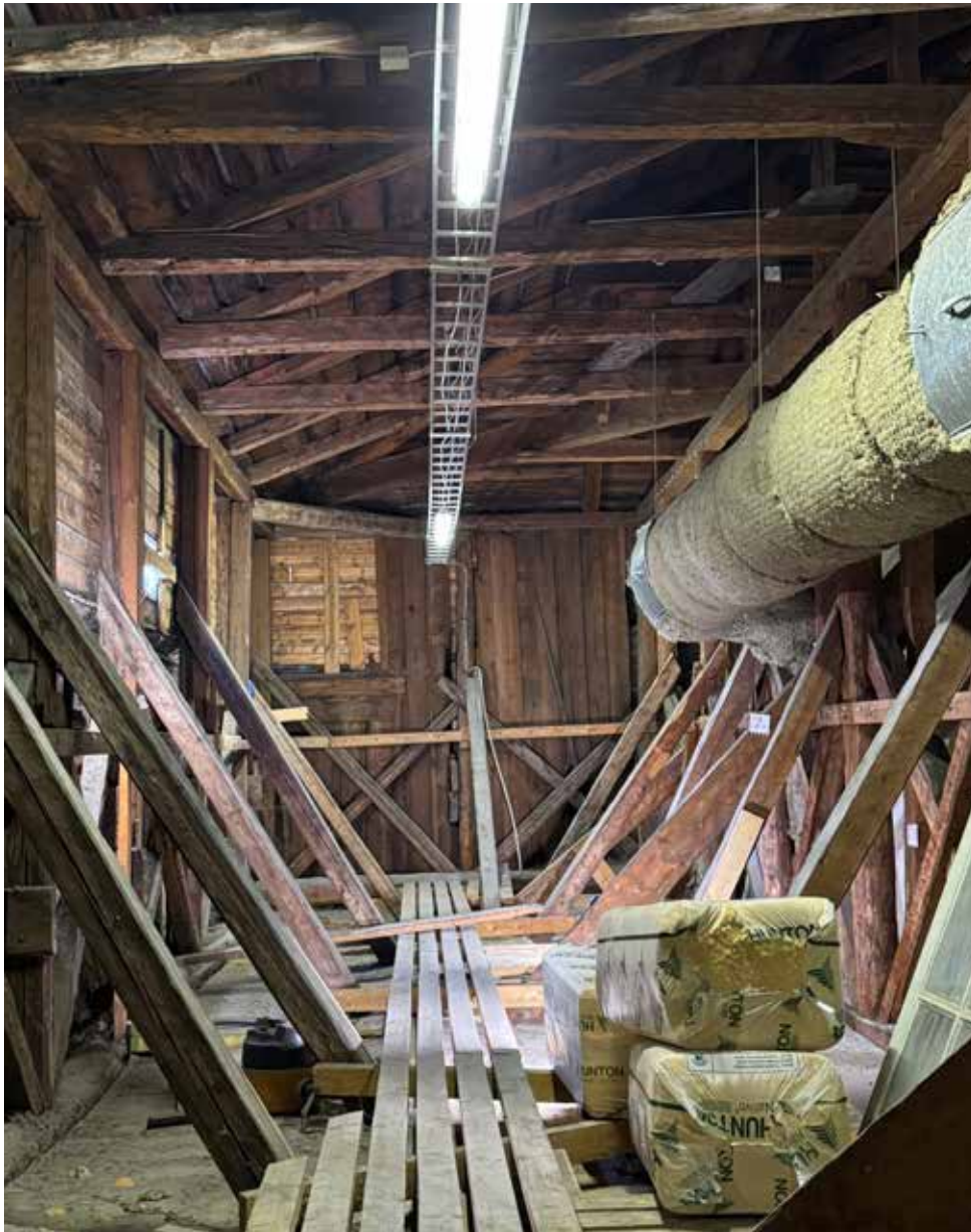
Ullakon eteläpuoli kuvattuna länteen päin. Kattotuolit ovat valaisimien ja ilmanvaihtoputkien yläpuolella. Vasemmalla olevat vinopalkit tukevat attikaseiniä. Holvi jää vasemmalle puolelle.
