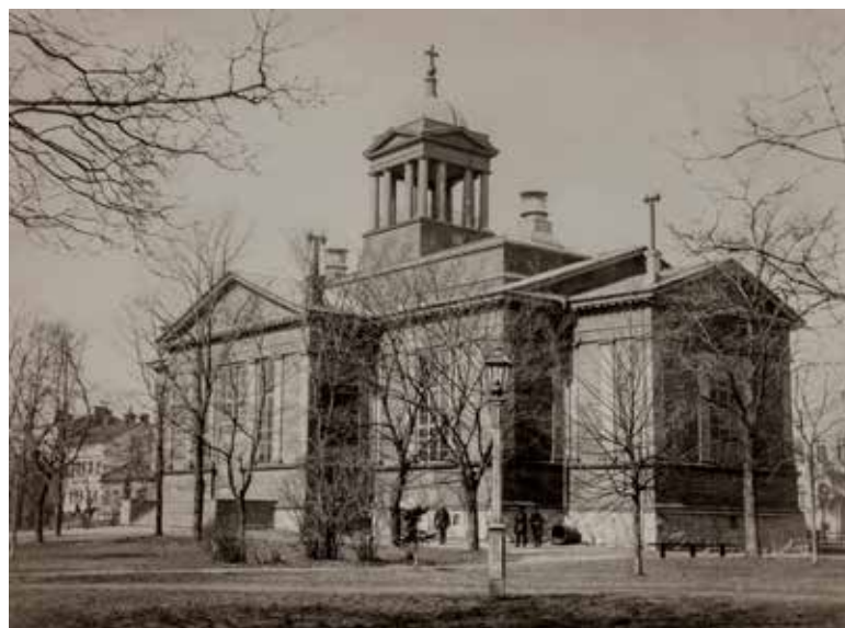
Vanha kirkko vuonna 1900. Katon harjalla näkyvät ”Wolpertin imuhattut”. Itä- ja eteläsakaroissa olevat piiput liittynevät kaloriferilämmitykseen. Kuva HKM / Karl Emil Ståhlberg.
