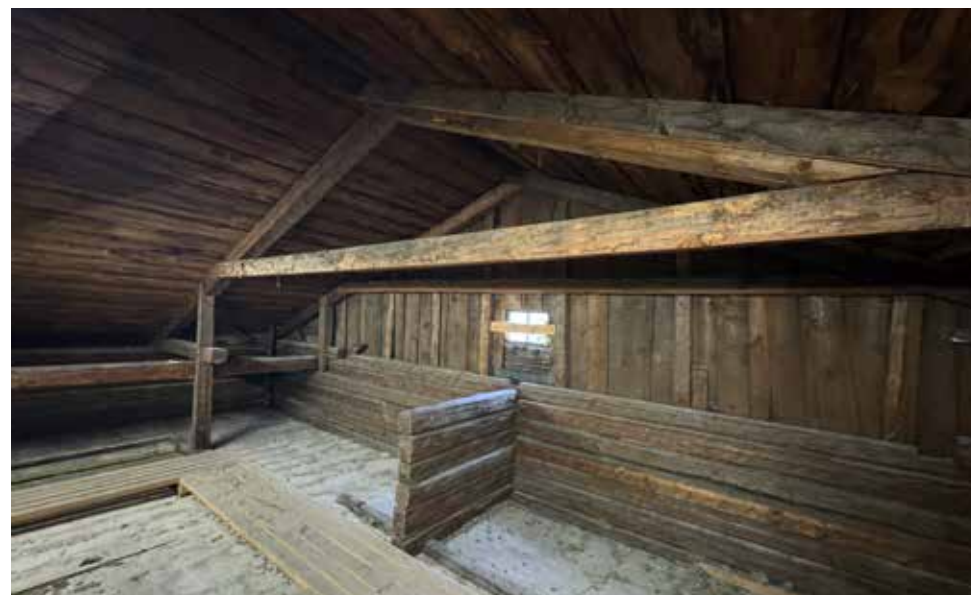
Kuorin konttikattotuolit muodostavat yksinkertaisen kokonaisuuden.
