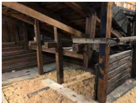
Puukuituvillaa etelänpuolisen eteisen lattiassa.
