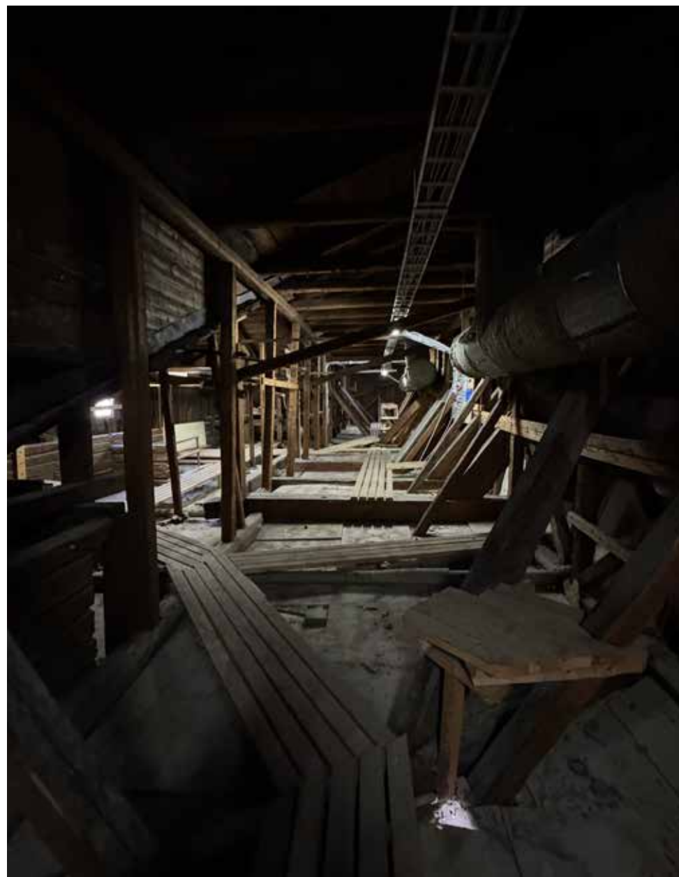
Eristelevyjä ja kulkusiltoja ullakon pohjoisosassa.
