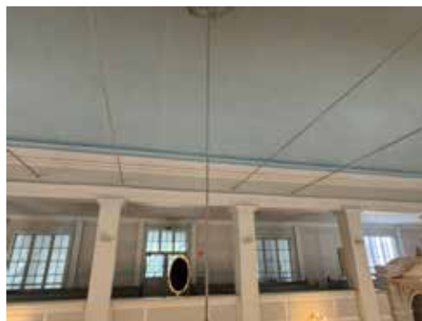
Lähteiden mukaan 1800-luvulla asennettiin kaksi vetotankoa. Nykyään niitä on neljä.
