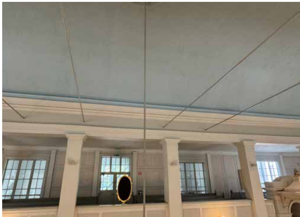
Kirkkosalin holvin yläosassa on näkyvissä vetotankoja, joiden tarkoituksena on estää hirsiseinien pullistuminen ulospäin. Ensimmäiset vetotangot on asennettu vuonna 1886 (Sinisalo 1965, 6).
