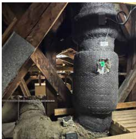
Holvin päällä on kaksi suurta poistoilmapuhallinta, jotka vastaavat kirkkosalin ilmanvaihdosta.
