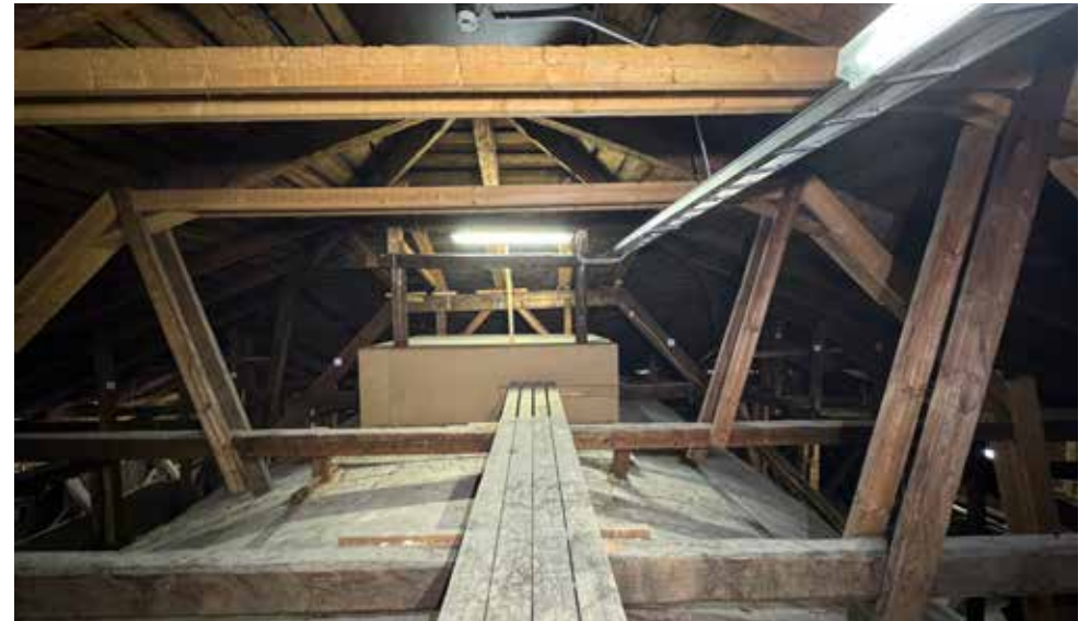
Holvin päällä on kitapuiden varaan asennettuja kulkusiltoja.
