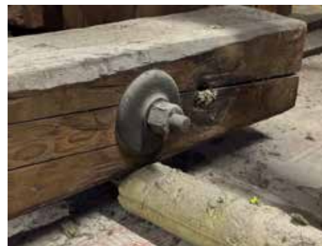
Ullakkotilassa on näkyvissä kaksi päällekkäistä vetotankoa. Alempi (kuvassa eristetty) tukee oletettavasti eteistilan seinää ja ylempi holvia. Ylemmän tangon suuri pultti ja aluslevy on jätetty näkyviin.
