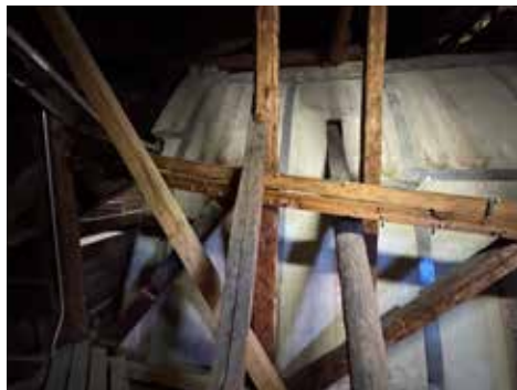
Holvin eristelevyjen saumoja on vahvistettu peltisuikaleilla.
