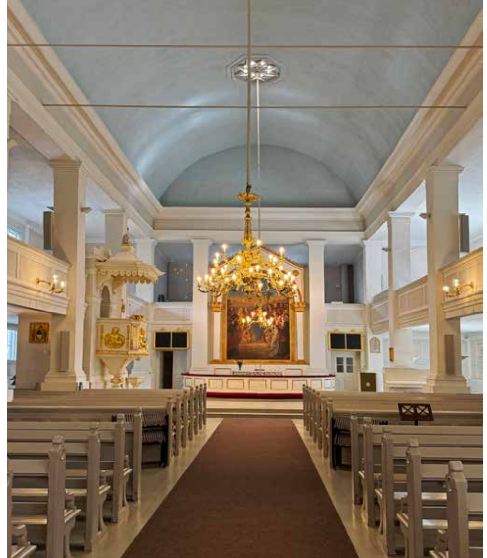
Kirkkosalissa on koko pituudelta lännestä itään ulottuva kaariholvi. Teräksiset vetotangot on asennettu jo vuonna 1886 estämään ulkoseinien pullistumista ulospäin. Tornin paino ja pitkäkirkon kattotuolien vaakakuormat olivat oletettavasti aiheuttanut ongelmia seinärakenteen kestävyydelle. Keskilaivan molemmiin puoliin on lehterit ja tiilliset pylväsrivit, joihin kattorakenteet osin tukeutuvat.
