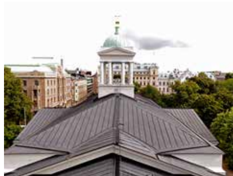
Loivakulmainen vesikatto on aumattu. Eteis- ja sakaristo-osien katot muodostavat poikkipäädyn kaikille julkisivuille. Pääsalin katon keskellä on kellotorni.
