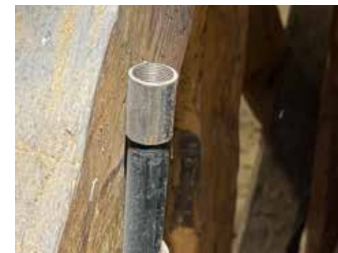
Ullakkotilasta löytyy muutamia teräsputkia, joita on mahdollisesti käytetty sähköasennuksiin.
