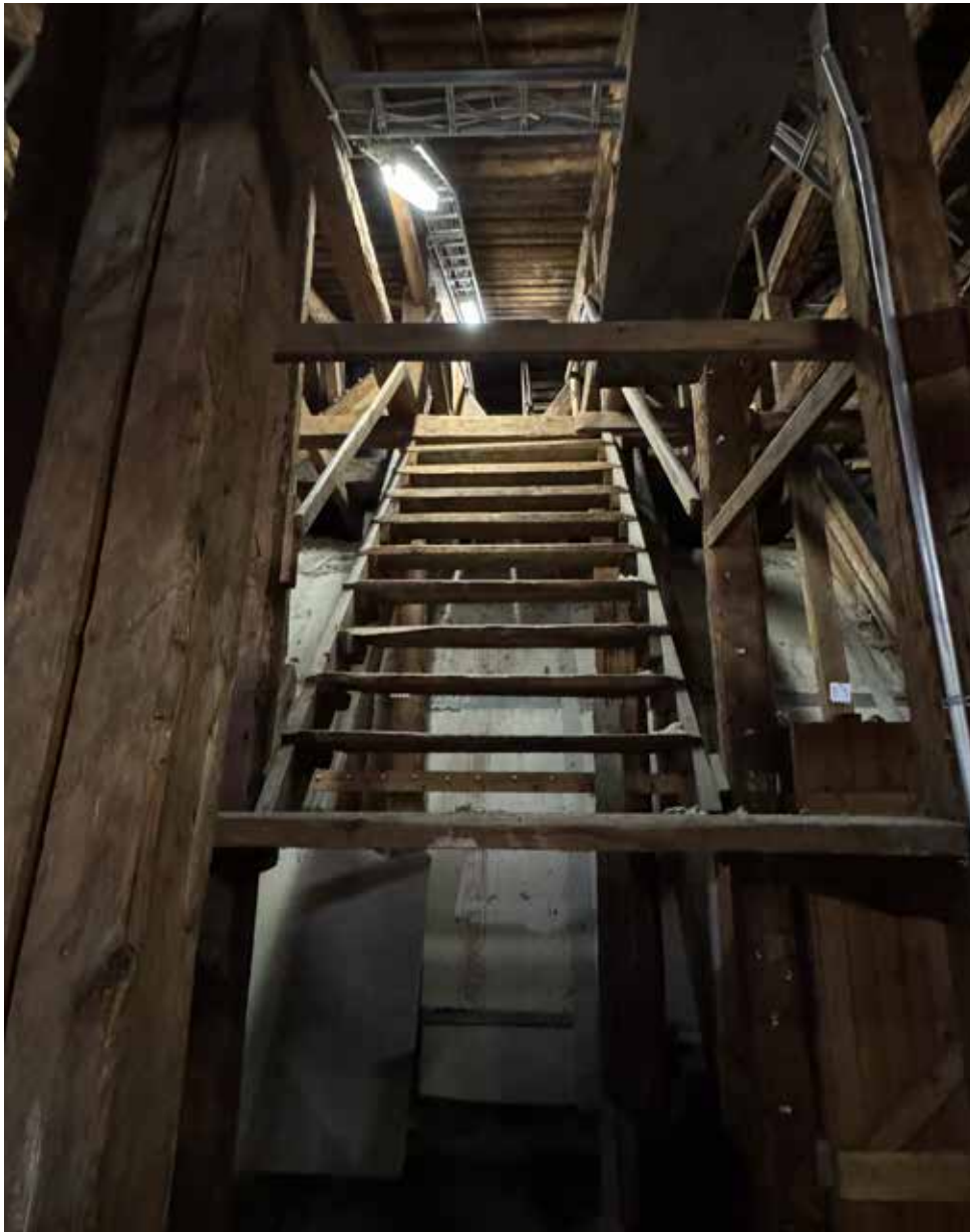
Holvin päälle ja torniin vievät portaat nousevat holvin päälle ullakon eteläpuolelta.
