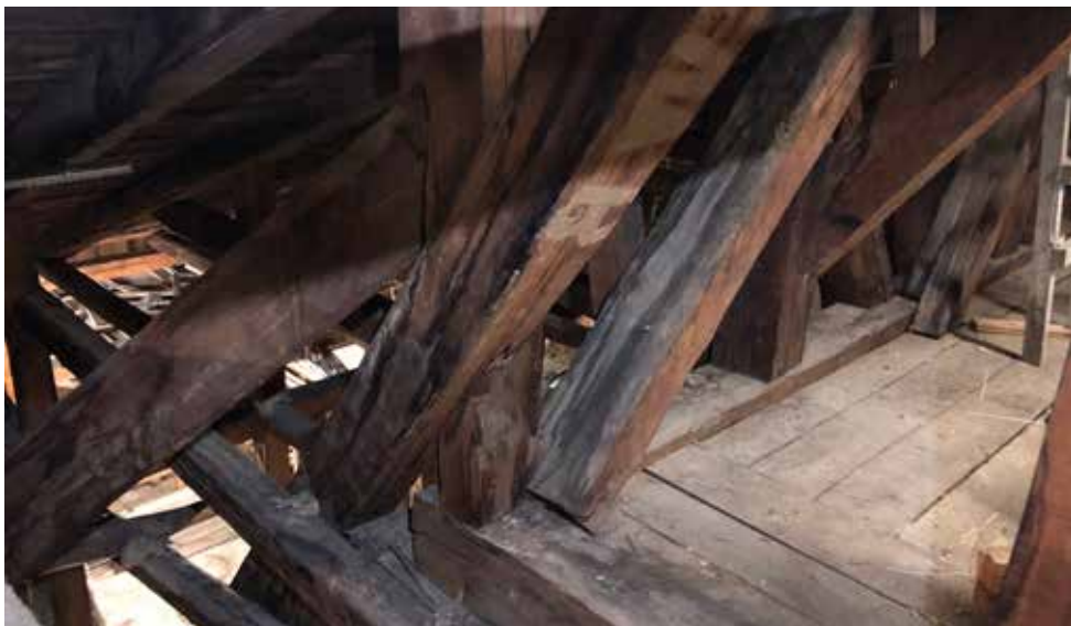
Tornin kehysrakenne ja tasanne holvin päällä. Vasemmalla rakenteeseen kytkeytyvät vinotuet, jotka kantavat tornin painoa.
