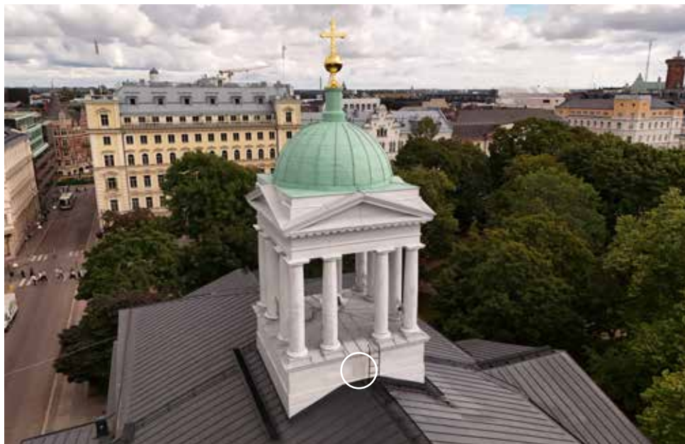
Poistoilmaritilät ovat tornin länsi- ja itälaitojen juuressa. Länsipuolen ritilä on korostettu kuvassa valkoisella ympyrällä.
