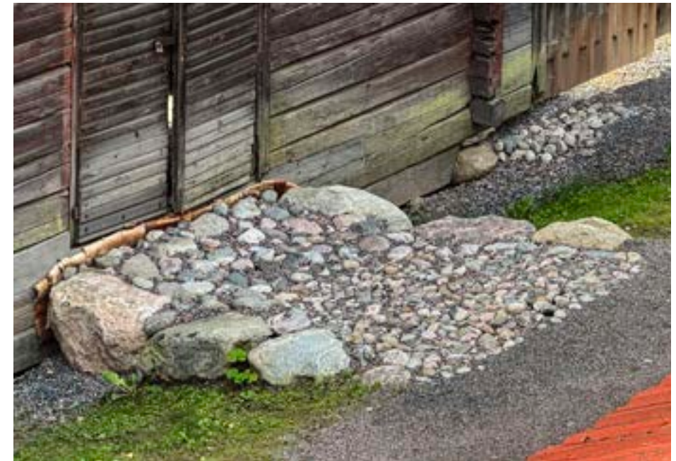
Tallin kiviaineinen ramppi vuonna 2025. Kyrnyshirteen vesilista, joka estäisi sadevettä valumasta tuohien taakse hirsiseinän alaosaan, on vielä tekemättä.
