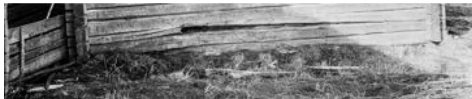
Säkylässä härkänavetan hirsikehikko nousi suoraan maasta, jolloin härjillä oli navetassa lämmintä ja vedotonta. MV, KK18S:228
