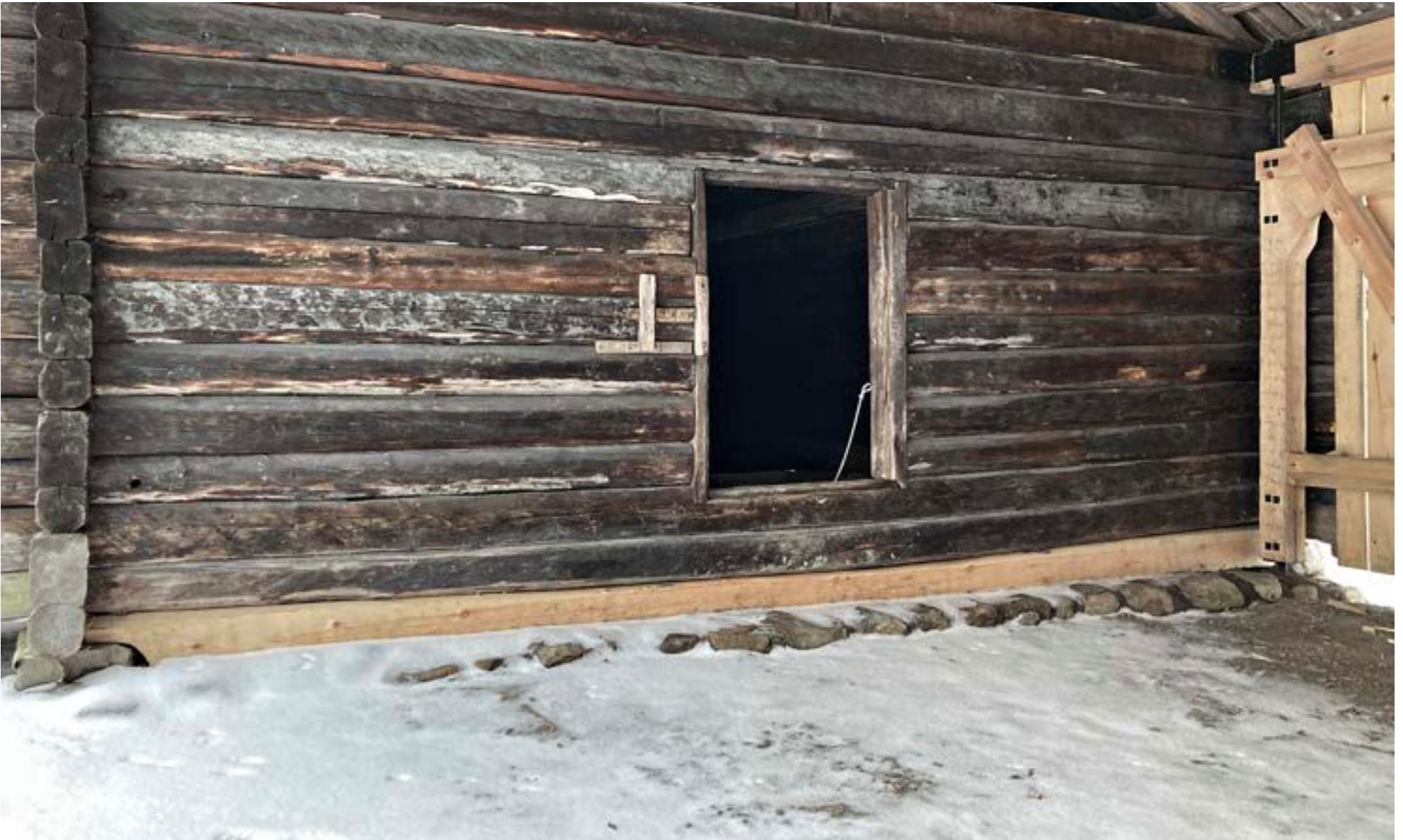
Lehmänavetan ulkoinen multapenkki valmiina syksyllä 2022. Kun maanpinta on tasaisempi kuin alkuperäisellä paikalla ja hirsikehikko on kengitetty, multapenkin kiviä ei ole tarvinnut latoa hirsikehikkoa vaan ainoastaan maahirttä vasten. Katoskin vähentää hirsikehikkoon kohdistuvaa kosteusrasitusta.
