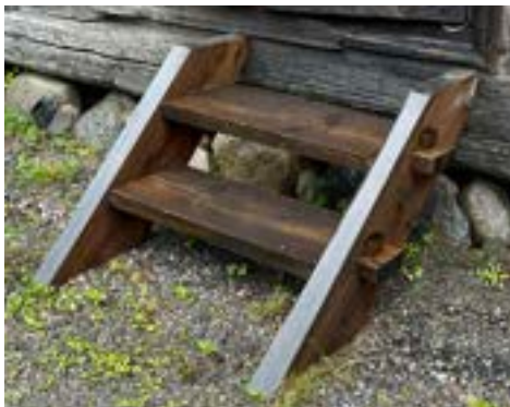
Talliladon uusittu porras vuonna 2025.
