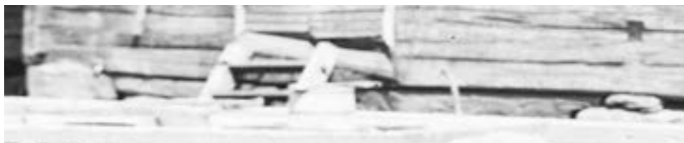
Säkylässä Tallin hirsikehikon alla näkyy perustuskiviin sovitettu maahirsi. MV, KK18S:4.
