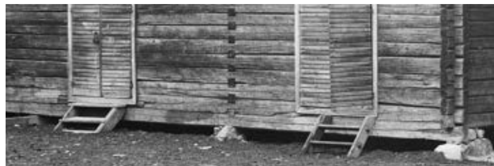
Tallin ja talliladon pihan puoleiset portaatsäurasaareen siirron jälkeen. Kuva: MV, KK18S:16.
