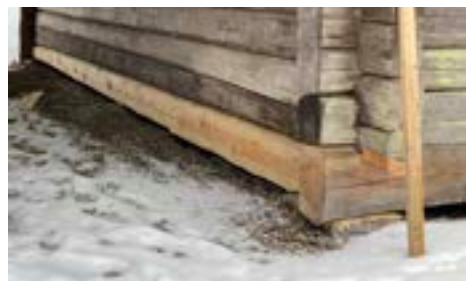
Yllä läävän ja ylimmäisenä prännin koillissivun maahirsi vuonna 2022.
