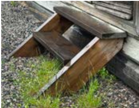
Tallin uusittu porras vuonna 2025.
