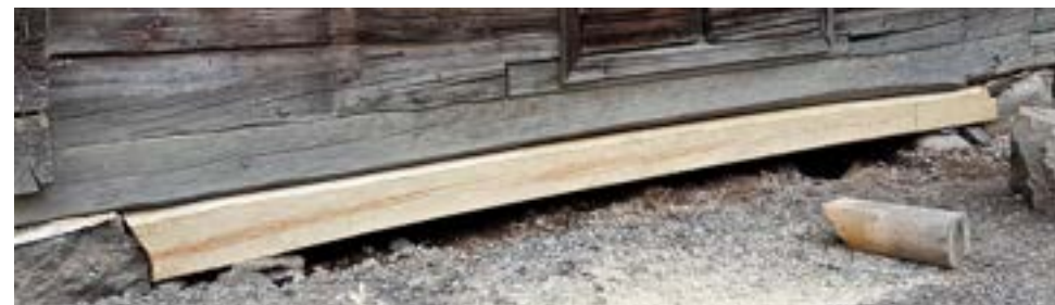
Yllä tallin kaakkoissivu ennen maahirren asennusta ja sen jälkeen. Entisöinti Rinteen taitavaa ja huolellista kengitystyötä on seurannut taitava ja huolellinen maahirren asennus. Lintukorpi, 2022.
