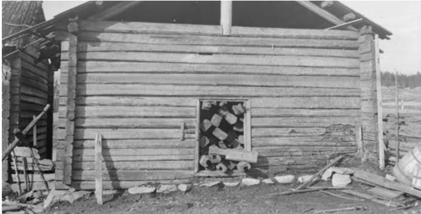
Säkylässä Lehmänavetta oli varustettu ulkopuolisella multapenkillä, jossa kiviä oli ladottu turpeiden päälle vanhan maahirren eteen. Kehikko on valokuvassa painunut siten, että multapenkki on alimpia hirsii vasten ja pitää niitä märkänä. MV, KK18S:3.
