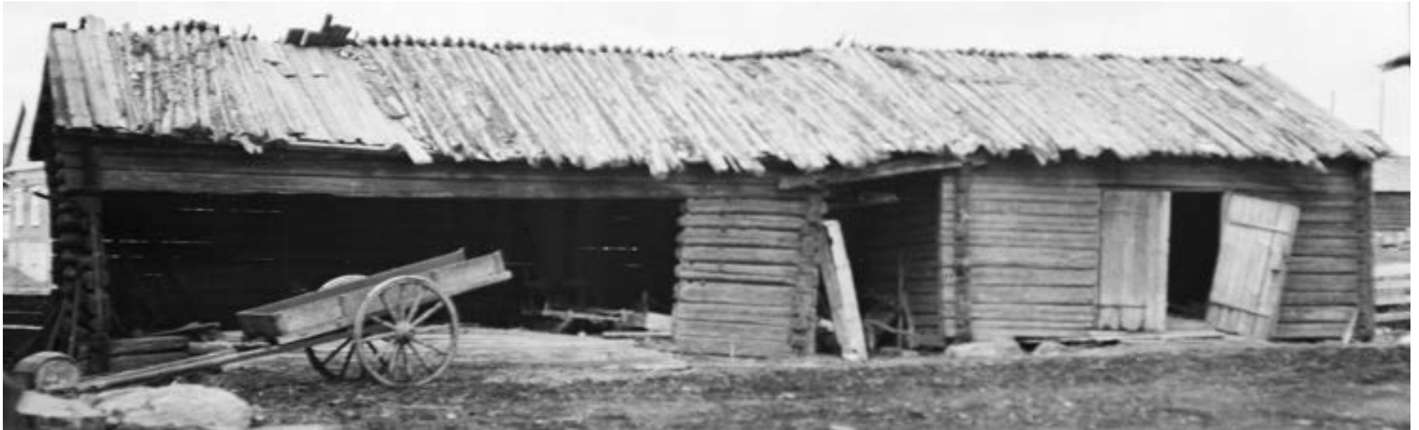
Säkylässä ratashuoneiden edessä oli loivat rampit. MV, KK18S:209.
