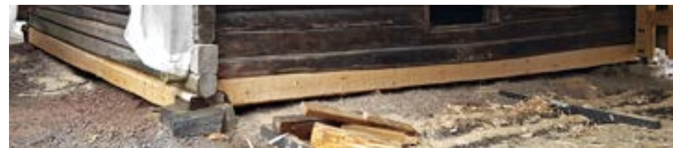
Alimmaisena oikealla: Kellarin luoteissivun maahirren koillispääty vuonna 2022.
