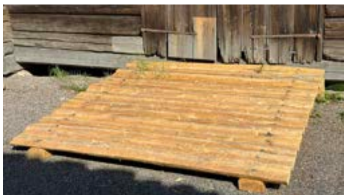
Kirkkoratashuoneen ramppi vastavalmistuneena.
