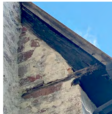
Länsipäädyn uloin kattotuoli ja alapaarteiden päävät näkyvät julkisivussa. Tornin pohjoispuo- lella alkupeäiset puosot on suojattu laudoin.
