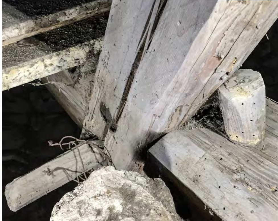
Alapaarteet on tapitettu jalasparruihin ennen ulompien pöngkien asentamista paikoilleen.
