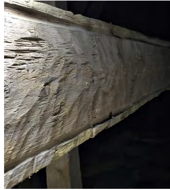
Kierrätysosana on käytetty sprätthuggning-tekniikalla veistettyä katelautaa, johon on höylätty vesiuurat.
