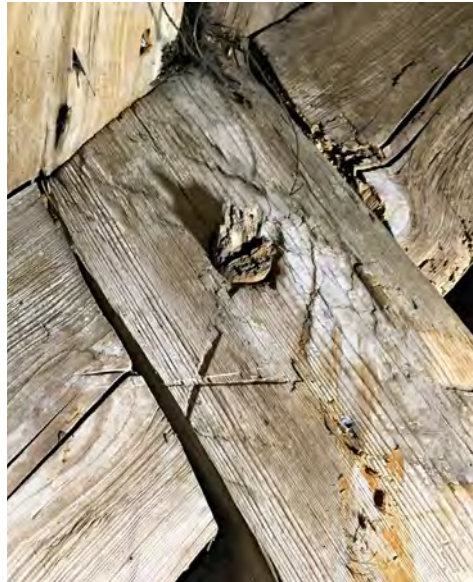
Selkäpuun ja pönkä on yhdistetty suoralla lapaliitoksella, joka on tapitettu ja kiilattu. Liitosmerkki jatkuu rakennusosasta toiseen.
