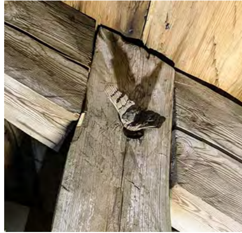
Liitosten tapitus on uudestaan koottaessa tehty "väärältä" puolelta. Tapitustekniikat vaihtelevat: osa tapeista on kiilaamisen lisäksi sälöytetty, osassa kiila on tehty sievästi pienestä rungosta. Keskimmaisessä kuvassa liitokseen on tapin ympärille kaiverrettu pentagrammi.
