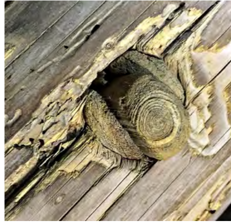
Liitosten tapitus on uudestaan koottaessa tehty "väärältä" puolelta. Tapitustekniikat vaihtelevat: osa tapeista on kiilaamisen lisäksi sälöytetty, osassa kiila on tehty sievästi pienestä rungosta. Keskimmaisessä kuvassa liitokseen on tapin ympärille kaiverrettu pentagrammi.
