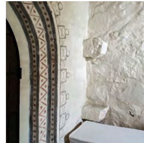
Asehuonetta varten on runkokuoneeseen tehty sidekivet molemmille seinämuureille. Sidekiviä ei ole käytetty ainakaan kokonaan asehuoneen muurauksessa, vaan ne näkyvät asehuoneen ulkoseinien sisäpinnassa.
