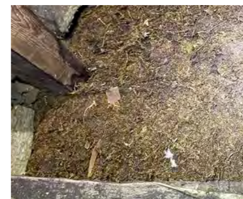
Yläpohjan eristeenä on alapaarteen korkeuden verran, eli noin 8”, sammalta.
