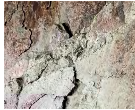
Tulipalon seurauksena päätykolmion kivien sisäpinnat ovat voimakkaasti säilytyneet. Telinepuus-ta näkyy vain hiiltynyt pää.
