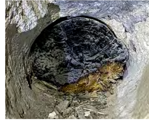
Tulipalon seurauksena päätykolmion kivien sisäpinnat ovat voimakkaasti säilytyneet. Telinepuus-ta näkyy vain hiiltynyt pää.
