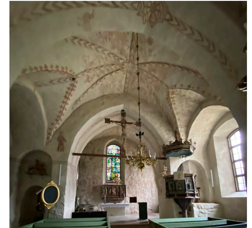
Kapeat sivukäytävät korostavat Finströmin kirkkosalin poikkeuksellisen massiivisia kivirakenteita.
