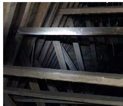
Alkuperäistä kattorakennetta on vahvistettu lisäämällä kattotuolien väleihin uudemmat, samaa tyyppiä olevat kattotuolit.
