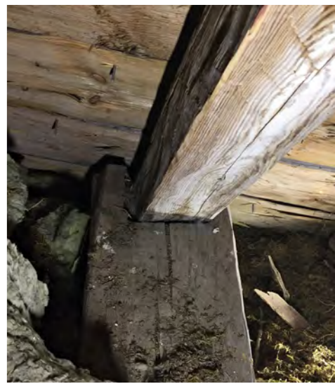
Alapaarteen päälle asetettu, alkuperäistä kattotuolia vahvistava sidepuu on toisesta päästään tapitettu alapaarteeseen kuusenrunkotapilla. Sidepuun toisessa päässä on selkäpuuhun kaksi- leikkeinen liitos, joka on lukittu rautanaulalla.
