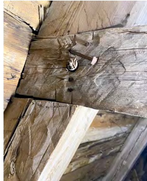
Kattotuoleja uudelleen koottaessa pönkkä on lyöty paikoilleen kirveen hamaralla. Liitosmerkit jatkuvat pönkästä selkäpuuhun.
