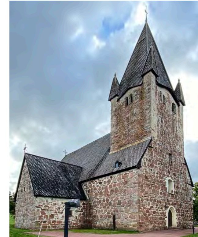
Lännen puoleisessa päätykolmioissa näkyy uloimpien katto- tuolien vaakarakenteita. Muurauksessa näkyy selkeästi muurauksen vaakalinjauksia.
