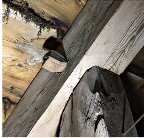
Liitosten tapitus on uudestaan koottaessa tehty "väärältä" puolelta. Tapitustekniikat vaihtelevat: osa tapeista on kiilaamisen lisäksi sälöytetty, osassa kiila on tehty sievästi pienestä rungosta. Keskimmaisessä kuvassa liitokseen on tapin ympärille kaiverrettu pentagrammi.
