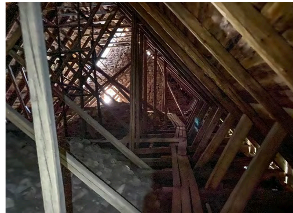
Näkymä vintillä lännen suuntaan. Alapaarteet on katkaistu holvien kohdalla. Kulkusilta on alapaarteiden päällä runkokuoneen muurin sisäpuolella. Kattotuolit on kiinnitetty sisempiin jalasparruihin tapittamalla.
