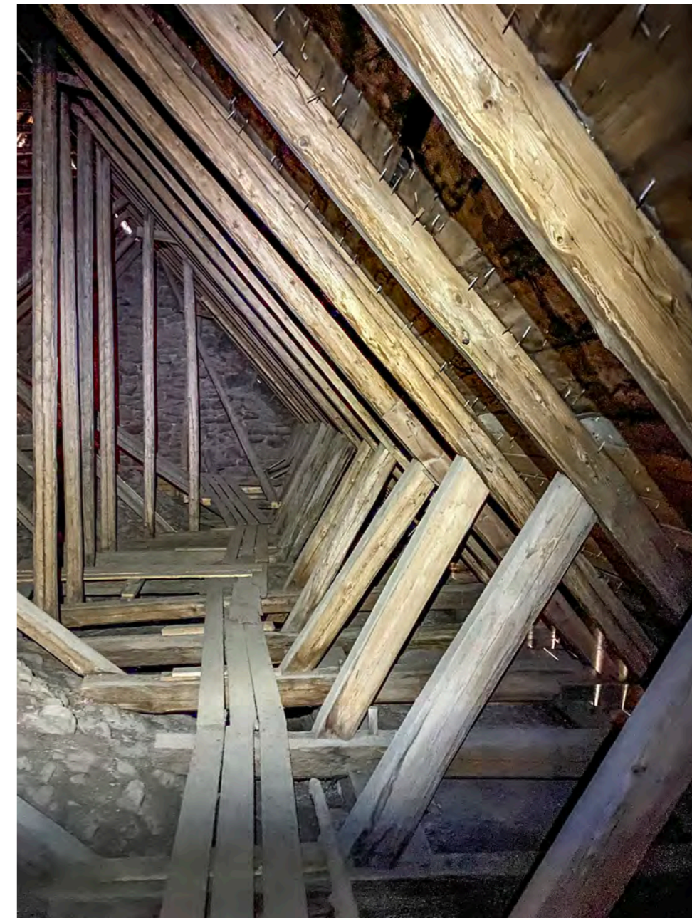
Näkymä vintillä lännen suuntaan. Alapaarteet on katkaistu holvien kohdalla. Kulkusilta on alapaarteiden päällä runkokuoneen muurin sisäpuolella. Kattotuolit on kiinnitetty sisempiin jalasparruihin tapittamalla.
