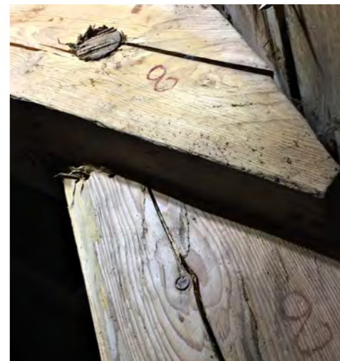
Kattorakennetta vahvistavat, myöhemmin lisätyt kattotuolit on numeroitu punaiselle vahaliidulla.
