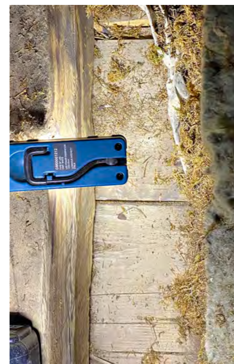
Alkuperäinen laipiolaudoitus on naulattu ala- paarteiden alapintaan.
