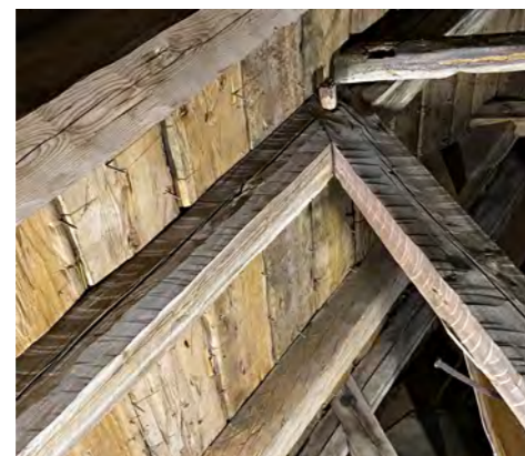
Selkäpuu ja pönkkä on veistetty sprätthugg- ning-tekniikalla.
