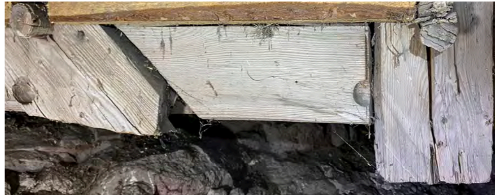
Läpiporausjälkiä näkyy ympäri kattotuolirakennetta, mutta vain pinon seuraavan kattotuolin rakentamisesta.
