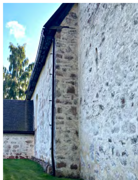
Länsipäädyn uloin kattotuoli ja alapaarteiden päävät näkyvät julkisivussa. Tornin pohjoispuo- lella alkupeäiset puosot on suojattu laudoin.
