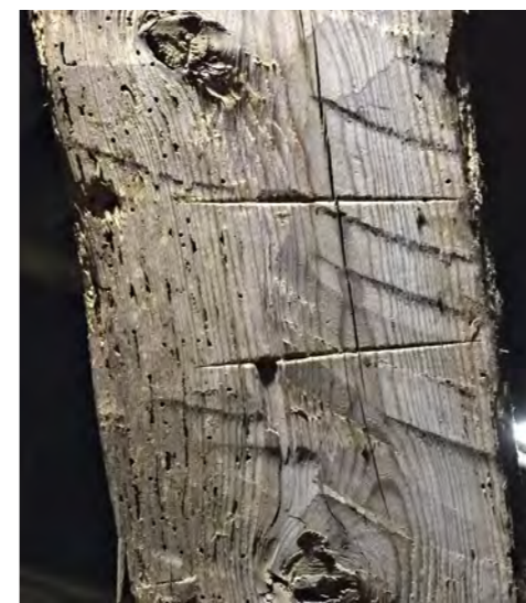
Kattotuolin pönkässä on numerointi.
