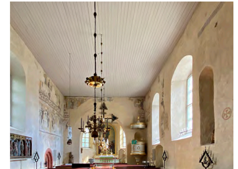
Kirkkosaliin näkyvä tasalaipion laudoitus on naulattu 1950-luvulla alkuperäisen 1290-luvun laipiolaudoituksen päälle.
