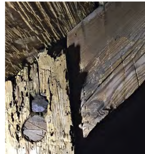
Selkäpuun ja pönkän liitoksessa on kiilattu tappi. Selkäpuussa näkyy veistäjien tekemiä suuntaviivoja pönkälle.
