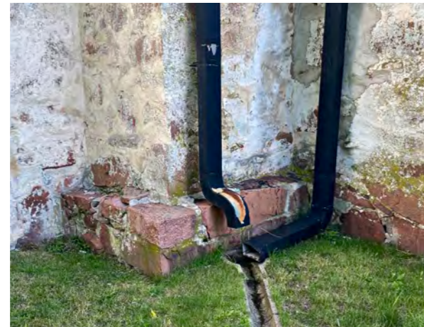
Lemlandin kirkon 1290-luvulla rakennetussa runkohuoneessa on julkisivupinnasta ulkoneva, jatkuva kivijalka. Ulkonevaa kivijalkaa ei ole tehty 1310-luvulla rakennettuihin sakastiin, asehuoneeseen ja torniin.
