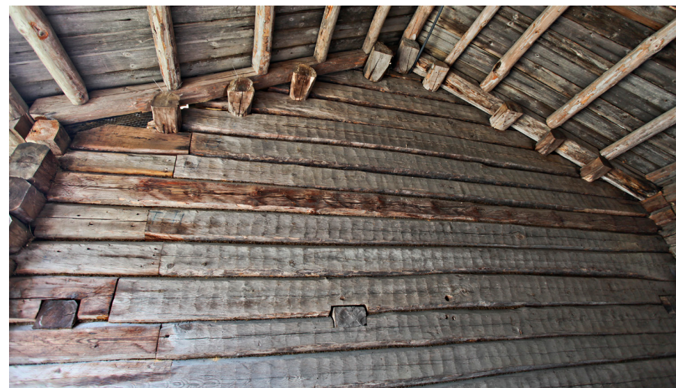
Rakennuksen peräseinää, jossa säilyneet alkuperäiset hirret erottuvat harmaina ja säännöllisesti piiluttuina. Saunan hirsistä on uusittu niin paljon, että esimerkiksi saunassa mahdollisesti olleesta vähälavasta ei ole jäänyt jälkiä.
