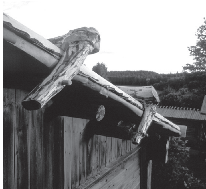
Päärakennuksen painopuiden kiinnityksiä kesällä 2004 (kss)
