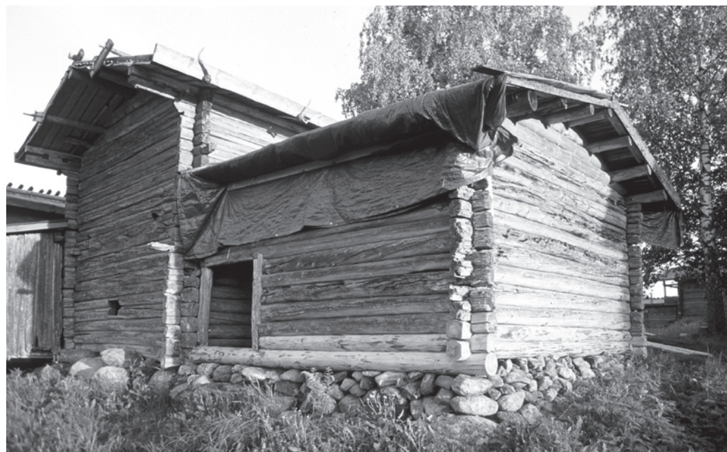
Halkovajan väliaikainen suojaus (kss)
