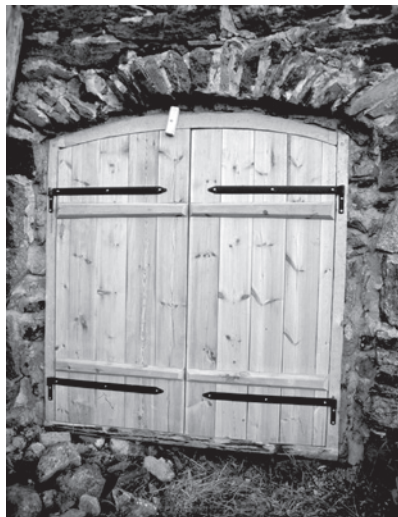
Navetan koillispäädyn uusi ovi (kss)
